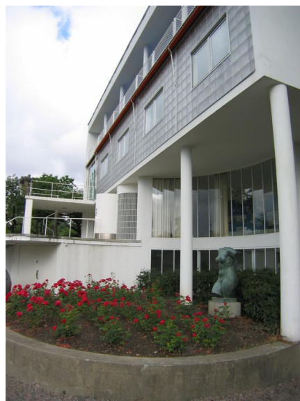
Den spesielle planløsningen og garasjeløsningen i forgrunnen. Opphavsrett: Statsbygg.
