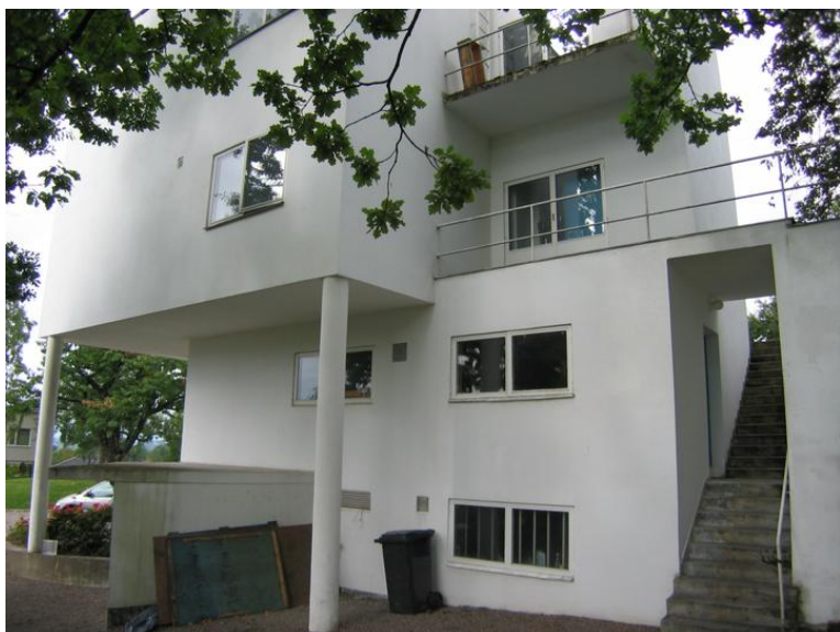
Østfasade, med den integrerte trappen opp til den nordre delen av hagen og kjøkkeninngangen.
