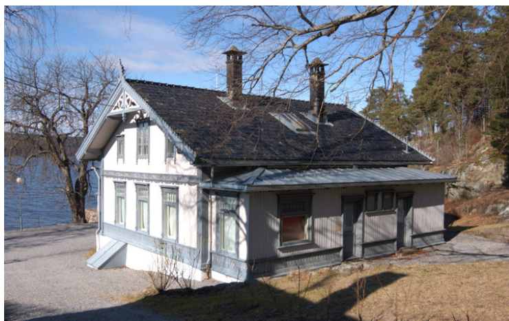
Hovedbygningens fasader mot sør og øst Foto: Anne Sætren, NIKU 2008
