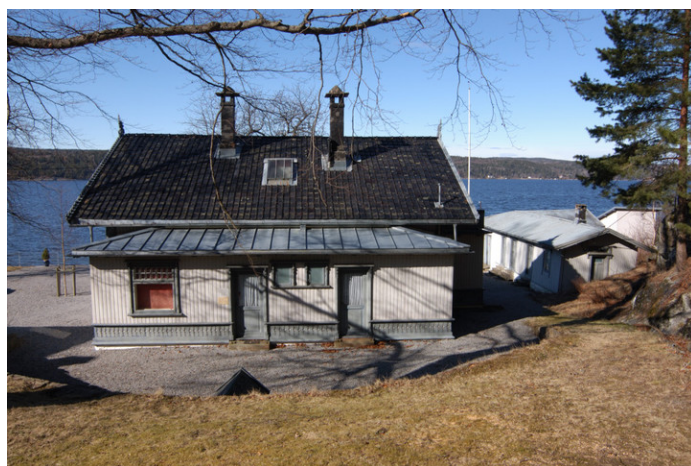
Fasade mot øst Foto: Anne Sætren, NIKU 2008
