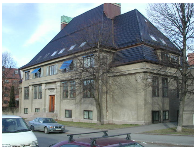
Fasade mot General Birchs gt. Foto: Vlado Trbojevic
