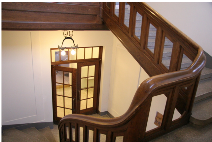
Opprinnelig hovedtrapp Foto: Vlado Trbojevic
