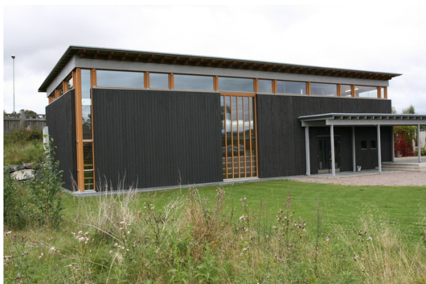
Gymsal. Opphavsrett: Statsbygg.
