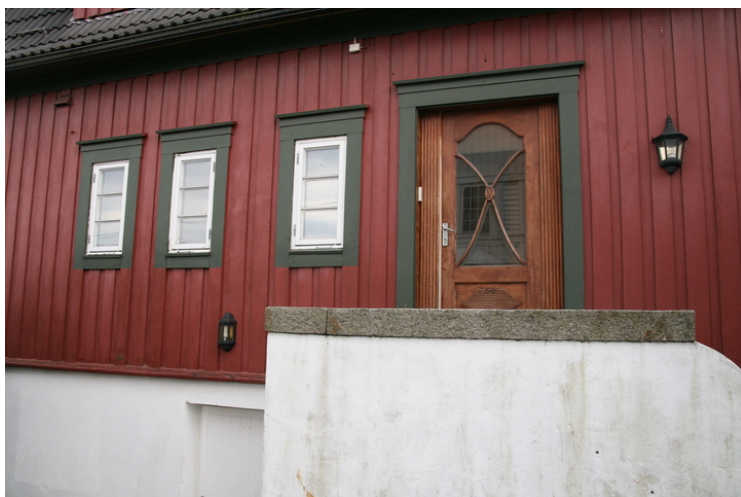
Hovedinngangen er på nordfasaden. Opphavsrett: Statsbygg.
