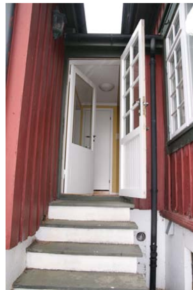
Inngang til annekts direkte fra hagesiden. Opphavsrett: Statsbygg.
