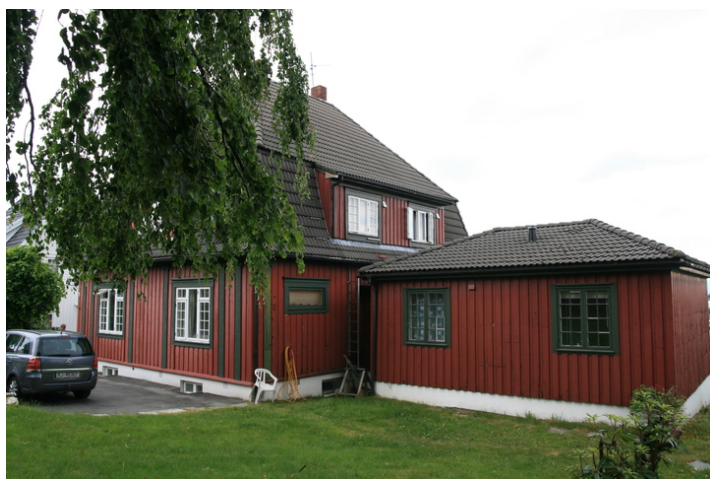
Villa Rød med annekset fra 1961. Opphavsrett: Statsbygg.
