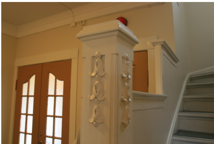
Detalj trapp som går til 2 etg fra hallen. Opphavsrett: Statsbygg.
