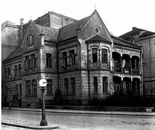
Den eldre villaen på tomten med den nye skolens 1. byggetrinn, ferdig 1926, bakenfor. Etter Statsbygg ferdigmelding 481/1995.
