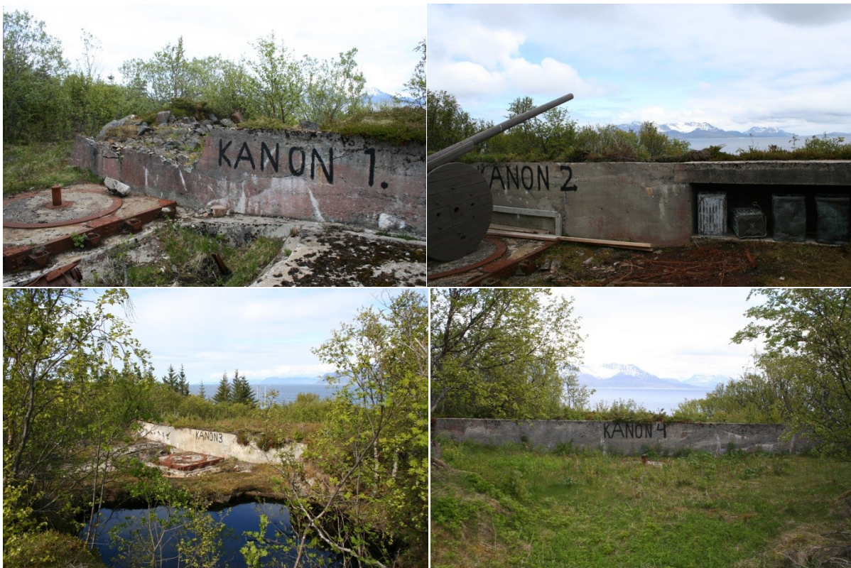
Kanonstilling 1, 2, 3 og 4 for 15,5 cm Geschütze 418 (f). Nr. 2 viser innmurt ammunisjonslager. Nr. 1 og 3 viser tydelige dreieskiver.
