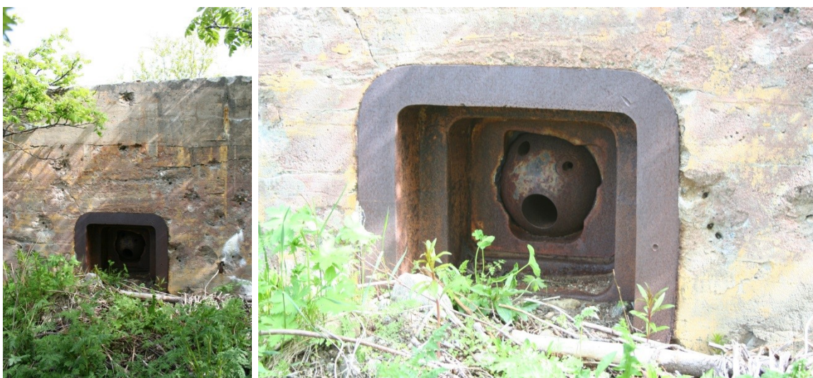
4,7 cm PAK-kanon lengst nord i batteriet, intakt dreiekule i gjenfylt bunker
