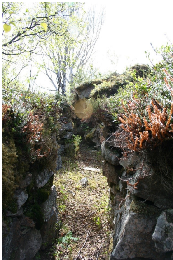
Ulike eksempler på oppmurte og sprengte passasjer for løpegraver og kommunikasjon innad i batteriet. Gjelder også bilder på neste side.
