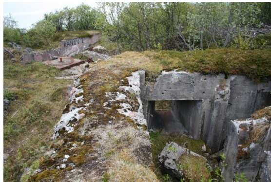
Ulike eksempler på oppmurte og sprengte passasjer for løpegraver og kommunikasjon innad i batteriet. Gjelder også bilder på neste side.
