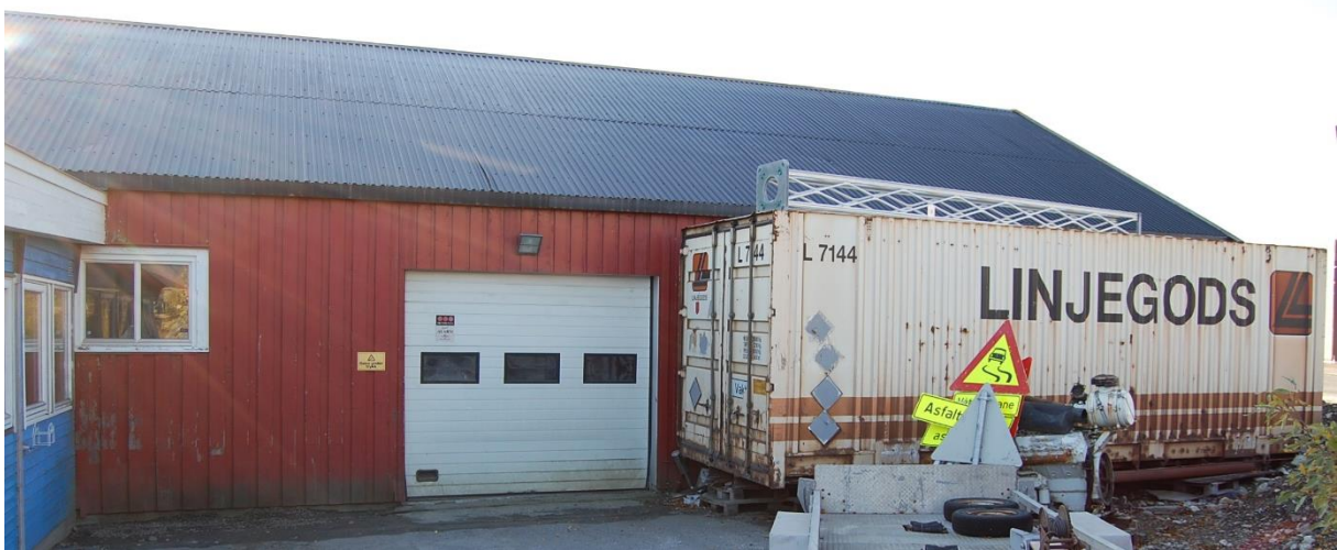
Brakke 4 fra nordvest, øst og nord. Foto: Troms fylkeskommune.
