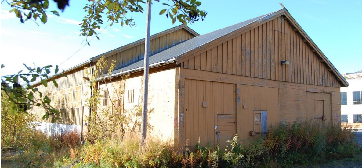
Jernbanebrakkas sør- og vestfasade. Foto: Troms fylkeskommune.
