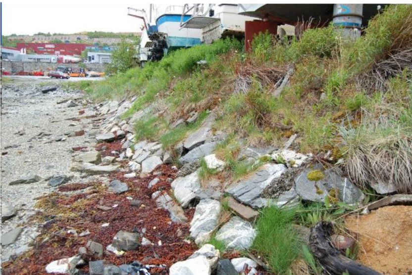
Muren sett mot vest. Foto: Troms fylkeskommune.
