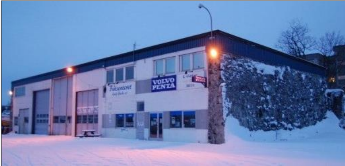
Splintvernmur, integrert i bygg. Foto: Troms fylkeskommune.
