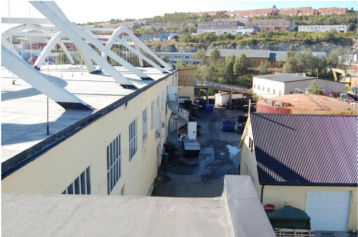
Hangarens tak med betongbuer og nordfasade med pusset fasade og opprinnelige vinduer. Foto: Troms fylkeskommune.
