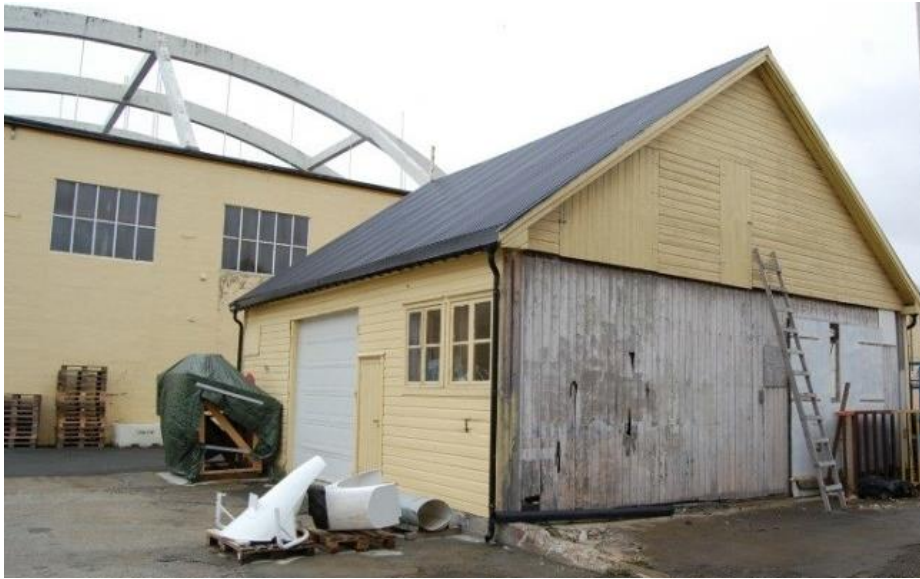
Lageret sett fra nord. Foto: Troms fylkeskommune.
