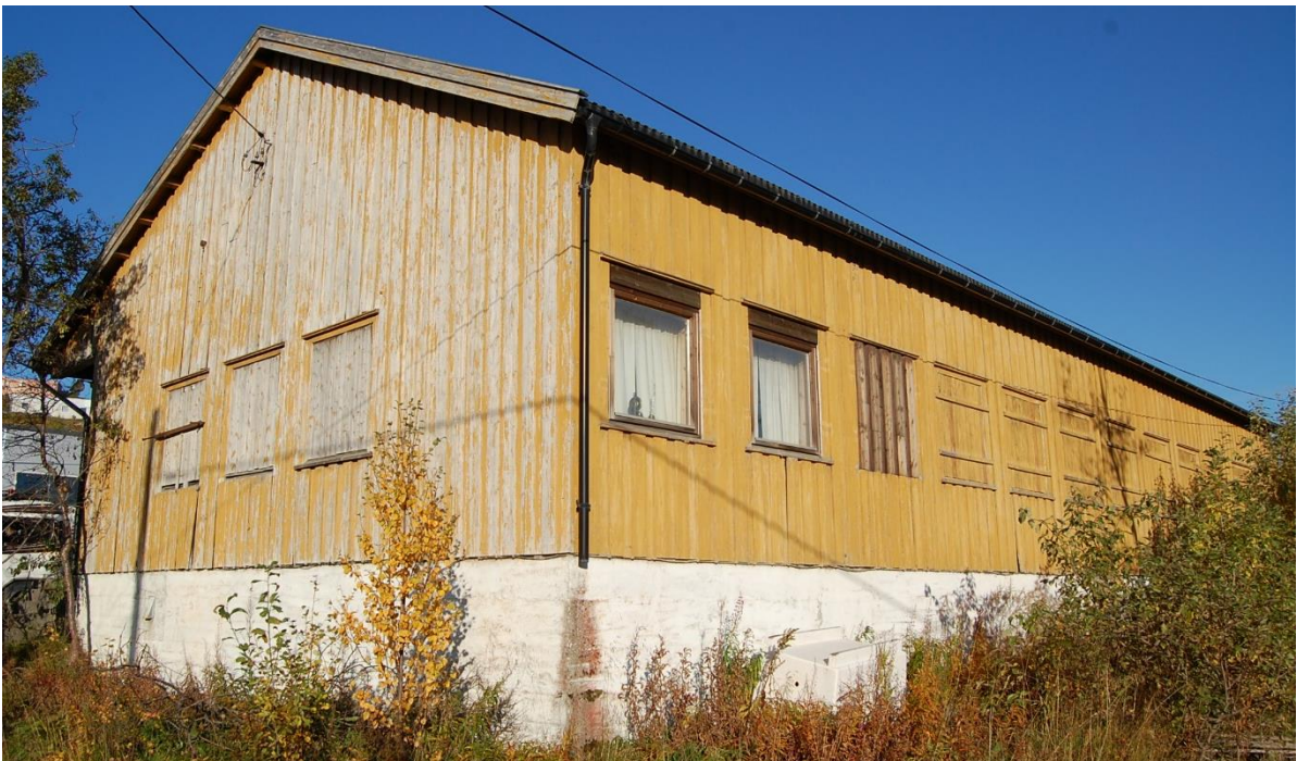
Jernbanebrakkas sør- og østfasade. Foto: Troms fylkeskommune.
