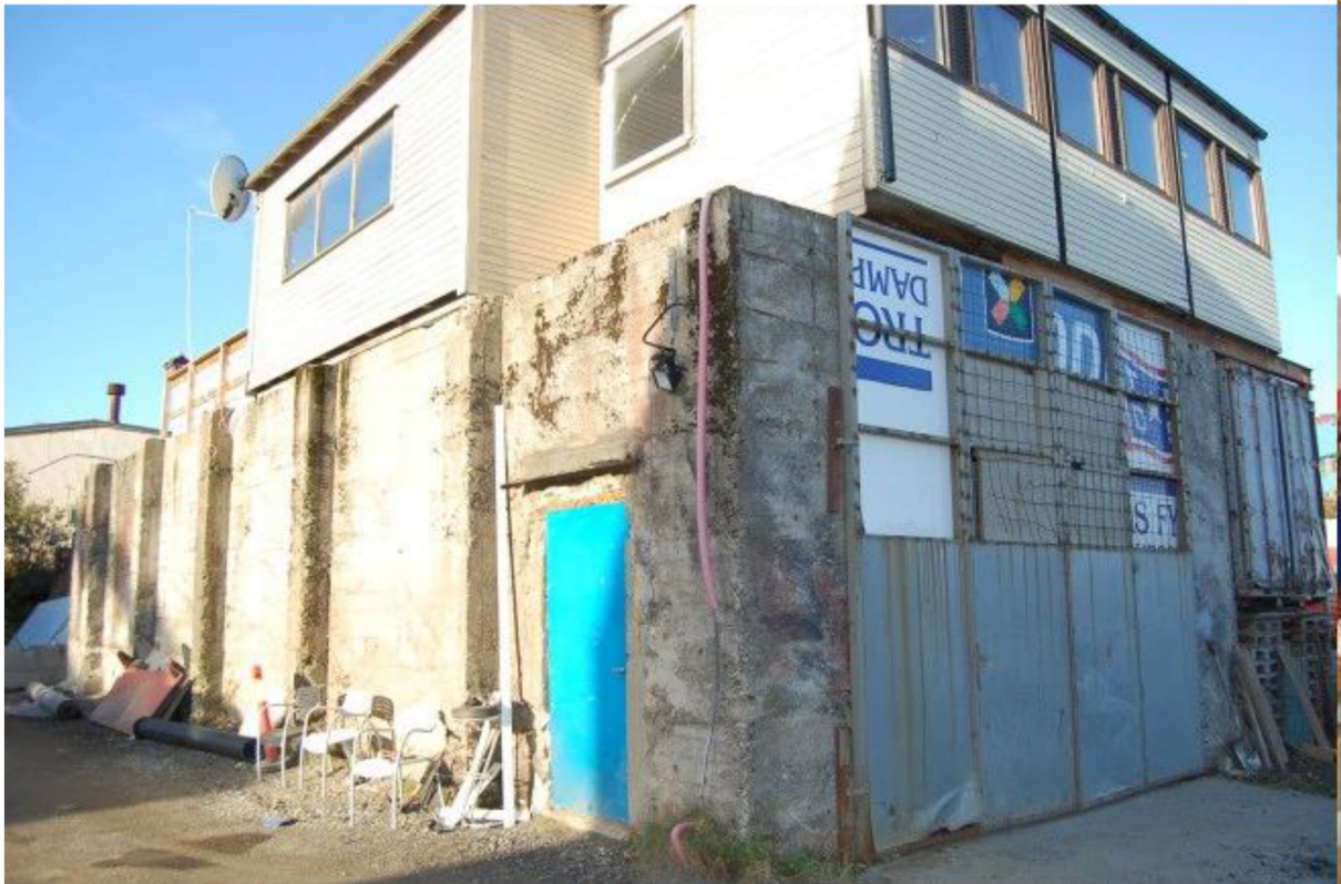
Bunkeren sett fra øst
