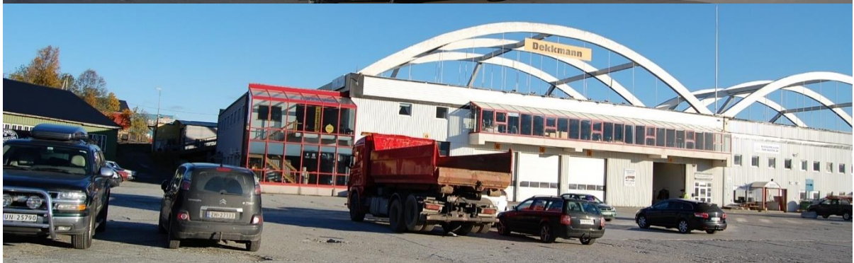
Hangarens fasader mot øst, sør og vest.
