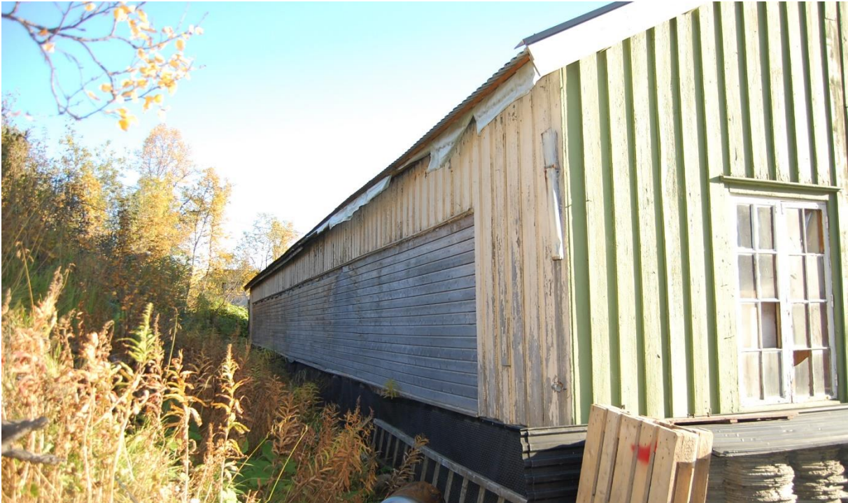
Brakke 2, nordfasade. Foto: Troms fylkeskommune.
