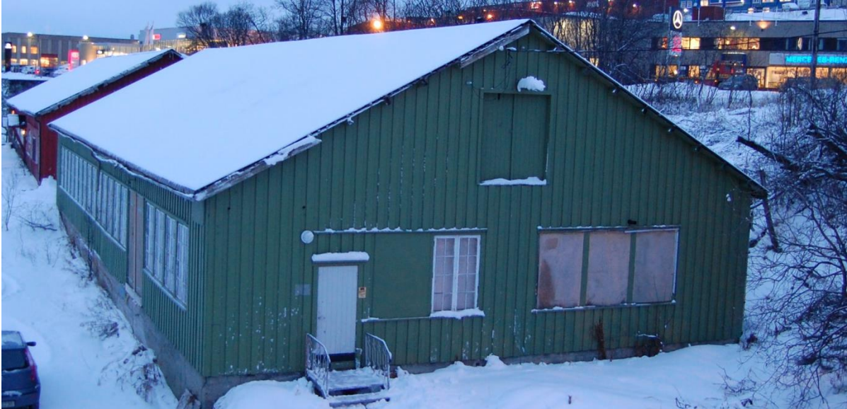
Brakke 2, sør- og vestfasade. Foto: Troms fylkeskommune.
