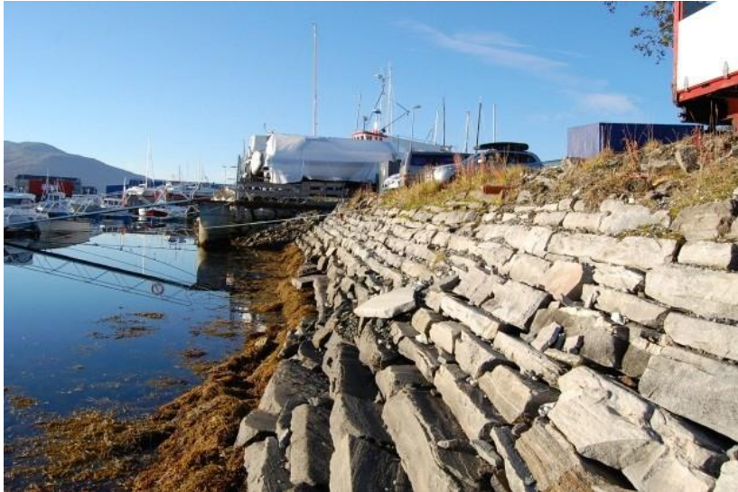
Muren sett mot sør. Foto: Troms fylkeskommune
