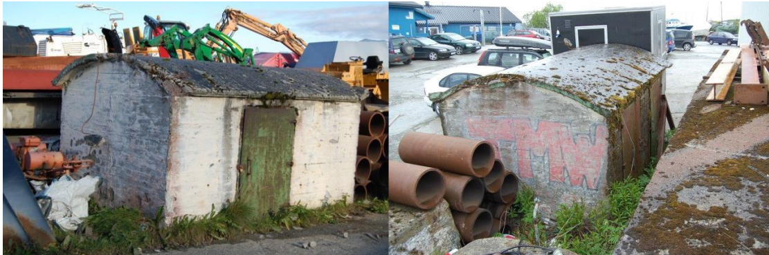
Oljehuset slik det sto øverst på Nordre slipp. Foto: Troms fylkeskommune.
