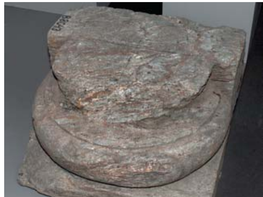
■ Figur 3. Søylebasse frå krypta i Munkeliv. Som følge av at steinen er eit fragment, så ser vi også toppflata som var meint skjult av søyla. Legg merke til hjelpelinene steinhoggaren har lagt inn ved utforminga av søylebassen. Foto: S. Skare, Universitetsmuseet i Bergen.
