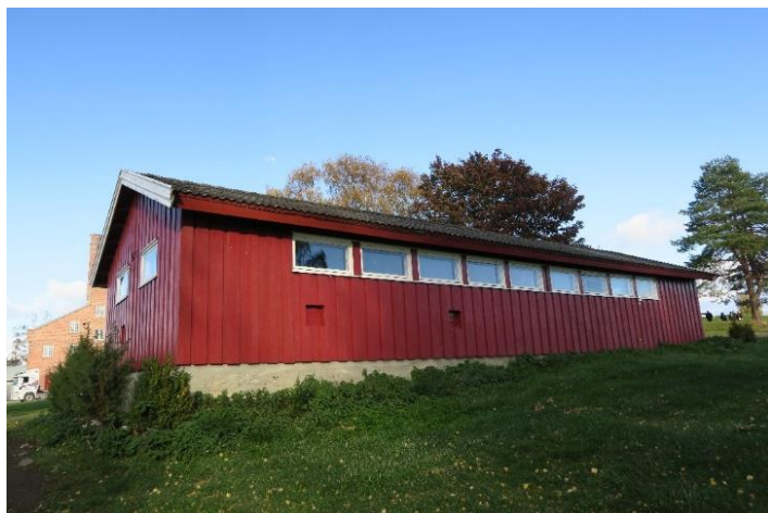
Garasjens gavlsvegg mot vest og langvegg mot sør.
