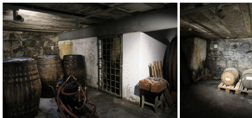
Bygg fra 1880, fatlager. Tv. sett mot fyrrommet i sørøstre hjørne. Th. søndre vegg ved siden av fyrrommet.
