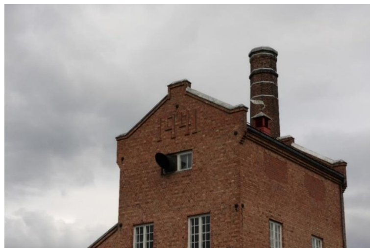
Ett enkelt vindu i toppen av brenneritårnet. Byggeåret for tårnet er skrevet inn som et relieff i mursteinen. Foto: Ulf Gustafsson, Riksantikvaren 2015.
