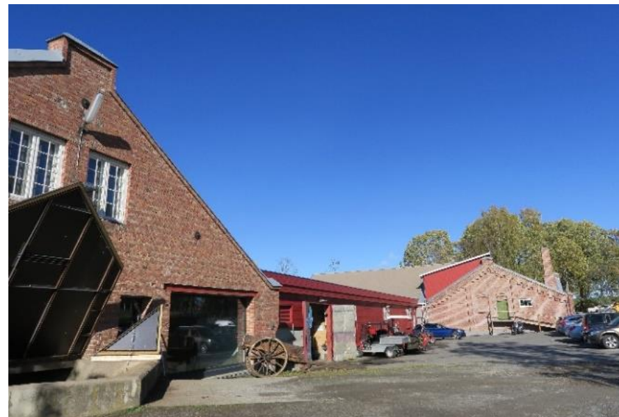
Lokk til tippesjakt står åpen. Til høyre for lemman lå den gamle sjakta for poteter til ensilering. Denne er ikke i bruk ved fredningstidspunktet.
