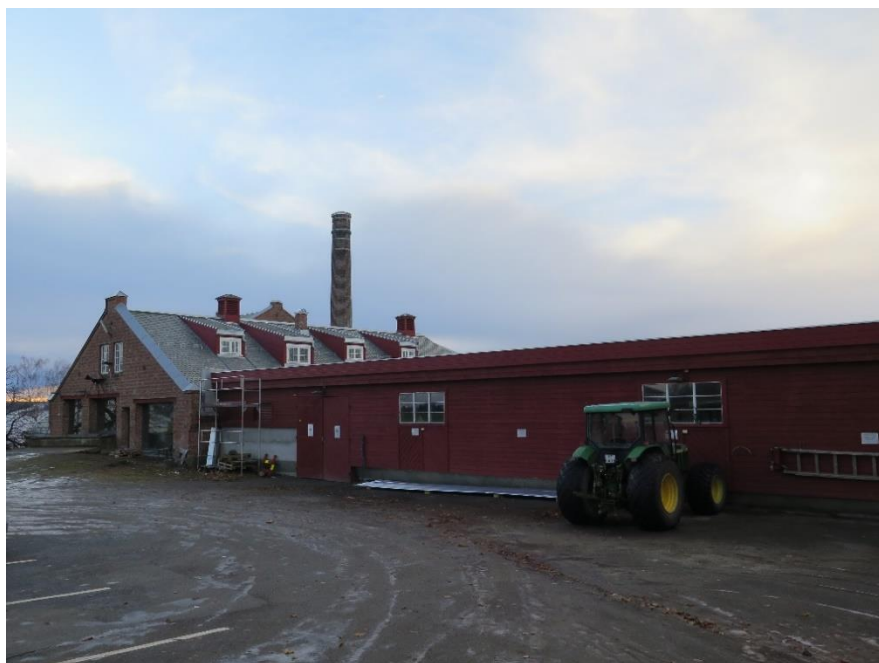
Spritlagerets fasade mot øst.
