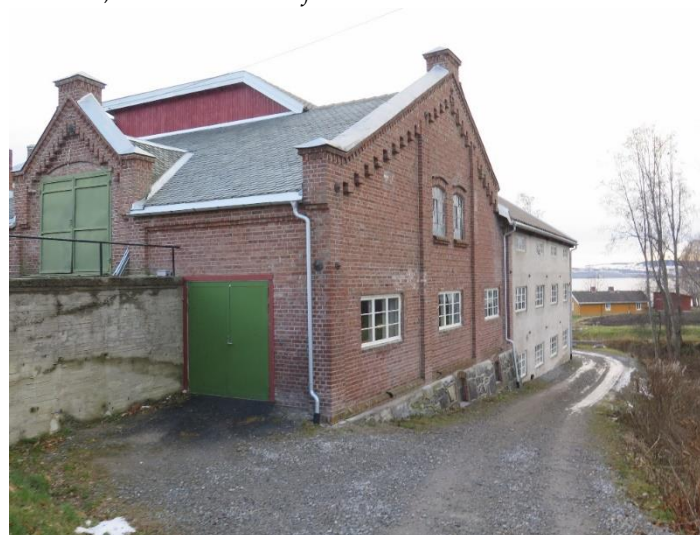
Skillet mellom bygg fra 1954 og 1880 langs nordre vegg er tydelig.
