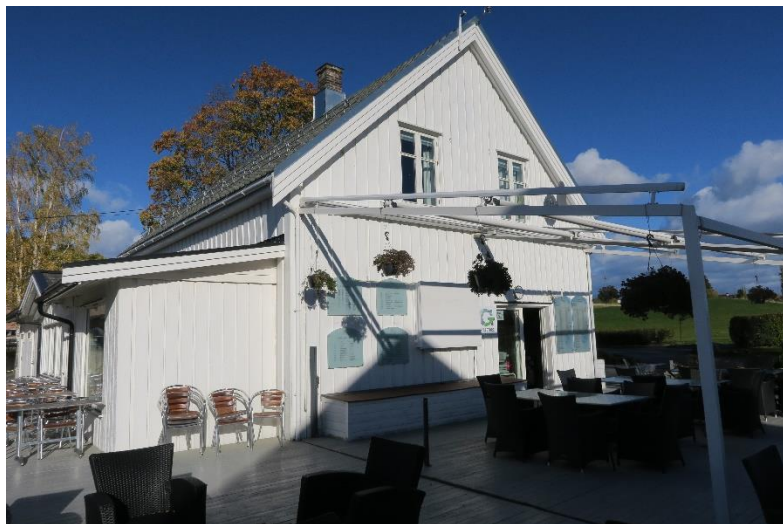
Boligens gavlsvegg mot sør.
