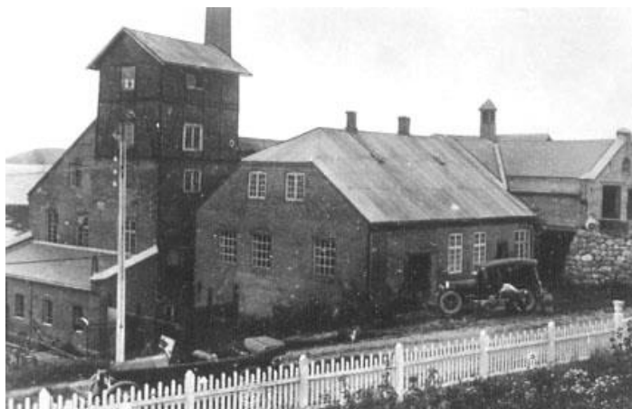
Foto fra 1925 viser utsyn mot fabrikk, fra hagen til Brennerimesterboligen. Stakittgjerde og beplantning skaper et markert skille mellom hage og anlegg, mellom privat og offentlig. Foto: Digitalt Museum, Domkirkeoddens arkiv.
