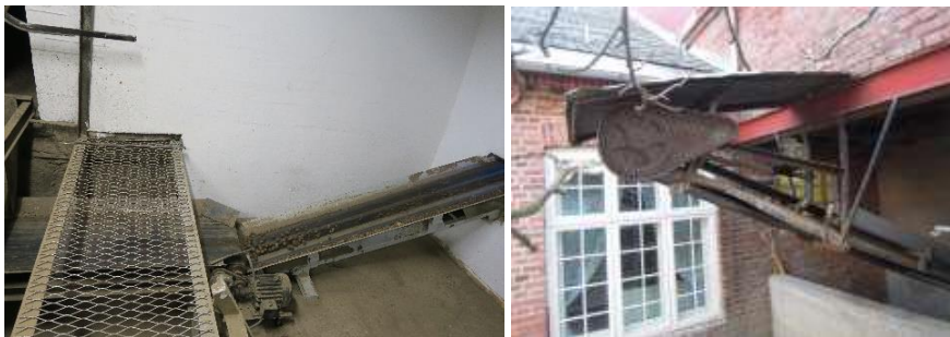
Tv. jord transporteres ut på et samleband. Th. på utsiden av bygget blir jord ført med transportbånd opp i en ventende traktorhenger eller container (vegg mot sør i hjørne mot Kontorbyggets vegg mot øst). Foto: Svein Arne Rudi, HFK
