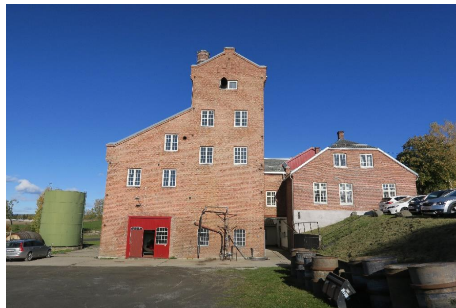
Brenneribygningen sett mot nord.
