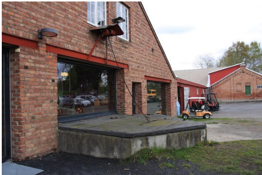
Foto viser vinsj som løfter lokket til tippesjakta ved østre gavlsvegg. Foto: Ulf Gustafsson, Riksantikvaren 2015
