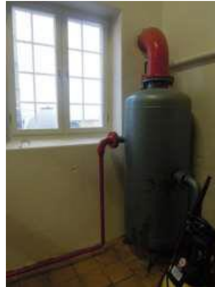
Tv. Blåsetanken. Denne blåser fyrkjelen rein for slagg og avleiringer. Foto: Svein Arne Rudi, Hedmark Fylkeskommune. Th. Sett fra Fyrhuset og inn til Brenneriet, mot øst.
