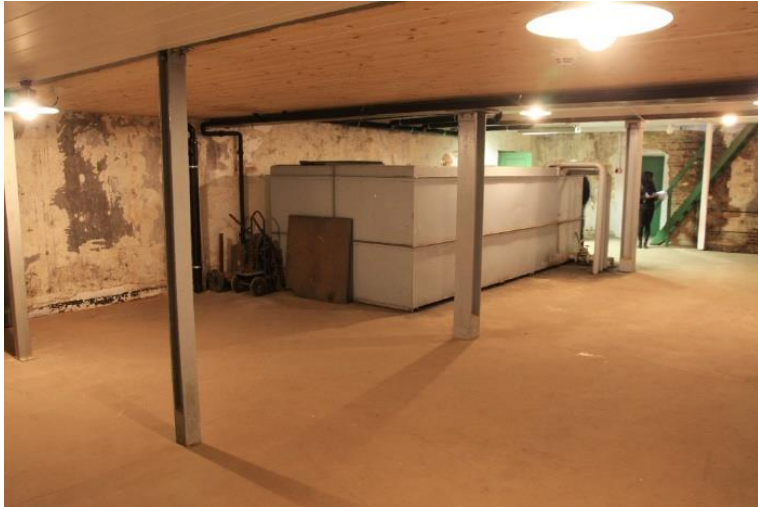
Vanntank i senter av foto og trapper i øvre høyre hjørne ved søndre vegg. Foto: Ulf Gustafsson, 2015
