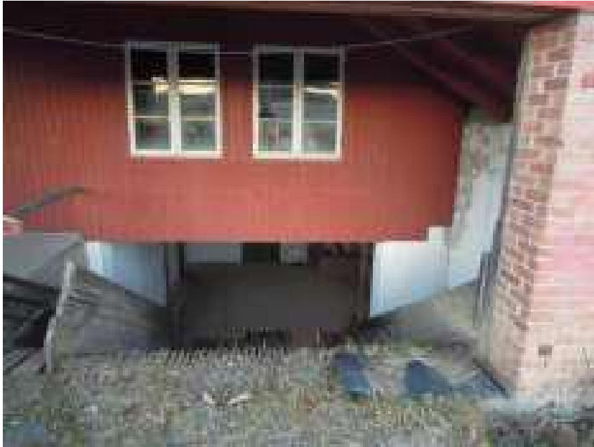
Tippesjakt i vegg mot øst for poteter til ensilering. Foto er fra før ombyggingen i 2014. Se før øvrig foto over av svalgang. Foto: Svein Arne Rudi, HFK
