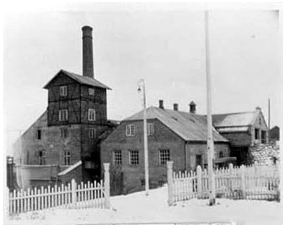
Utsyn mot fabrikkbygningen fra Disponentboligens hage med stakittgjerde og flaggstang. Bildet er fra 1920. Foto: Christian Grundseth, Digitalt Museum, Domkirkeoddens arkiv
