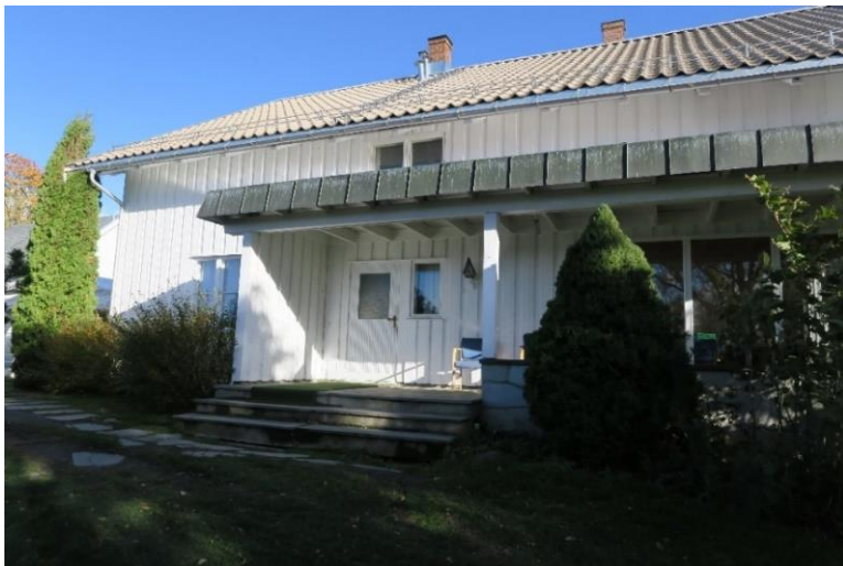
Inngangsparti sett mot vest.
