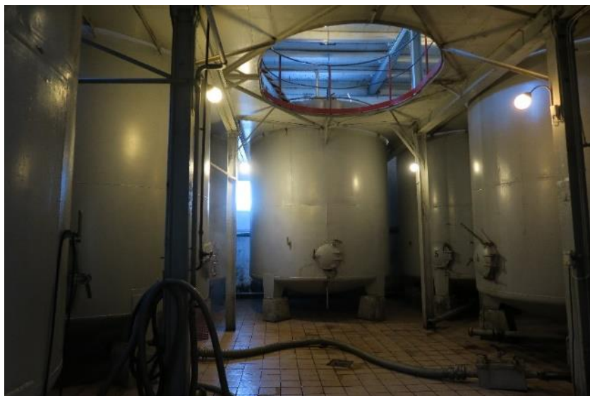
Karene sett mot nordre vegg og fra døra inn til Formeskerommet.
