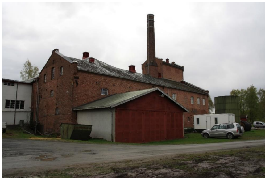
Brenneribygningen nordre gavlsvegg og langveggen mot vest. Foto: Ulf Gustafsson, Riksantikvaren 2015.
