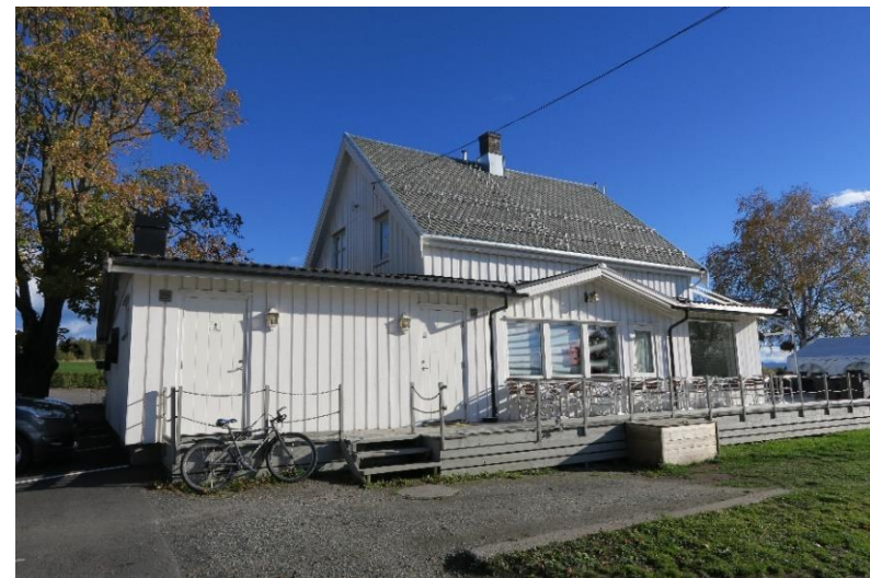
Brennerimesterboligens fasade mot vest, oktober 2018.
