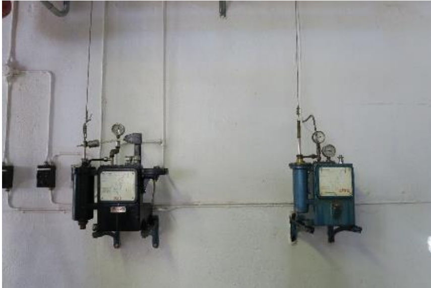
Dampregulatorer for spritapparatet.
