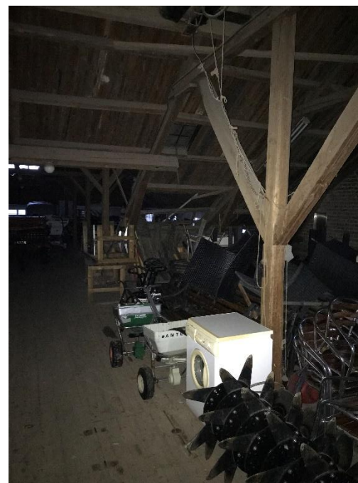
Luke for kornsekker og vinsj i bygget fra 1880.
