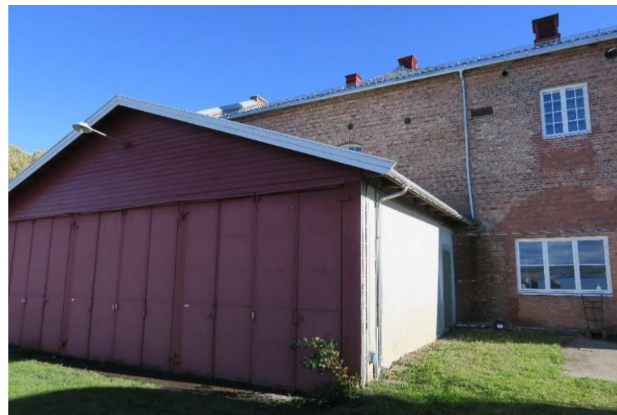
Renseanleggets sørlige betongvegg, sett mot øst.
