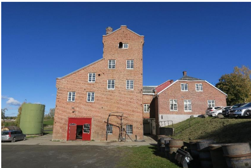
Tanken står vest for fabrikkbygningen. Her sett fra sør.
