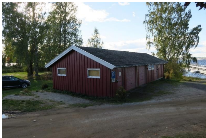
Garasjens gavlsvegg mot øst og langvegg mot nord.
