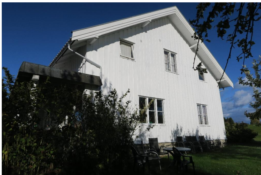
Disponentboligens sørvegg, sett mot nordøst.
