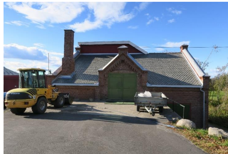
Port inn til tredje etasje i østre vegg.
