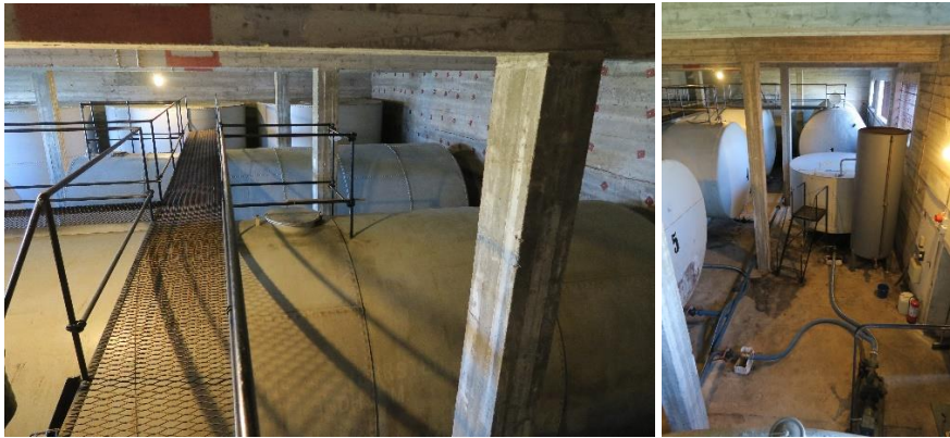
Sett fra gangbro.
