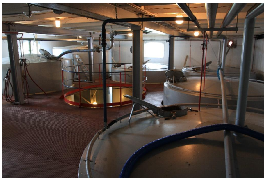
Karrommets andre etasje. Her ses den dreibare koblingen for innpumping av mesk ved tanken til venstre. Foto: Ulf Gustafsson, Riksantikvaren 2015
