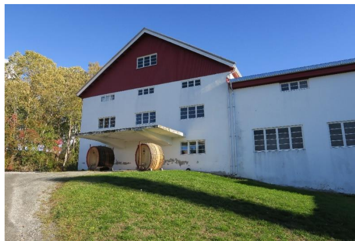
Frørenseri fra 1954, gavlsvegg mot vest.
