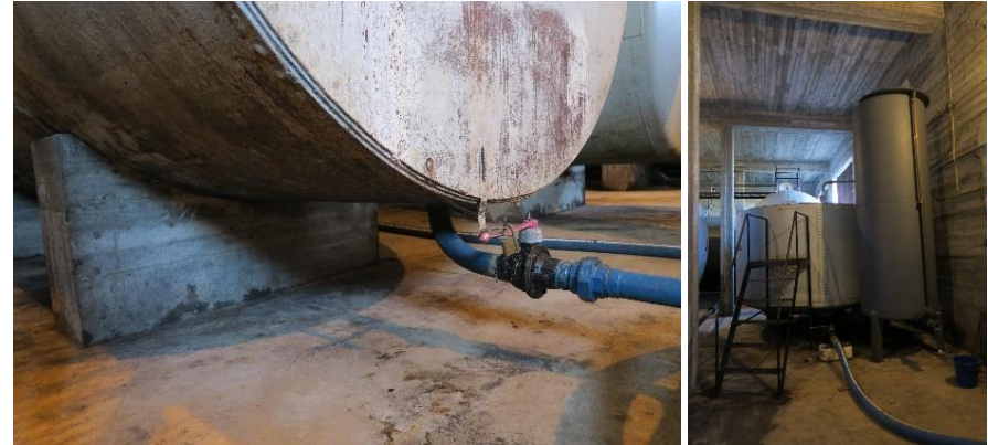
Detaljer. Th. vises den lille frittstående tanken på 3000 l. Denne er ikke tegnet inn på plantegningen.
