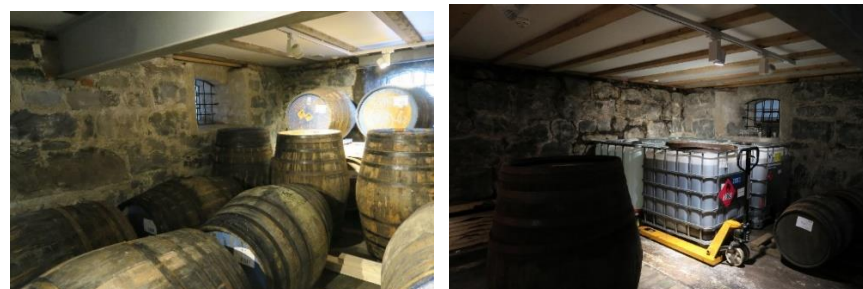
Opprinnelig var det akevittlager her i bygg fra 1880. Ved fredningstidspunktet benyttes lokalet som fatlager. Tv. sett mot nordøstre hjørne, th. sett mot nordvestre hjørne.
