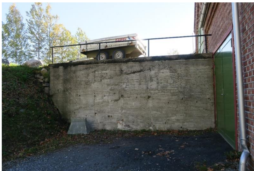
Grønn port i metall i vegg mot øst.
