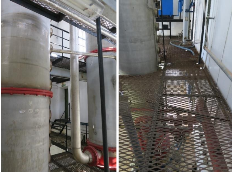
Kolonner og passasjer i strekkmetall.
