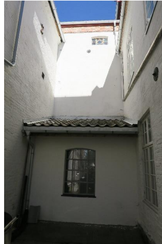
Vegg til høyre er Kontorbyggets vestre vegg.
