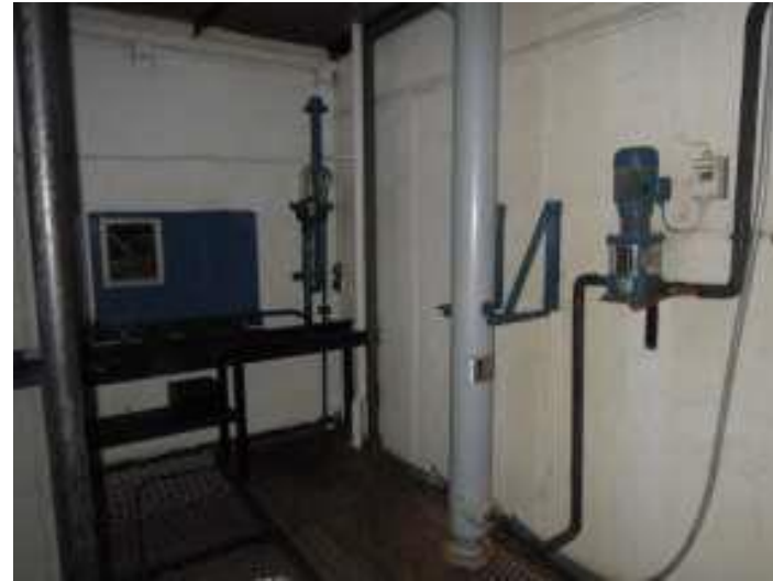
Mengdemåler for sprit til venstre og pumpe for kjølevann til høyre. Foto: Svein Arne Rudi, Hedmark Fylkeskommune
