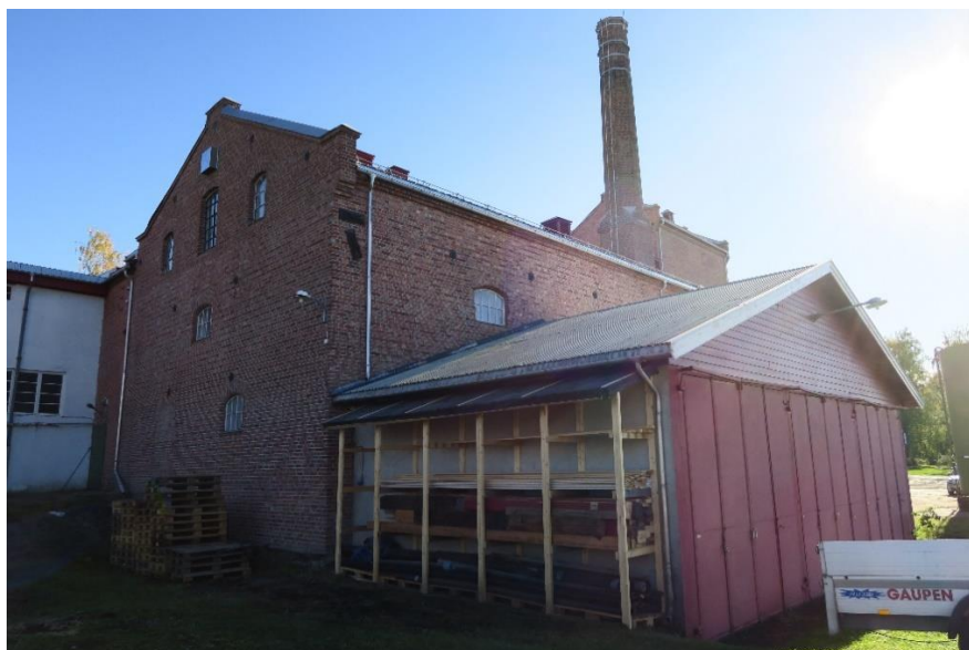
Renseanleggets nordlige betongvegg, sett mot sørøst. Etter 2015 er det satt opp et hyllesystem her for lagring av materialer.
