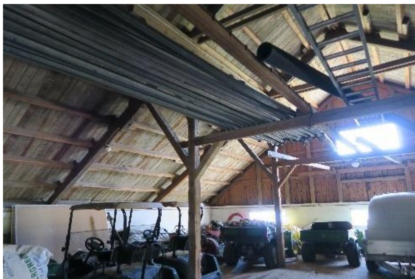
Bygningskropp fra 1954 sett mot vestre gavlsvegg.
