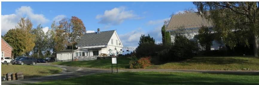
Utomhusområdet, gnr/bnr 41/9, sett mot boligens fasade mot vest.
