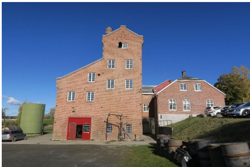
Port med vinduer i fasade mot sør inn til Fyrhuset.
