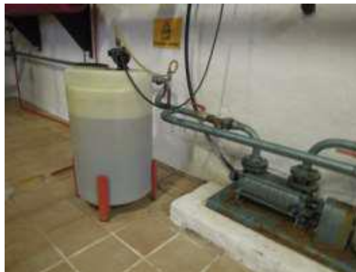
Plasttank for kjestoff som skal forebygge avleiringer i fyrkjelen. Foto: Svein Arne Rudi, Hedmark Fylkeskommune
