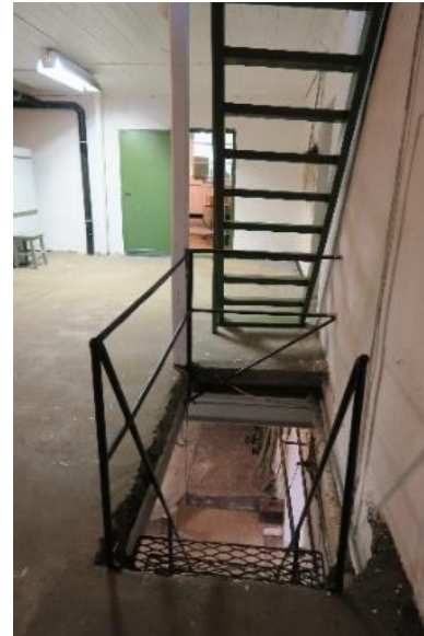
Adkomst til potetkjeller fra Maltrommet.
