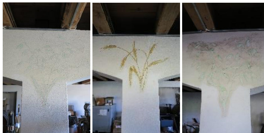
Bygningskropp fra 1954. Søylerekke mot sør med veggmaleri.
