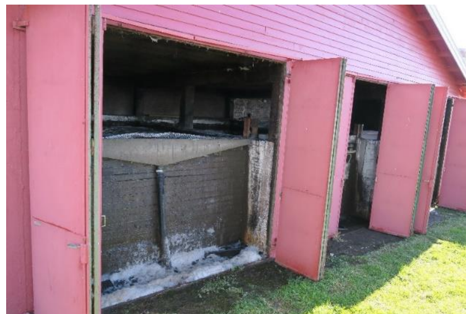
Tre døråpninger med trekkspilldør inn mot kummene.
