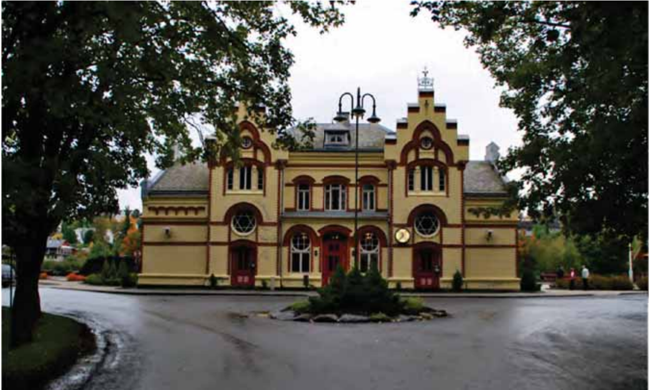
Levanger stasjon i Jernbanegata 14 C i tysk nyrennessansstil, men med stilelementer fra flere stilarter.
