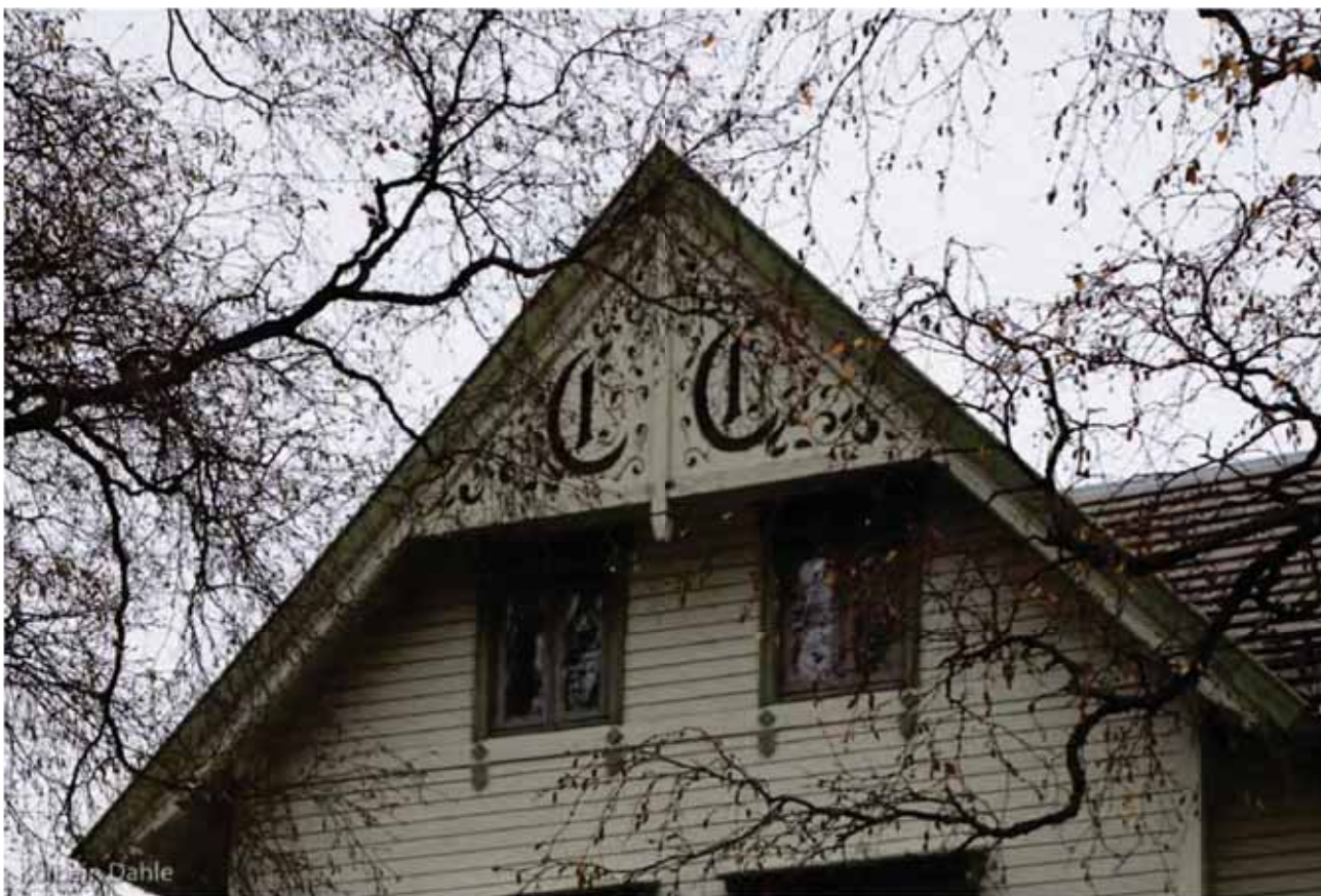
Utskåret mønedekor i Sjøgata 16 B, utpreget eksempel på "snikkargledje", typisk for sveitserstilhusene.
