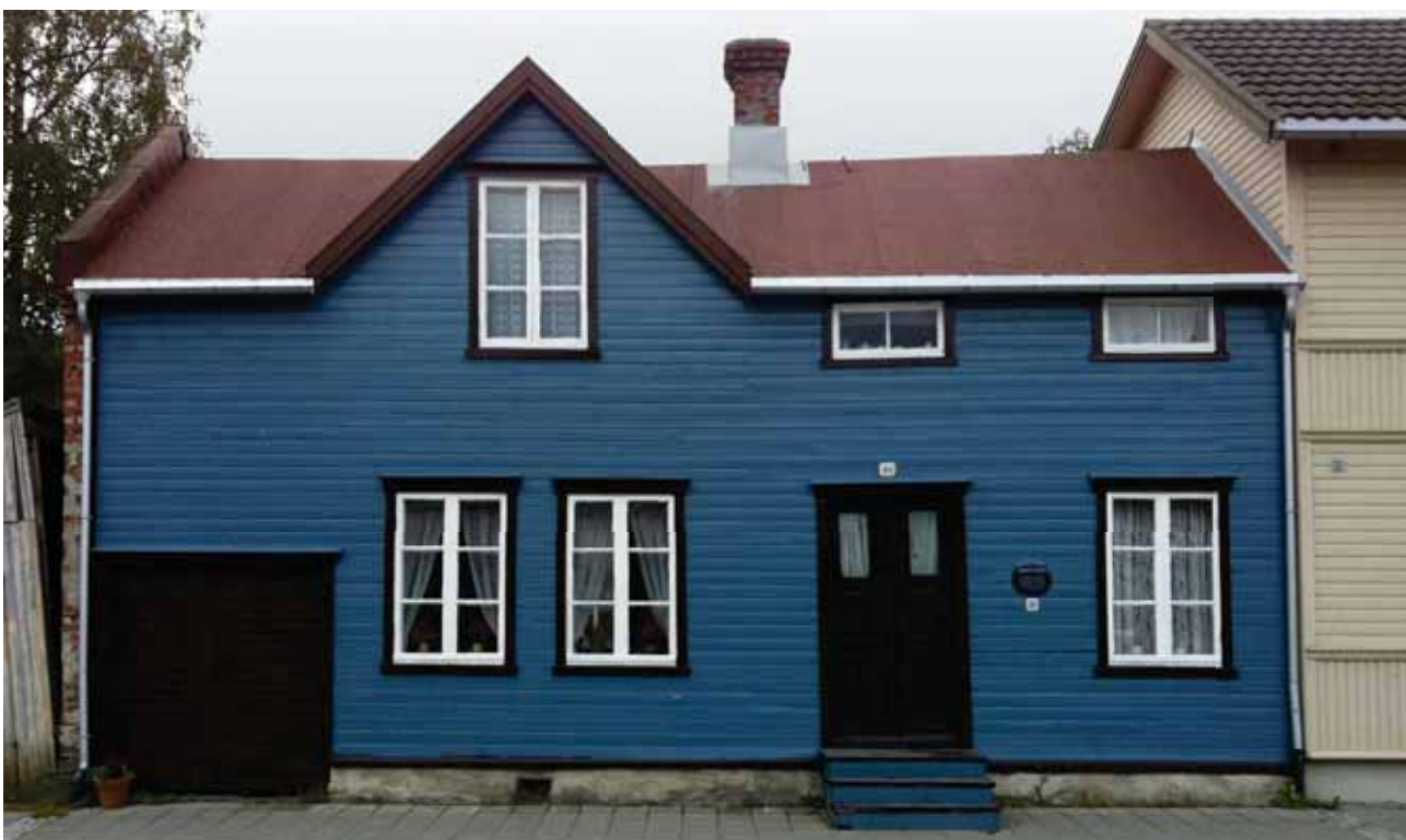
Emilies hus, Sjøgata 40, er også et hus med inspirasjon fra empirestilen, selv om dette er et beskjedent hus og ikke har de store linjene en finner i mer typisk empirebygg. Vindusutformingen finner en igjen i mange typer hus fra denne perioden, ikke minst på stuelånene på gårdene rundt omkring.
