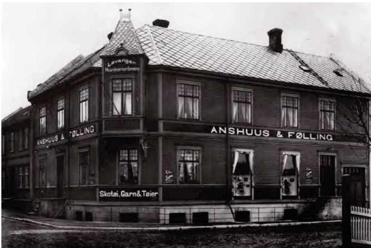
Enkelt rekkverk foran lysgrav. Jernbanegata 17 A
