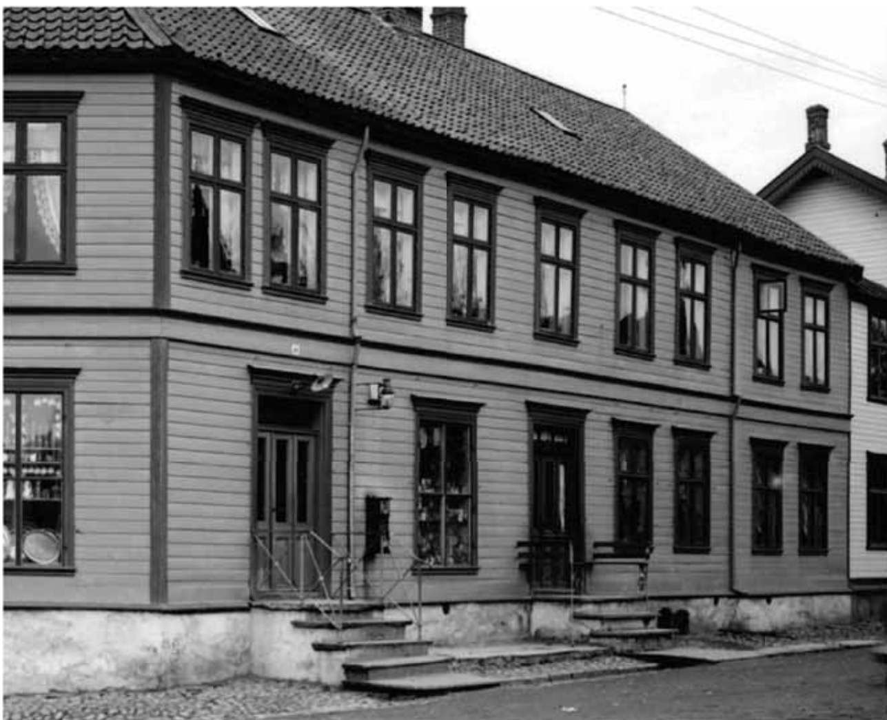
To forskjellige rekkverksløsninger på samme hus, et enkelte rekkverk i stål med et kryss i siden, og ett løst ved benker med smijernsunderstell, Kirkegata 13.
