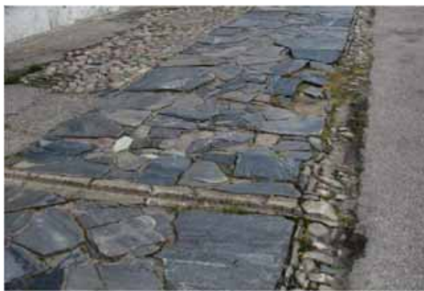
Eksempel på gammelt gategulv/fortau, med gamle materialer, det er vanskelig å erstatte dette med moderne beleggningsstein og betongheller. Dette eksemplet er hentet fra en sørlandsby.
