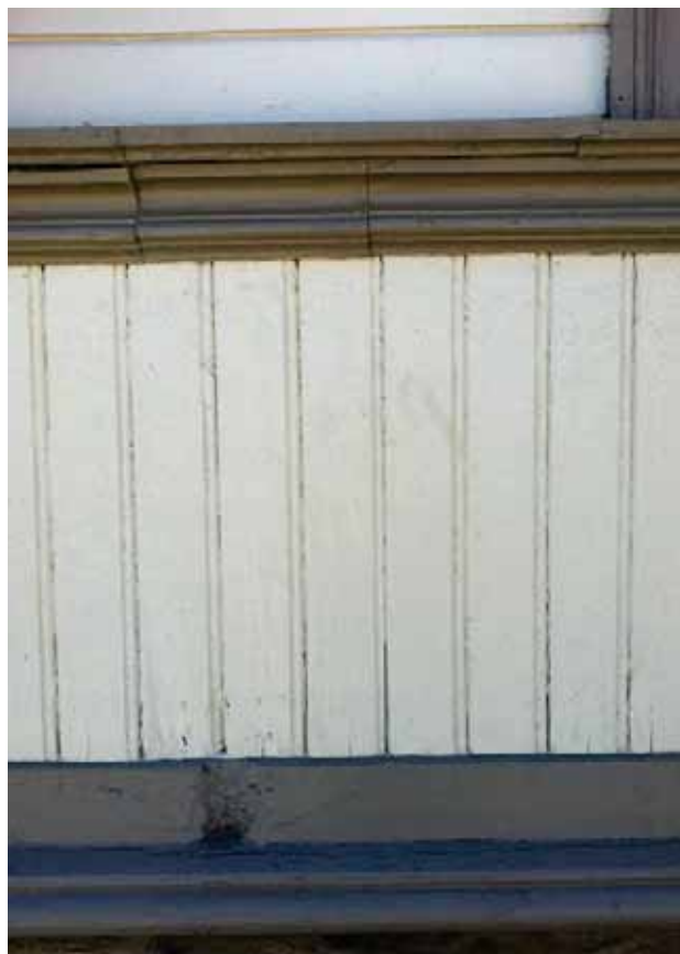
Kirkegata 71, Sveitserpanel (pløyd panel) i bånd, dobbelfalset panel på veggen forøvrig
