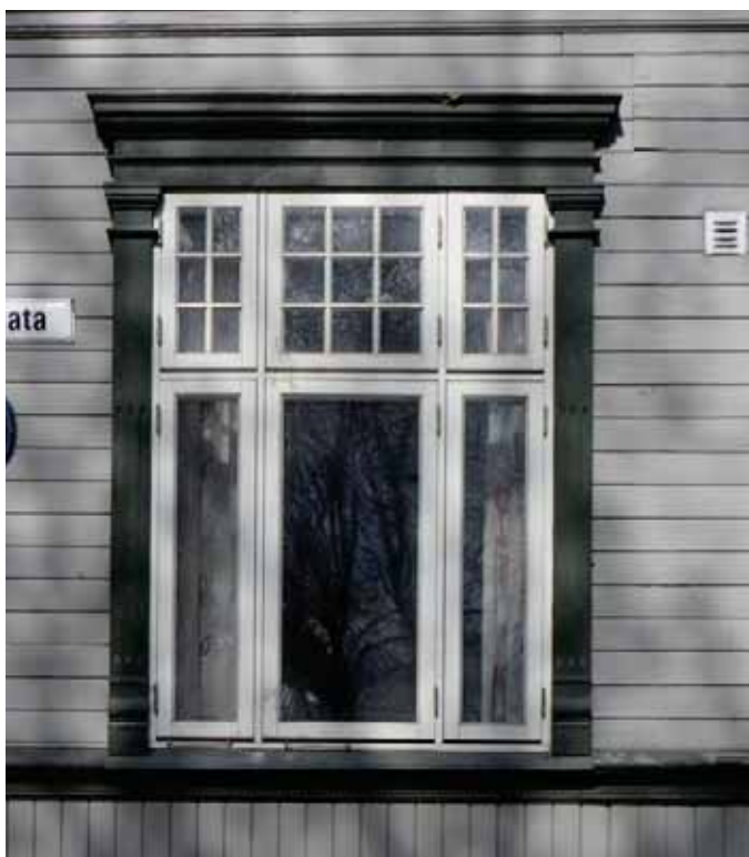
Jugendstilvindu fra "Håndverkeren", Jernbanegata 17 B
