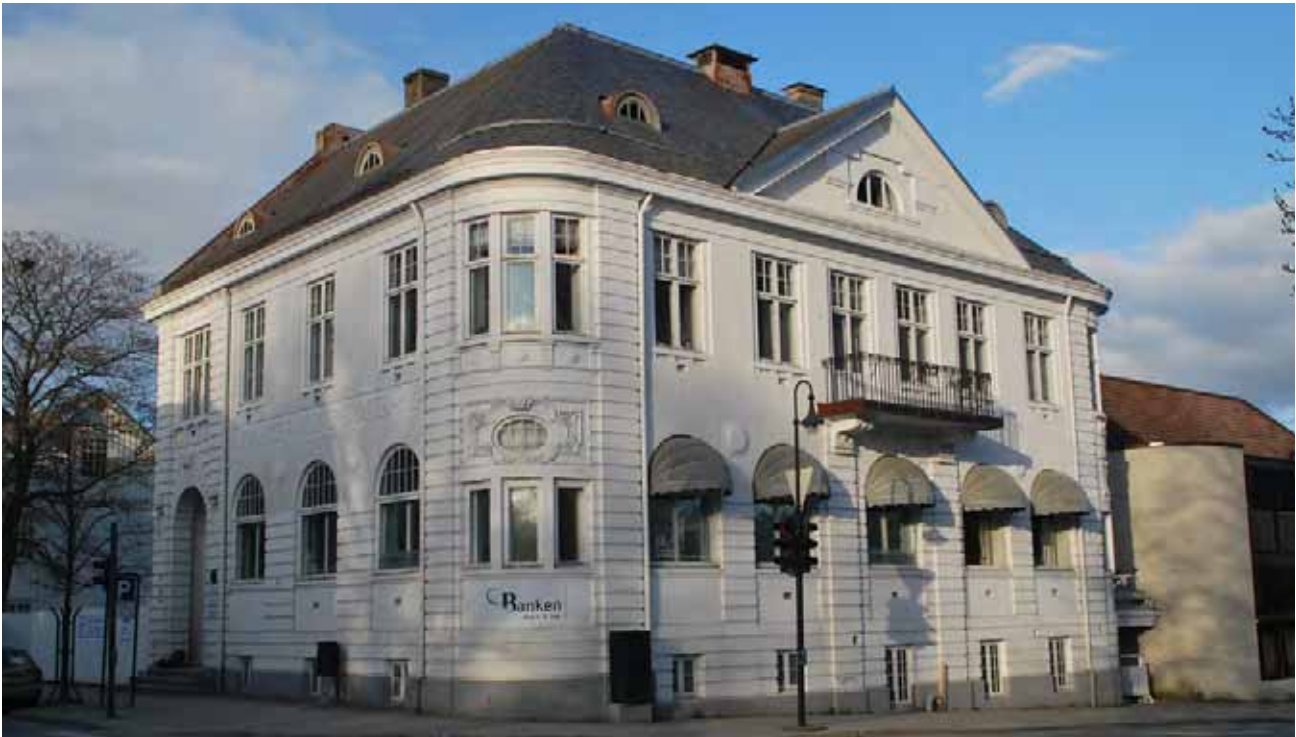
Levanger Sparebank i Kirkegata 50, kanskje det mest typiske jugendbygget i Levanger, med pussdetaljer i fasaden og utsmykning med masker ved inngang.
