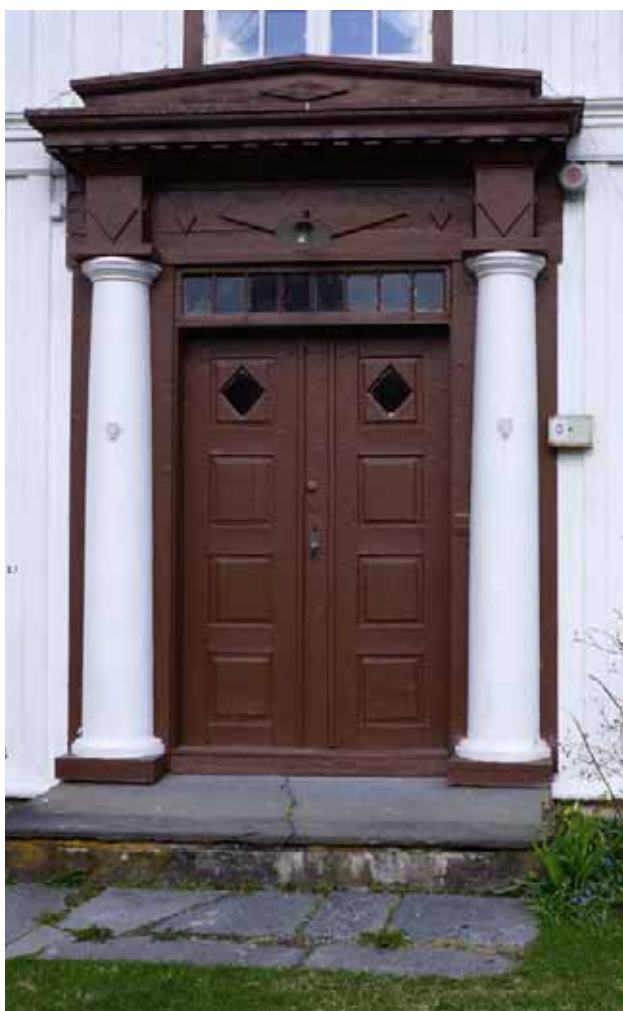
Empirestil dør og vindu fra Brusve gård
