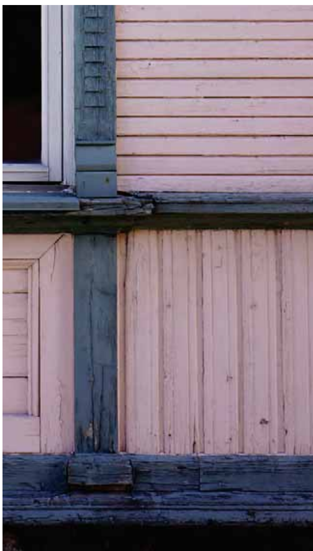
Sjøgata 42 A, dobbelfalsset panel på vegg i kombinasjon med pløyd panel i bånd
