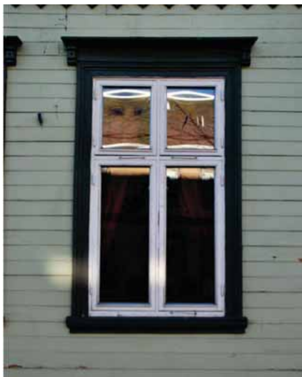
Til venstre er vinduene i Kirkegata 16 B skiftet og erstattet med "moderne" vinduer med samme hovedoppdeling som det gamle vinduet, til høyre ser en det samme for Kirkegat 43. Hovedinntrykket er godt på avstand, men når en kommer nær ser en at det er et moderne vindu.
