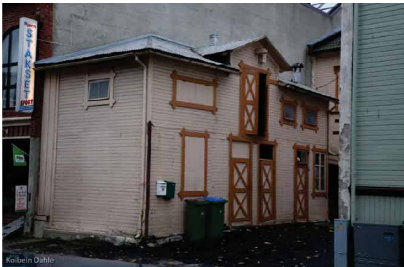
Et typisk uthus i bakgård i Kirkegata 34. Bakgårdsbyggene er viktige for forståelsen av helheten i kulturmiljøet i Levanger.
