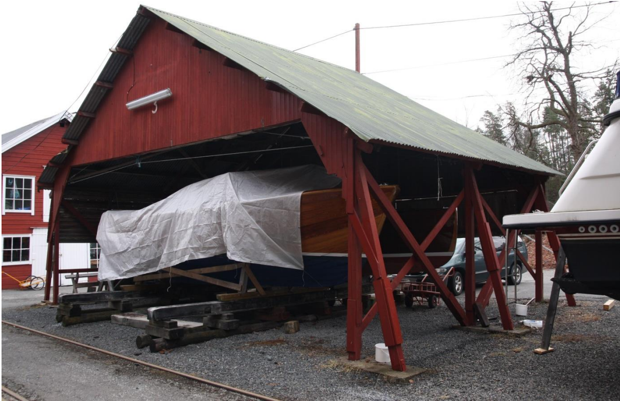
Over: Båtskur 3 med fasade nord og vest. Under: Båtskur 3 fasader og detaljer fra takkonstruksjon. Foto: HAG/RA
