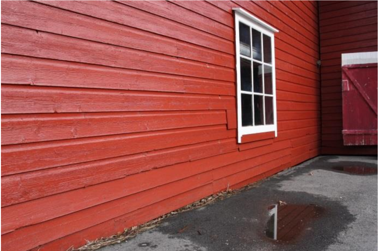
Mastehuset betongfundament og variert kledning. Foto: HAG/RA
