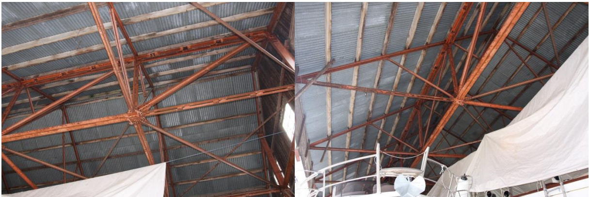
Båtskur 1/verkstedhall, detaljer fra takkonstruksjon. Foto: HAG/RA
