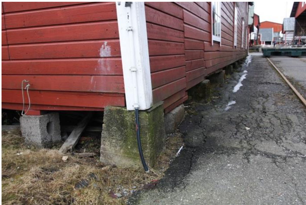
Holmen Yachtværft, Mastehuset betongfundament og variert kledning. Foto: HAG/RA
