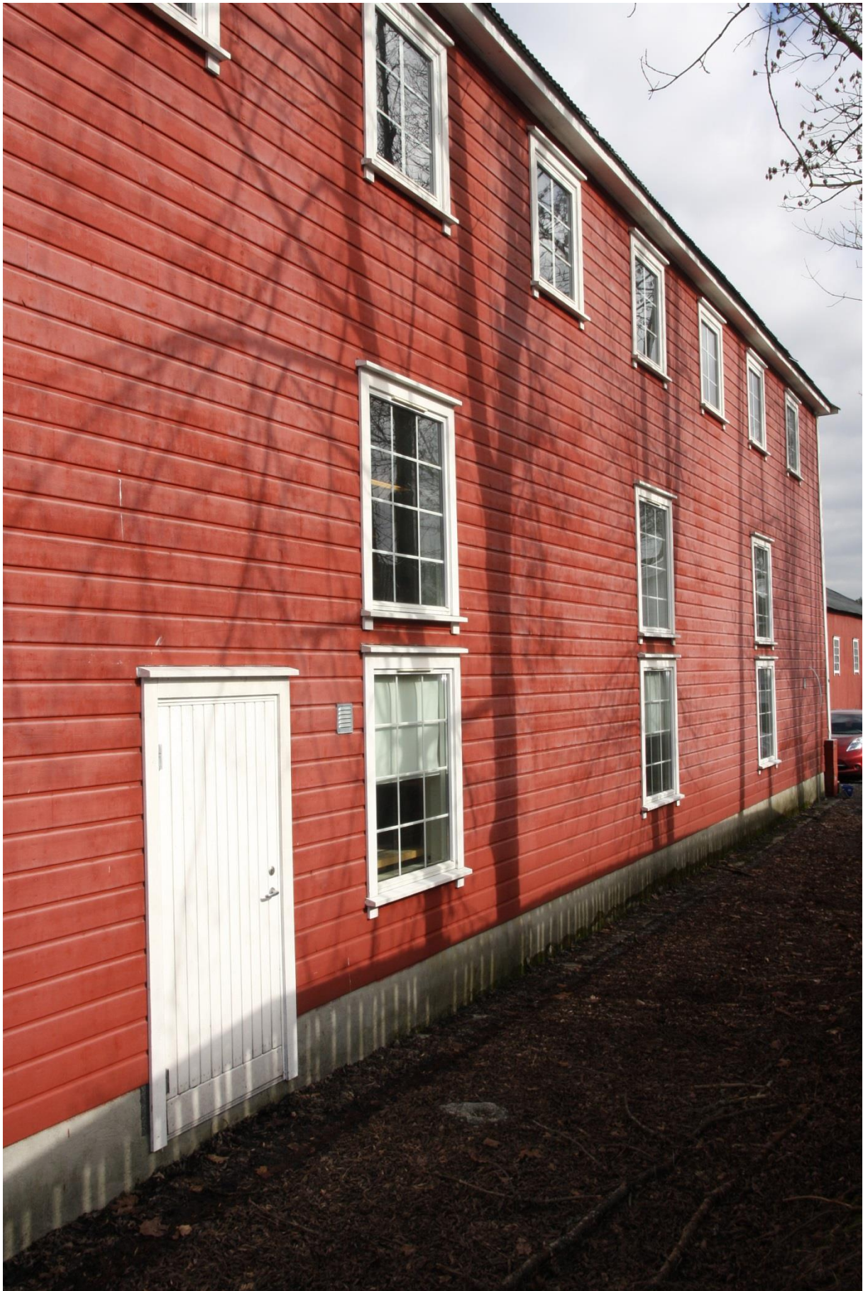
Båtbyggerverksted mot øst. Bygget er jekket opp og har fått nye vinduer og kledning. Foto: HAG/RA
