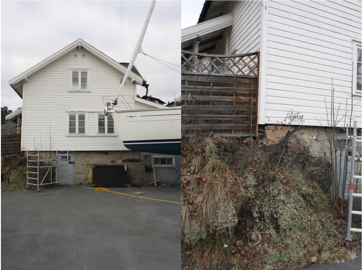
Odden, mot øst, og detalj grunnmur Foto: HAG/RA
