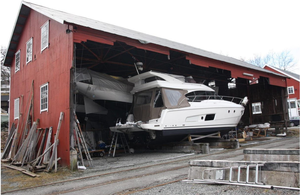
Båtskur 1/verkstedhall mot nord og øst. Kledningen mot nord er tilpasset etter behov. Foto: HAG/RA
