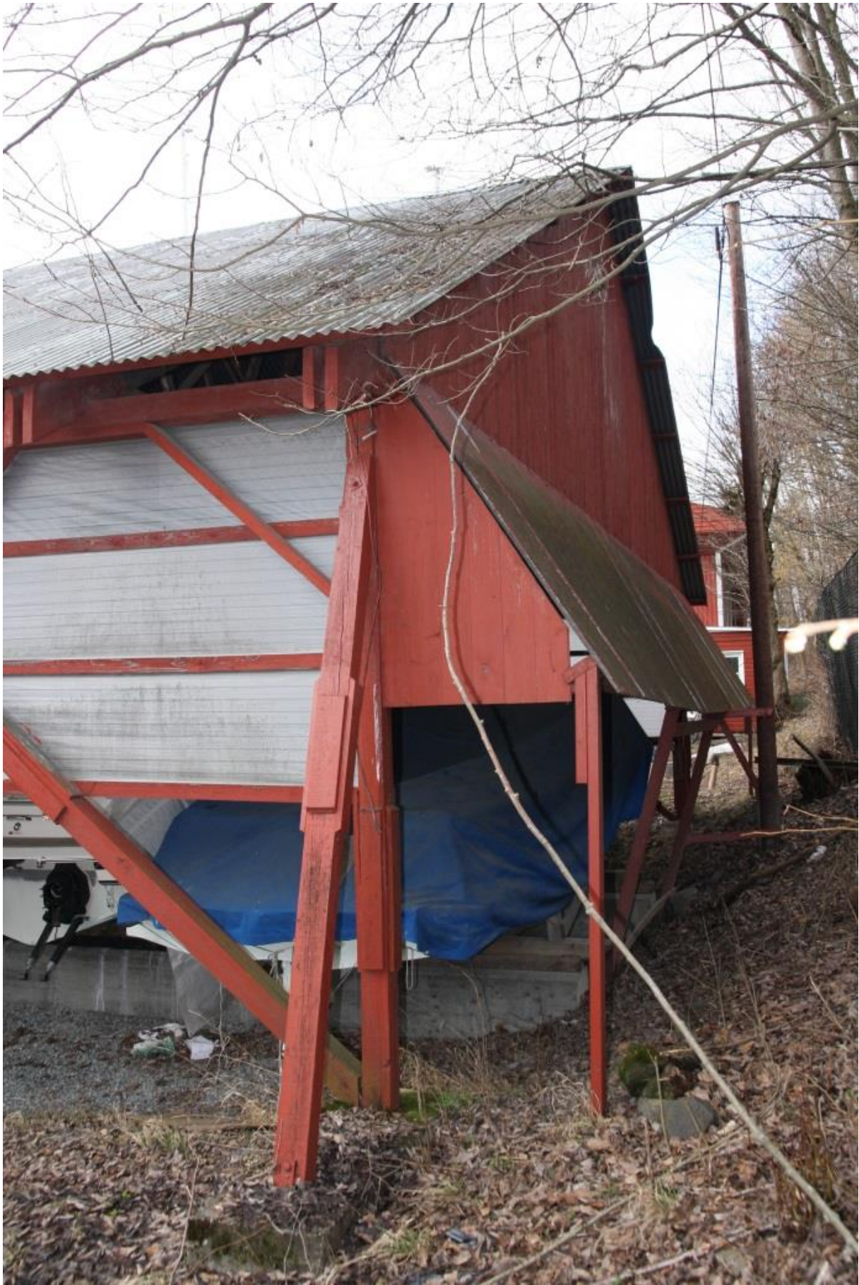
Båtskur 9, påbygg med pulttak mot nord. Foto: HAG/RA
