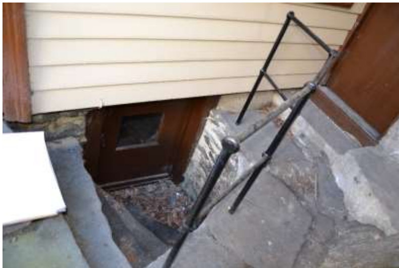
Kjellerhals innerst i bakgården under uthusets 2. etasje. Nytt smijersrekkverk.
