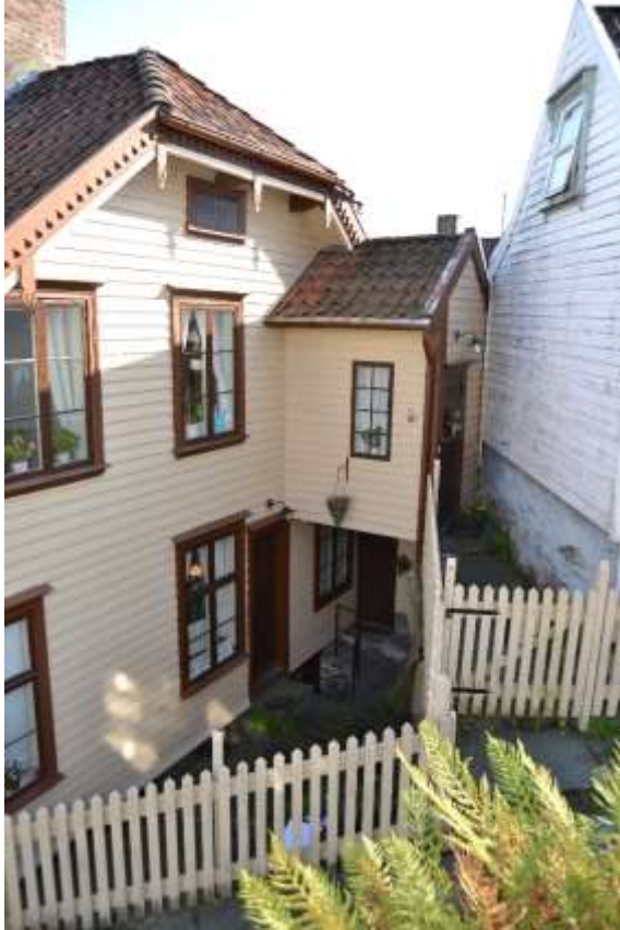
Fotografi av bakgården sett fra Eckmannsbakken. Stakittgjerdene er nye. Inngang til uthusets 2. etasje skjer via ei bru fra Eckmannsbakken. Denne brua er ny. Uthuset i 2. etasje har gitt rom for et nytt inngangsparti og baderom.
