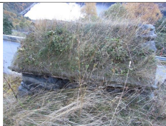
Fasade mot aust
