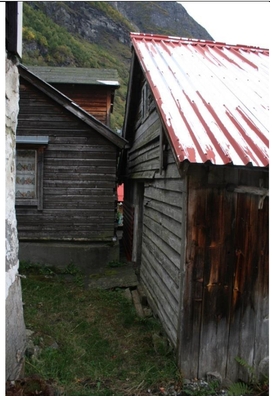
Fasade mot nord, bygning til høyre
