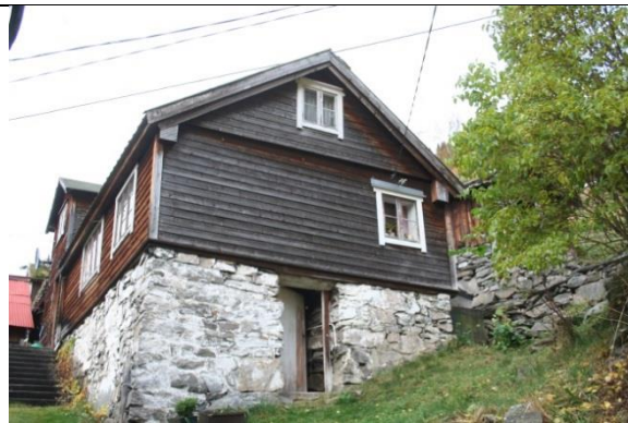
Fasade mot sør og aust
