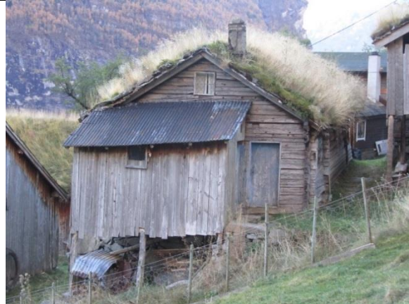
Fasade mot aust.
