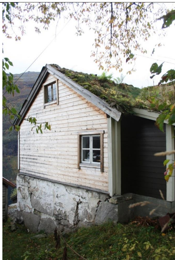
Fasade mot aust.
