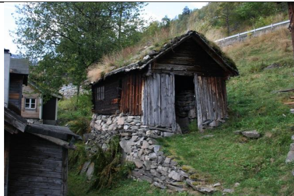
Fasade mot sør og aust.
