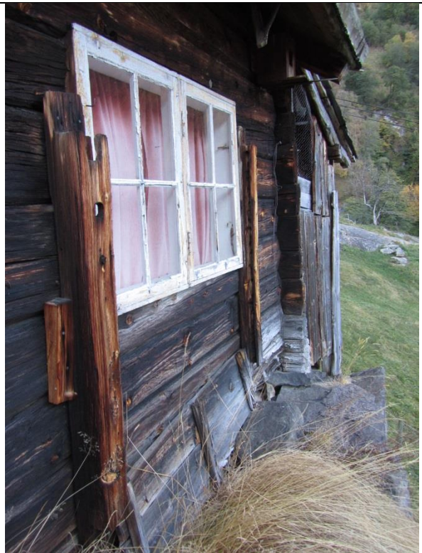
Vindauge mot sør, med restar etter vindaugslemmer som kunne skuvast opp framfor vindauge.
