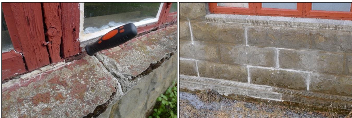
Til venstre: 2012: Vindu med råteskade i bunnkarm. Til høyre: 2015: Eksempel på ferdig utført arbeid.
