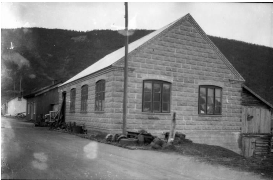
Haagensenverkstedet ca. 1925, tilbygget mot nord er godt synlig. Fotograf: Ingard Markussen.
