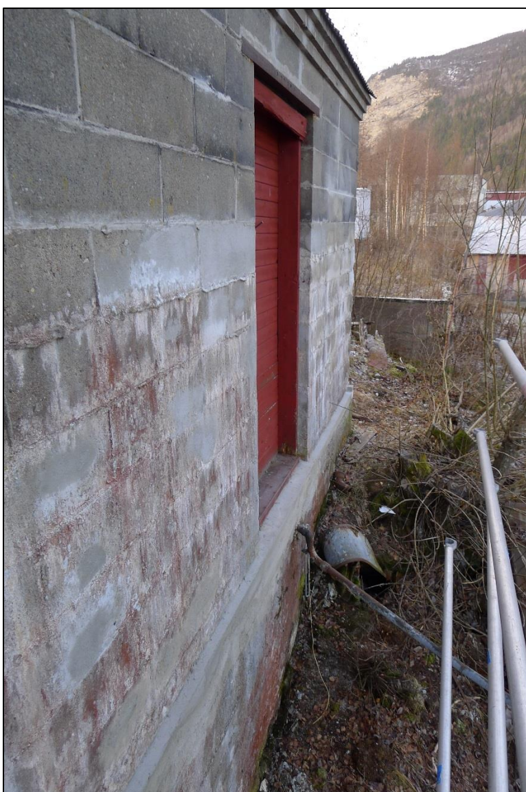
2016: Utbedringer på bygningens bakside (mot nord).
