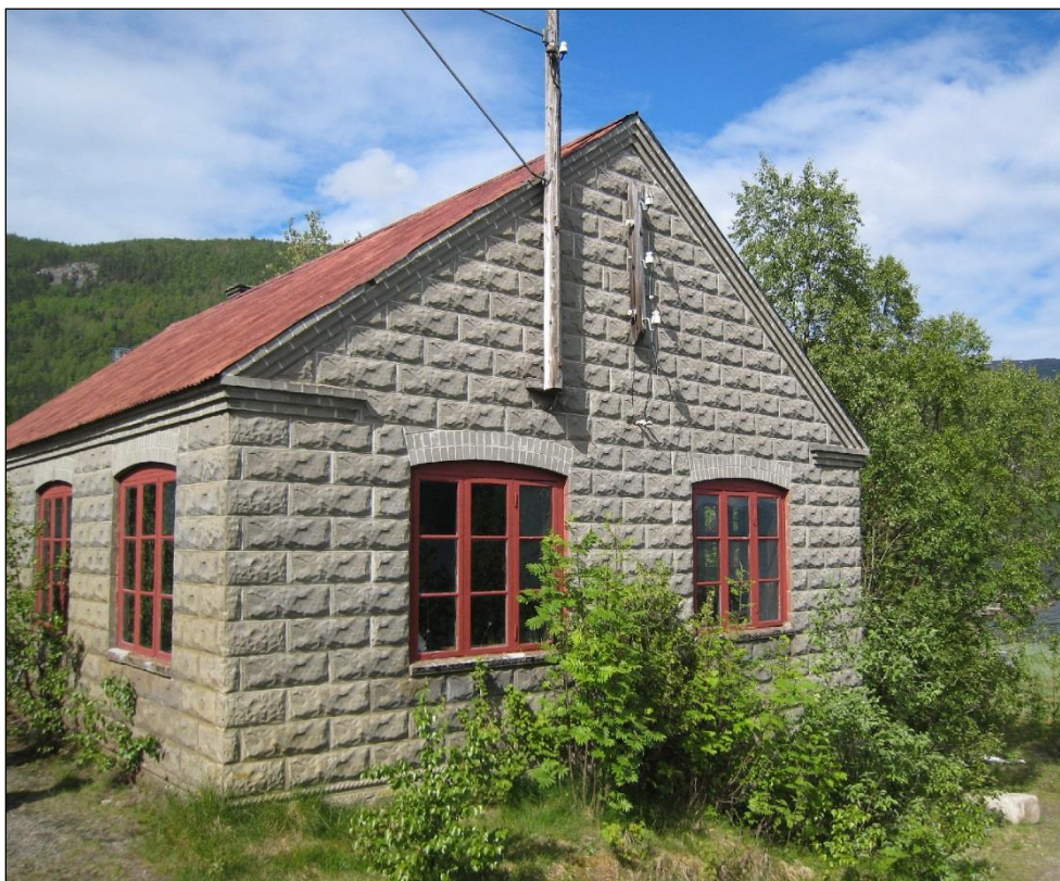
Vinduer med vindusbuer; raft og møne med den karakteristiske tredelte gesimsavtrappingen.
