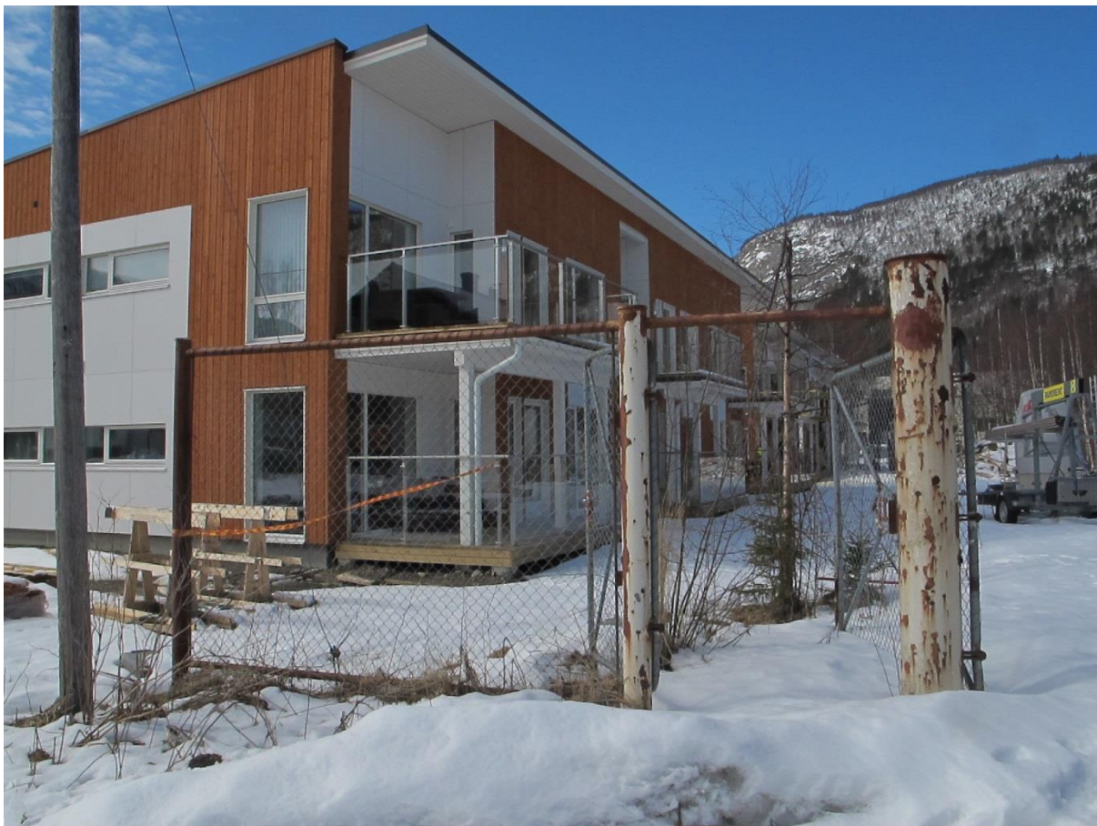
Den sørligste delen av gjerdet, med personalinngangen til høyre.
