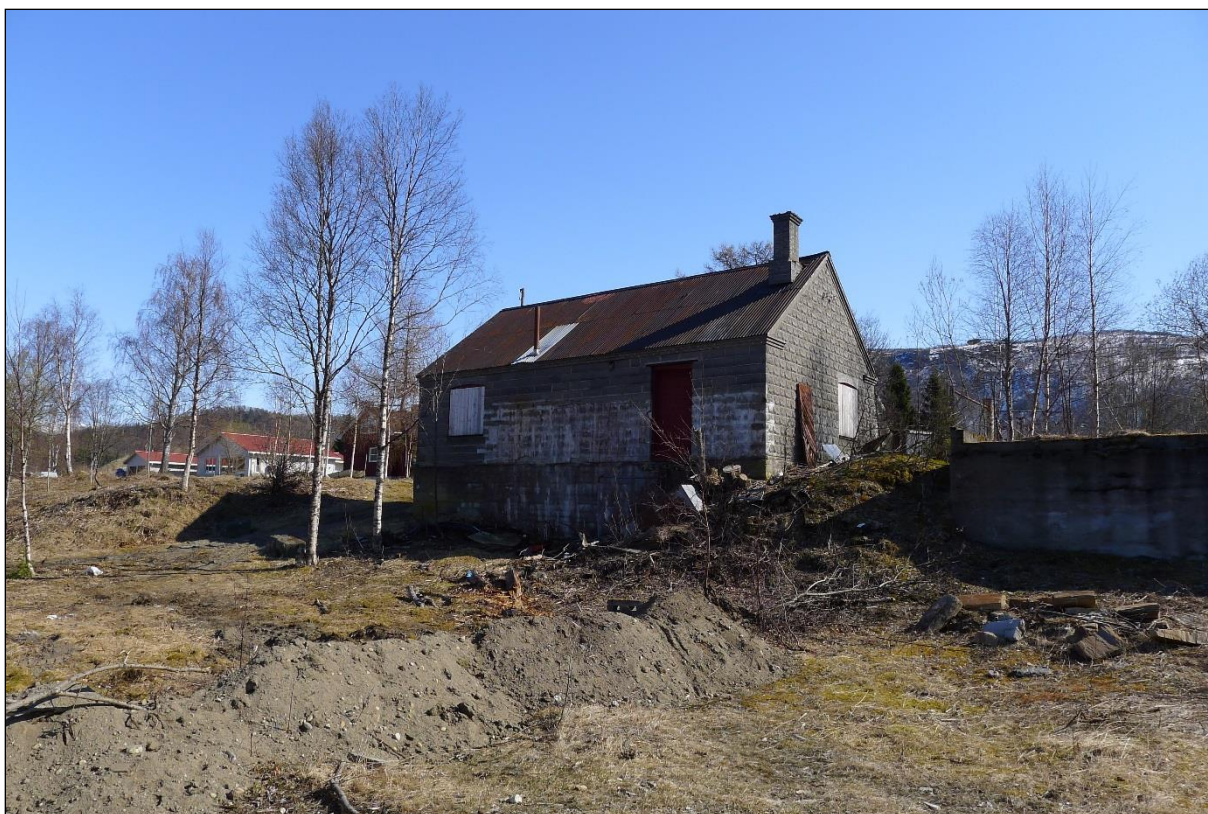
Haagensenverkstedet, naboeiendom mot vest eies av Saltdal kommune.
