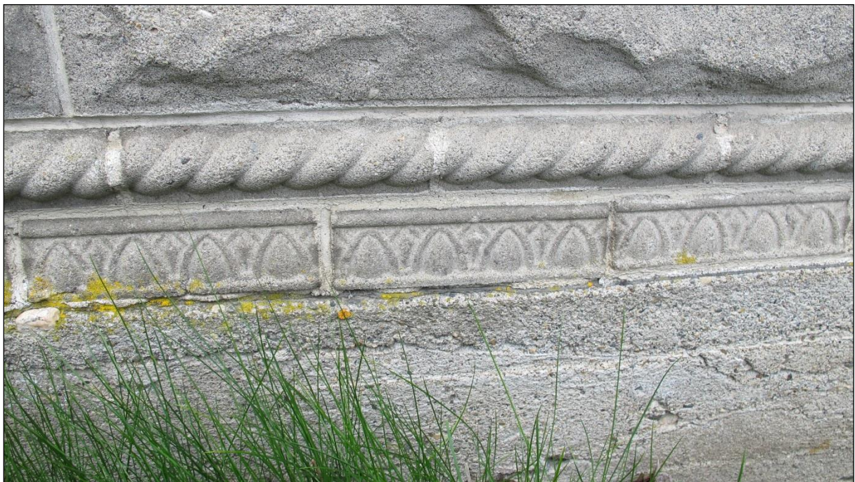
Mønsterdetaljene med navn "egg and darts" nederst, med båndmønster over, på den støpte sålen.
