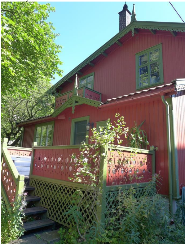
Fasade mot nord-vest med terrasse og trapp ble oppført i 1990.
