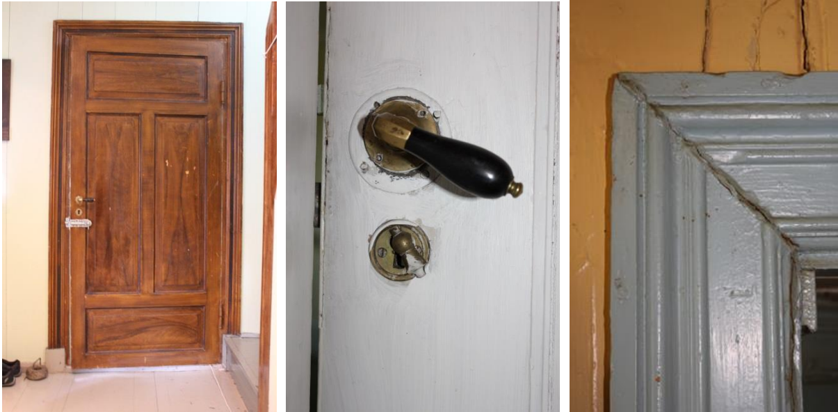
Dør, dørklinke og listverk med typisk sveitserstilutforming. Hentet fra ulike rom og delvis gjenbrukt. Alle foto: Bård Langvandslien, Riksantikvaren
