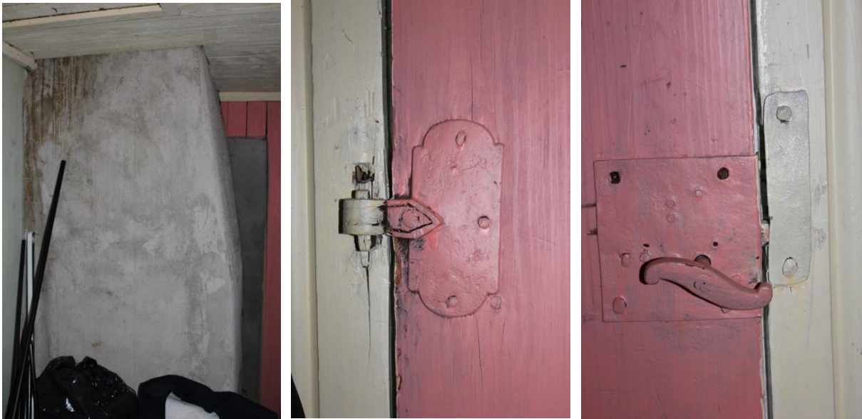
Fra kott i 2.etasje, pipestokk, dørhengsel og dørklinke. Alle foto: Bård Langvandslien, Riksantikvaren
