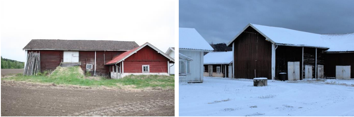
Stallåve og grisehus sett fra øst og fra tunsiden med låvedør, vognskjul og tilbygd verksted/garasje. Foto: B. Langvandslien, Riksantikvaren
