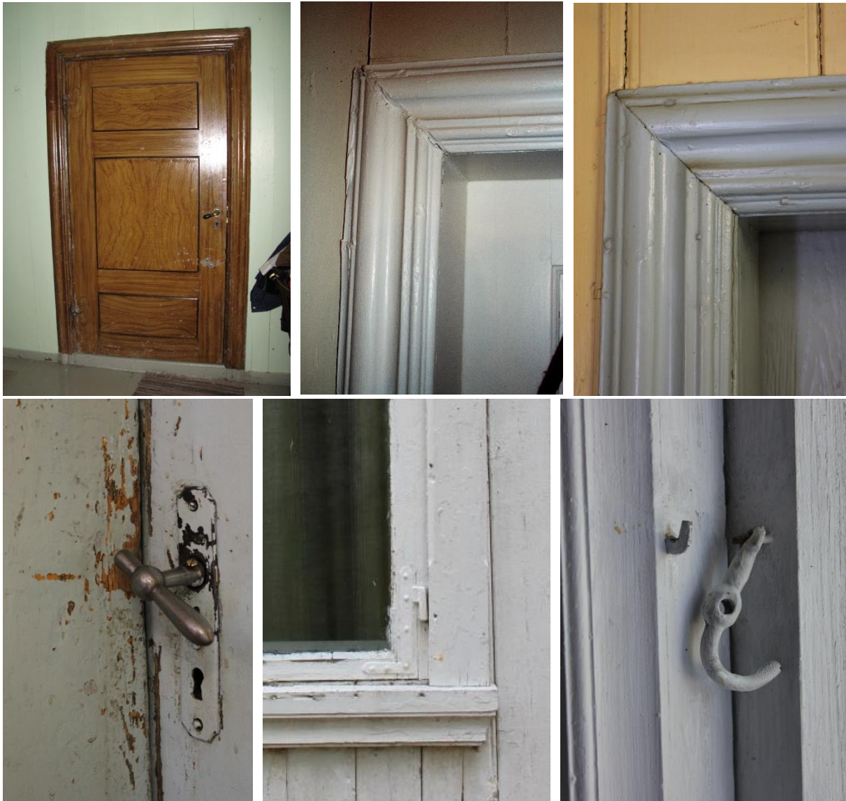
Dør 3 fyllinger og bladhengsel fra 1860 eller før (døra og hengslet kan være fra omkring år 1800), gerikter med rokokkoprofil, vindushengsel fra 2 halvdel av 1800-tallet og haspe fra omkring år 1900. Alle foto: Bård Langvandslien, Riksantikvaren
