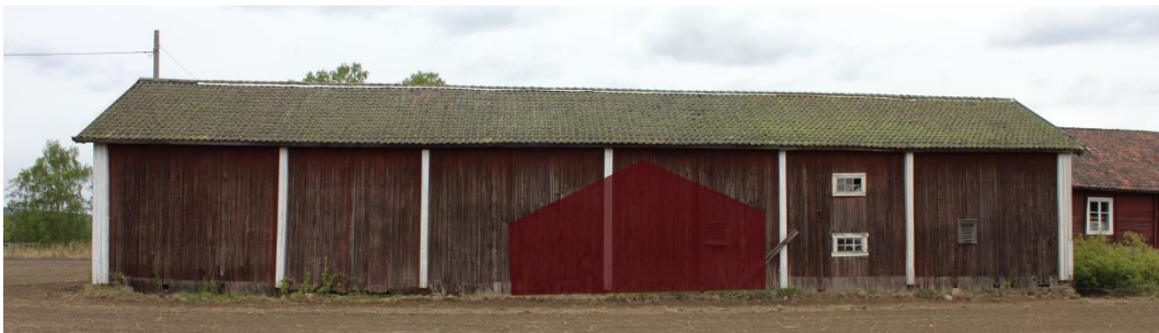
Låve med markert spor etter tilbygg, trolig for hestevandring. Foto: Bård Langvandslien, Riksantikvaren
