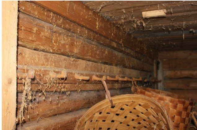
Knaggrekke. Foto: Bård Langvandslien, Riksantikvaren
