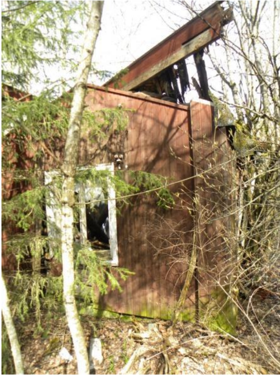
Steffenstugua ved Skapals-Rykop, i sterkt forfall. Lafteknutene tyder på byggeår før 1800. Andre detaljer (elektrisk opplegg) viser at den var i bruk iallfall til 1960-tallet.
