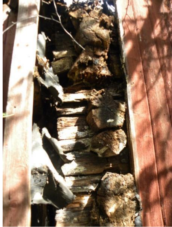
Steffenstugua ved Skapals-Rykop, i sterkt forfall. Lafteknutene tyder på byggeår før 1800. Andre detaljer (elektrisk opplegg) viser at den var i bruk iallfall til 1960-tallet.
