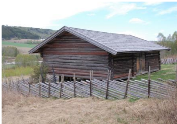
Vestre gavlvegg, og sørvegg
