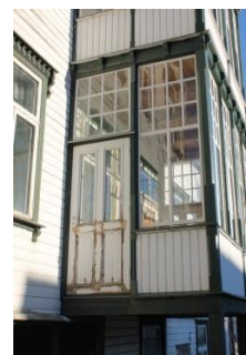
Innglasa veranda, der mellomgang mellom verandaar manglar.
