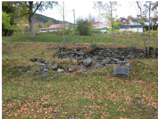
Oppmurt veg opp bak hotellet. Foto: Riksantikvaren
