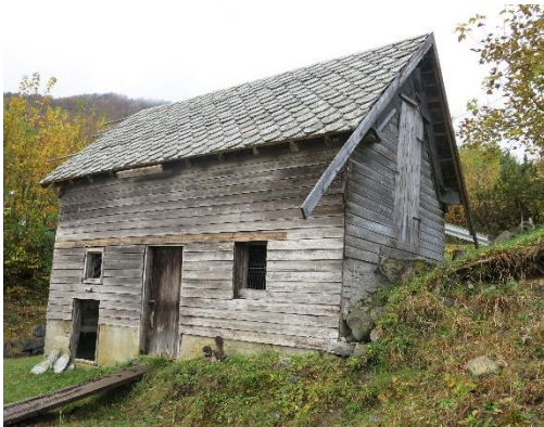
Løe etter skifting av tak i 2017 Foto: Riksantikvaren
