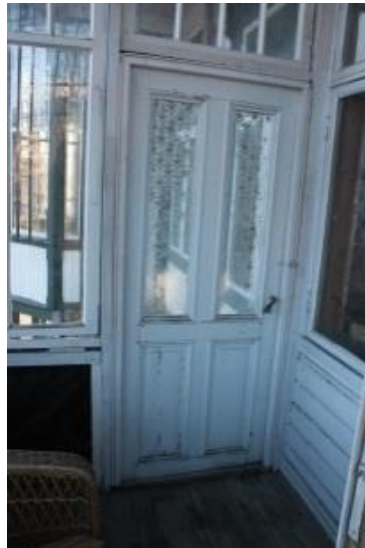
Dør frå glasveranda ut mot tidlegare mellomganger mellom verandaer.
