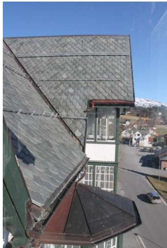
Tak av lappsteinsskifer. Kopar over midtre veranda.
