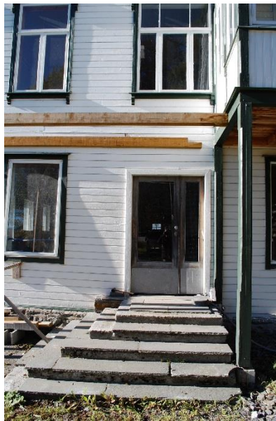
Trapp og inngangsdør mot aust i første etasje
