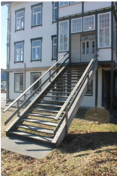
Trapp til hovudinngang i andre etasje.
