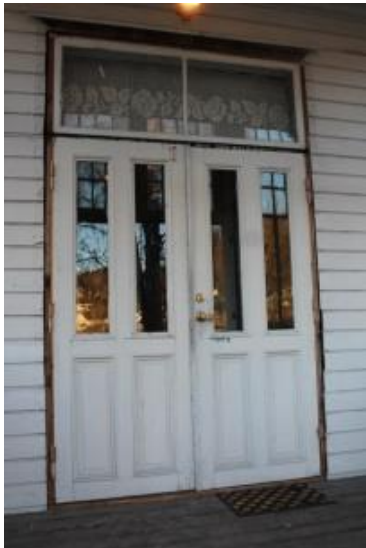
Hovudinngang i andre etasje, på austsida.
