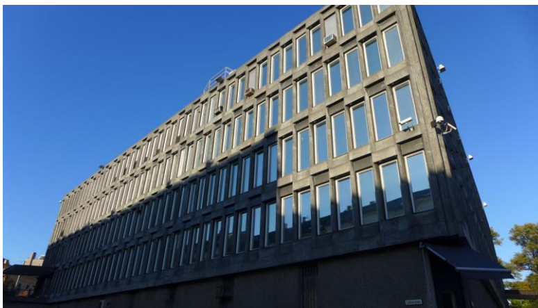
Fasade mot Løkkeveien med de karakteristiske prefabrikkerte fasadeelementene av betong tilsatt knust Labrador. Foto: Byantikvaren.
