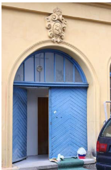
Port til pakkhusedelen fra sør. Trolig eneste gamle ytterdør. Foto: J. Chr. Eldal, NIKU 2006.
