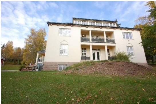
Hovedbygningens sørfasade OFK/M. A. 30.09.2009.
