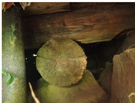
Gulvet hviler på lunner, som ligger på anleggsstokker/reimer.
