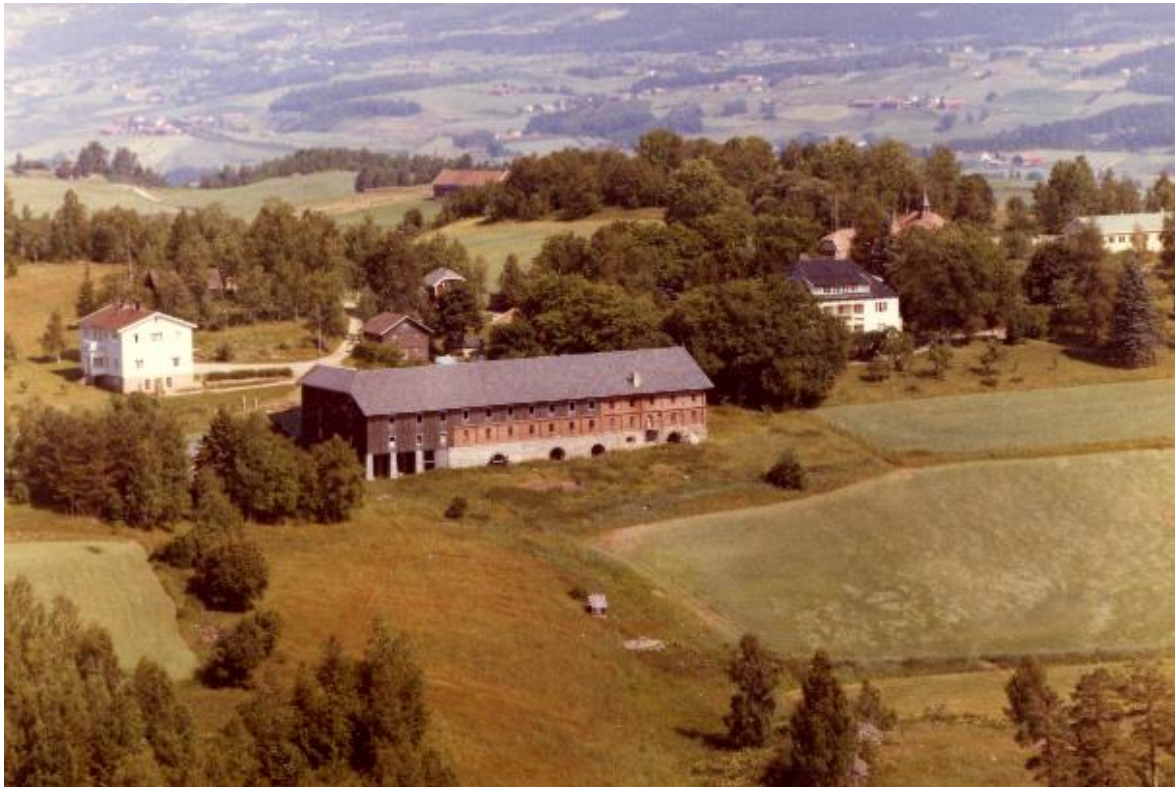
Driftsbygningen før den ble revet. Stabburet hadde fremdeles skifertak. Hovedbygningen har fått takopplett. Foto fra Randsfjordmuseet. 22.07.1966.
