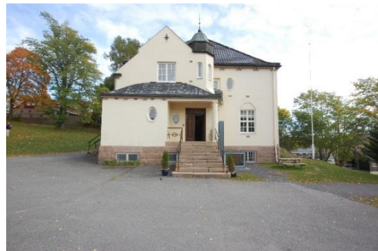
Hovedbygningens vestfasade OFK/M. A. 30.09.2009.
