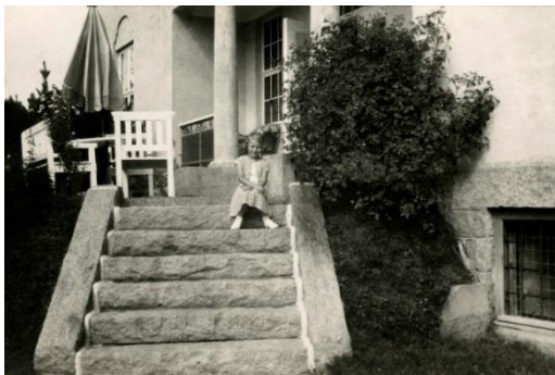
Trapp ned fra terrassen på sørsiden. Eier av foto: Torbjørg Raastad. U.å.
