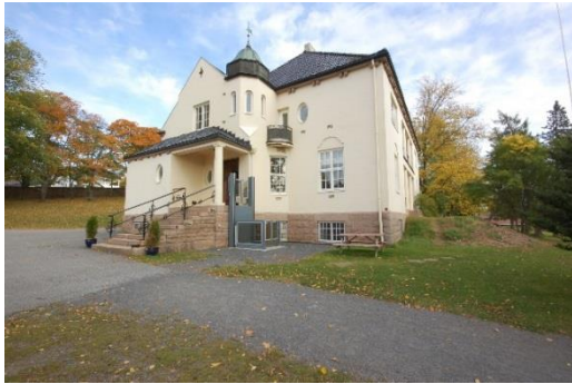
Hovedbygningen sett fra sørvest. Heis for universell utforming ved inngangspartiet. OFK/M. A. 30.09.2009.
