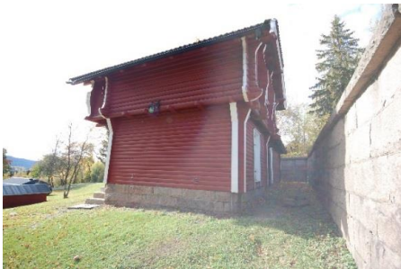
Nordøstre fasade. To inngangsdører fra baksida mot muren. OFK/M. A. 30.09.2009.
