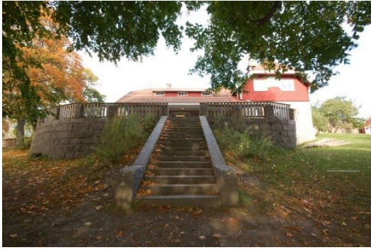
Markert inngangsparti på sørsiden med trapp og allé fra hagen. OFK/M. A. 30.09.2009.
