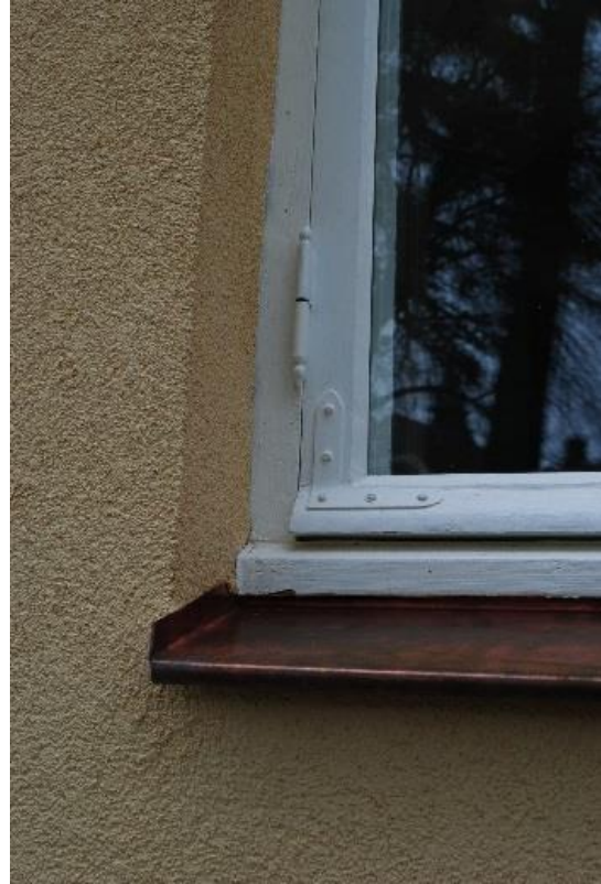
Detalj av vannbrett i kobber, beslag og hengsle på vindu. Vannbrettene i kobber ble montert ved istandsettingen i 2016, tidligere vannbrett var i zinkmetall. OFK 18.05.17.
