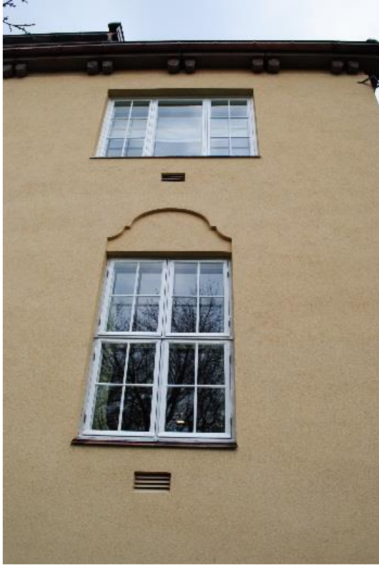
Buet detalj i vegg over vindu på fasade sør-vest. Utsmykket gesims i granitt. OFK 18.05.17.
