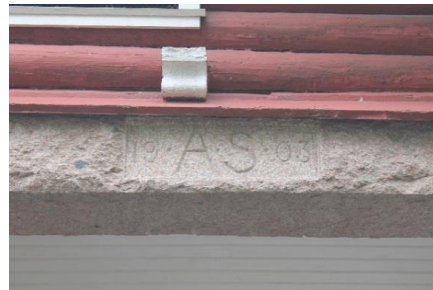
I granitten på vestfasaden er det hogd inn "19 A S 03" OFK 2015.
