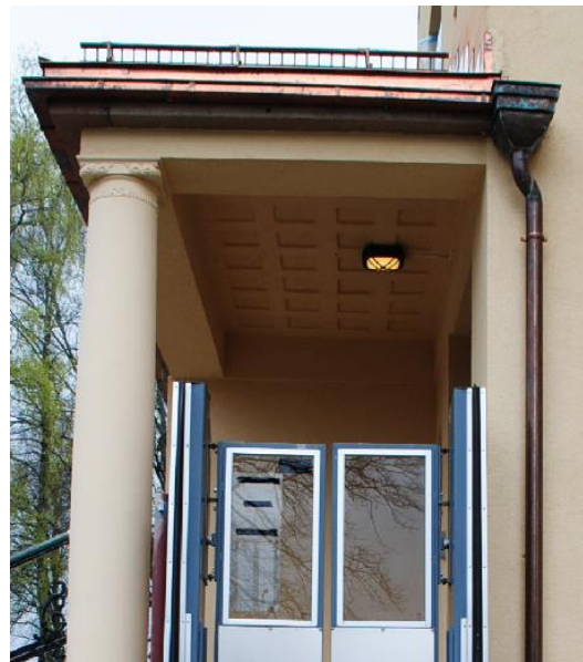
Detaljer fra inngangsparti øst: Kapitel på søyle som ligner Astrups tegninger fra Fearnley jr.-villaen, struktur i taket, og en antatt opprinnelig takrennebrønn.
