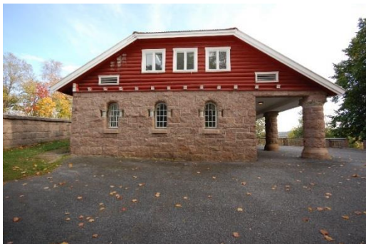
Stallens vestfasade. Vinduene i andre etasje er ikke opprinnelige. OFK/M. A. 30.09.2009.
