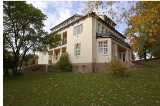
Hovedbygningen sett fra sørøst OFK/M. A. 30.09.2009.
