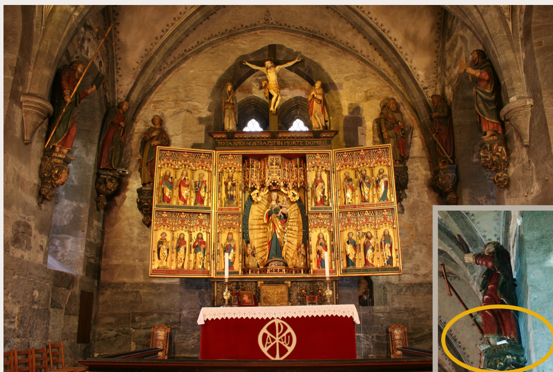
I Mariakirken i Bergen er trådløs sensor for varmestyringsanlegg plassert på skulpturens sokkel.
