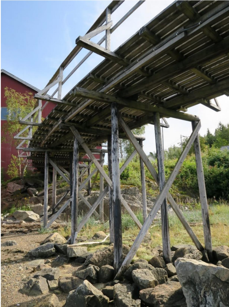
Figur 6 Trallebane, brokonstruksjon i tømmer Foto: RA
