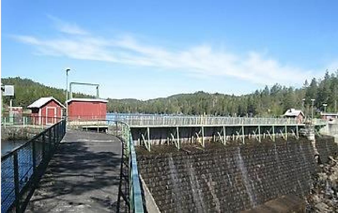
Dammen slik den var før 2012. Foto: Erling Nystad, Statkraft.
