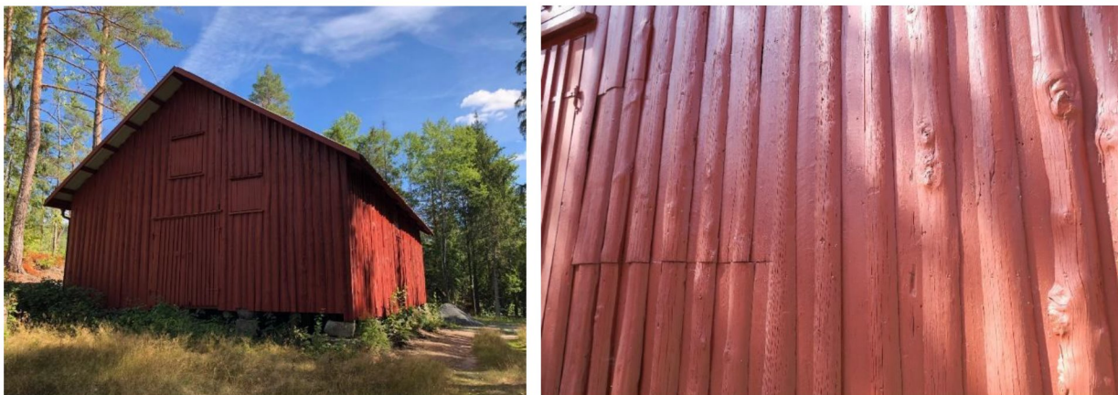
Til venstre: Sementbua sett fra vest. Til høyre: Sementbuas panel av halvkløyvinger.
