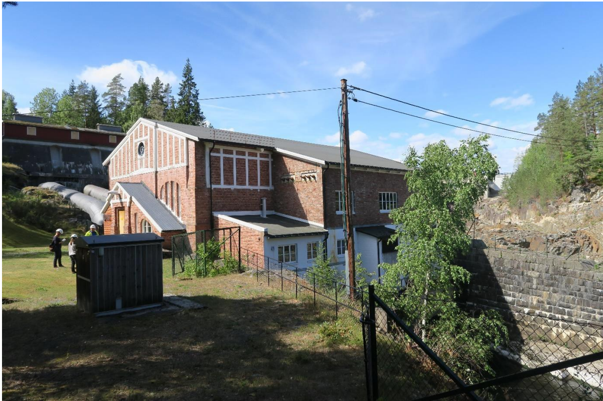
Stasjonsbygningen, august 2018. Foto: Linn Brox, Riksantikvaren.
