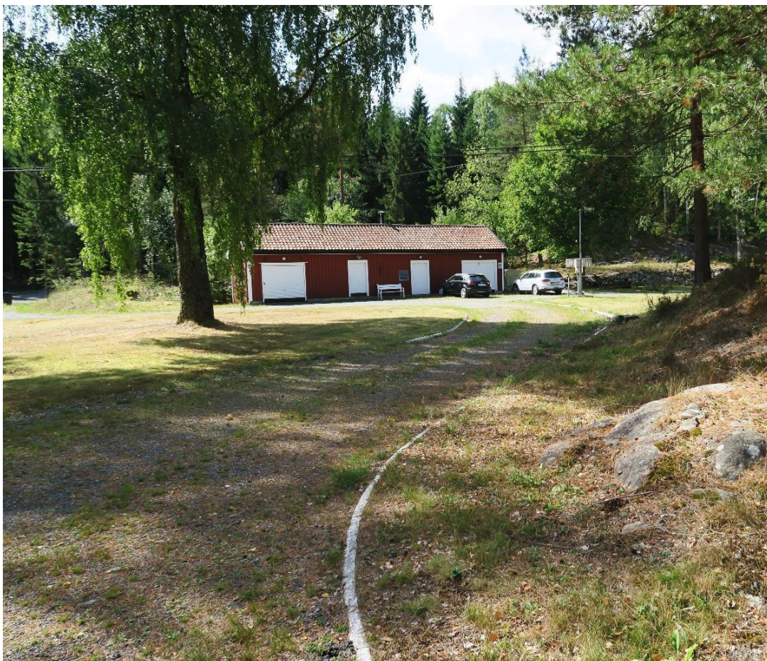
Veien mot kraftoverføringsanlegget kantet med betongstein. Foto: Linn Brox, Riksantikvaren.
