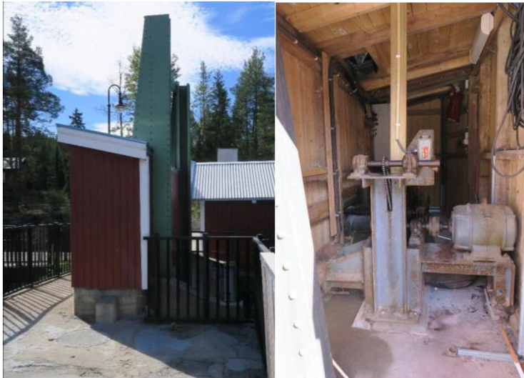
Damstyringshus med lukeopptrekket, august 2018. Foto: Linn Brox, Riksantikvaren.
