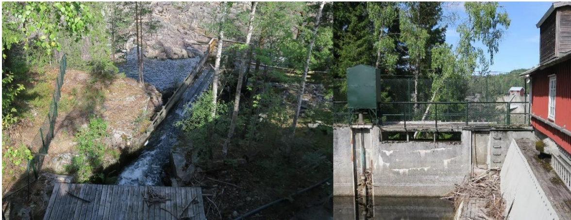
Ålekasse og -kanal sett fra nedre basseng. Overløp og luke til ålekassen til høyre. August 2018. Foto: Linn Brox, Riksantikvaren.
