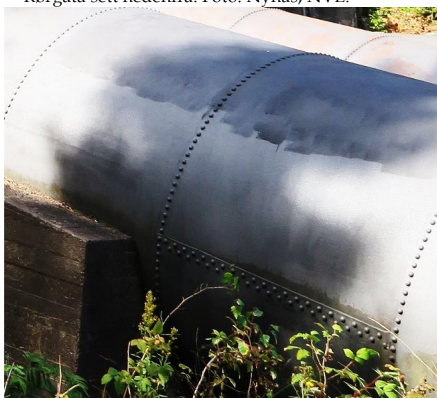
De opprinnelig klinkede rørene, august 2018. Foto: Linn Brox, Riksantikvaren.
