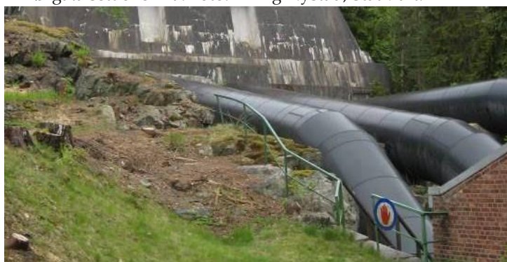
Rørgata sett nedenfra. Foto: Nynäs, NVE.
