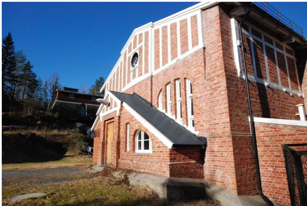
Stasjonsbygningen på Dalsfos, 2012. Foto: Erling Nystad, Statkraft.
