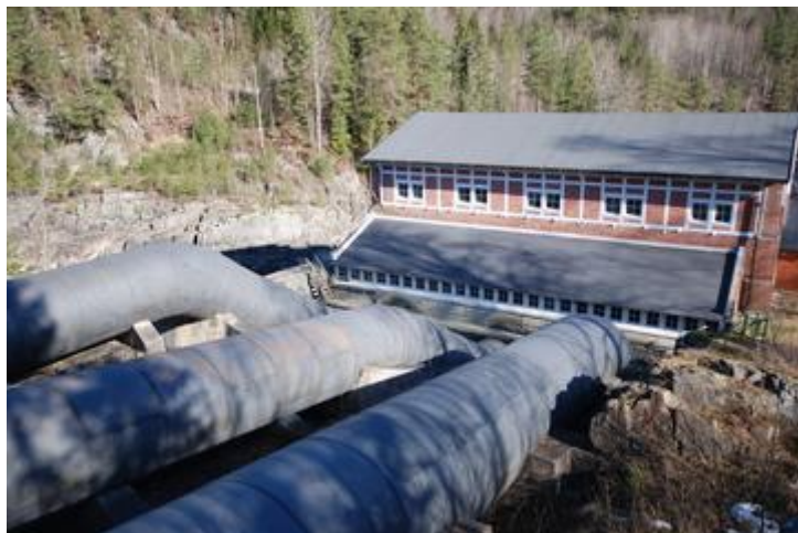
Rørgata sett ovenfra. Foto: Erling Nystad, Statkraft.
