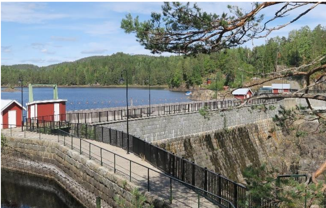
Bilde fra august 2018 der dammen nå er murt helt opp og nålene fjernet. Foto: Linn Brox, Riksantikvaren.
