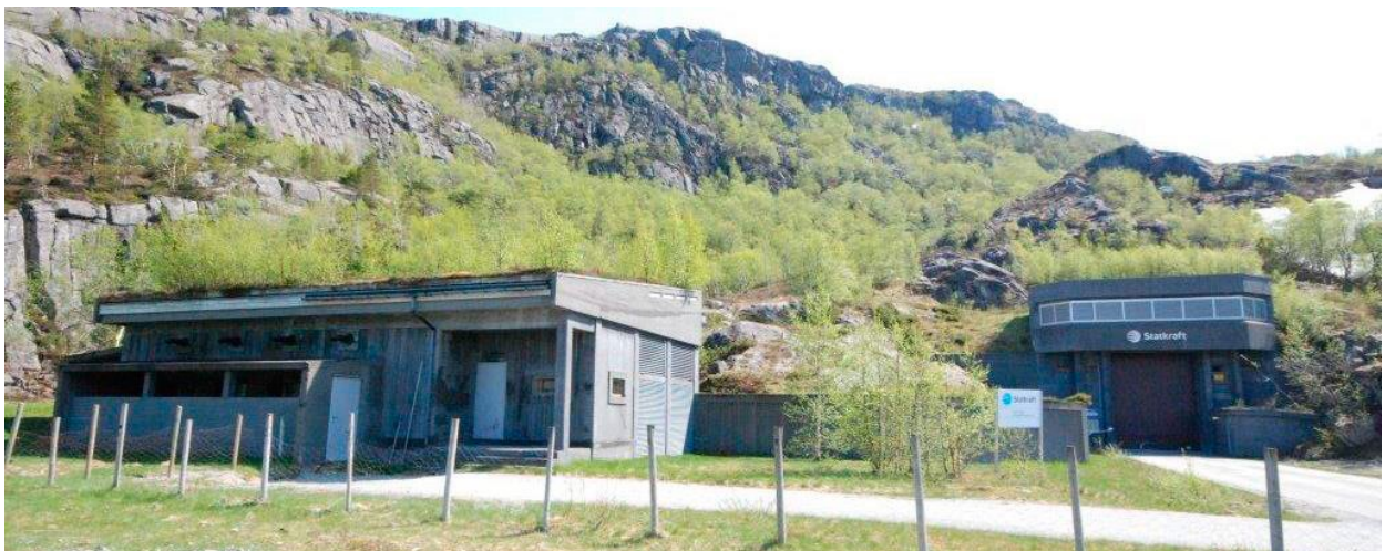
Nødstrømsaggregatet til venstre, portalbygning til høyre. Foto: Erling Nystad, Statkraft
