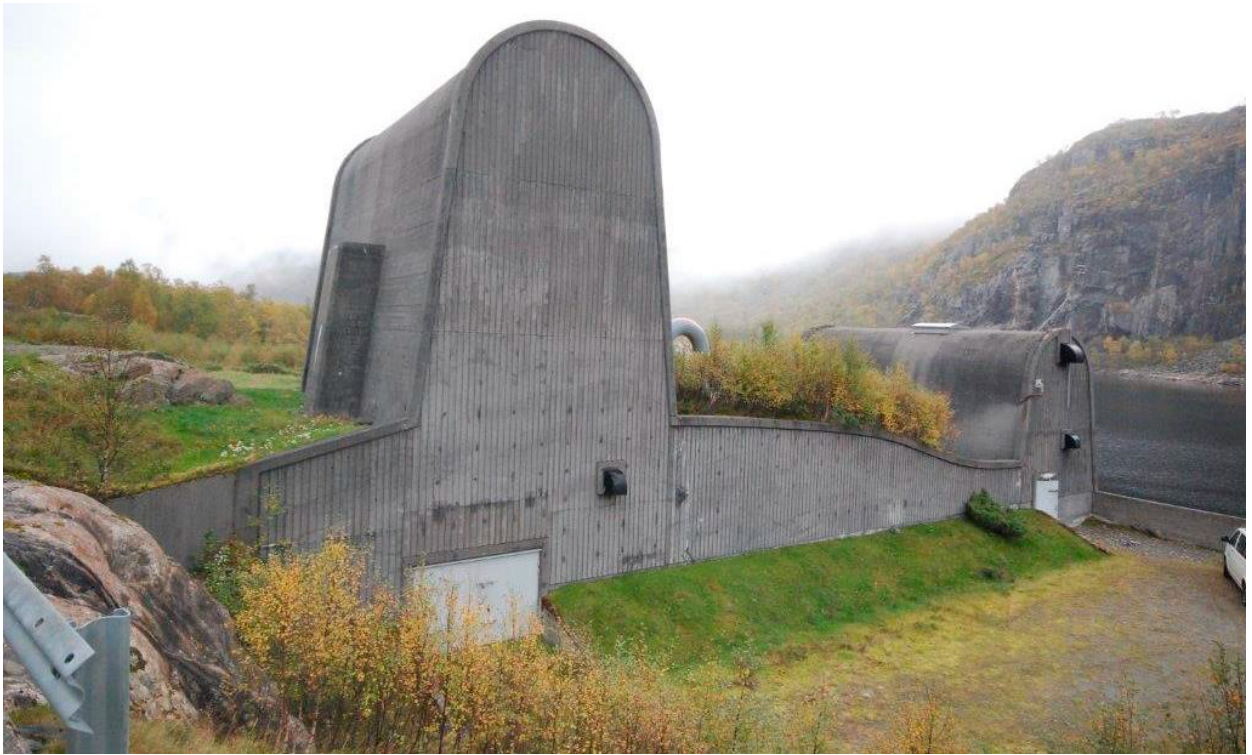
Inntakshus. Foto: Erling Nystad, Statkraft
