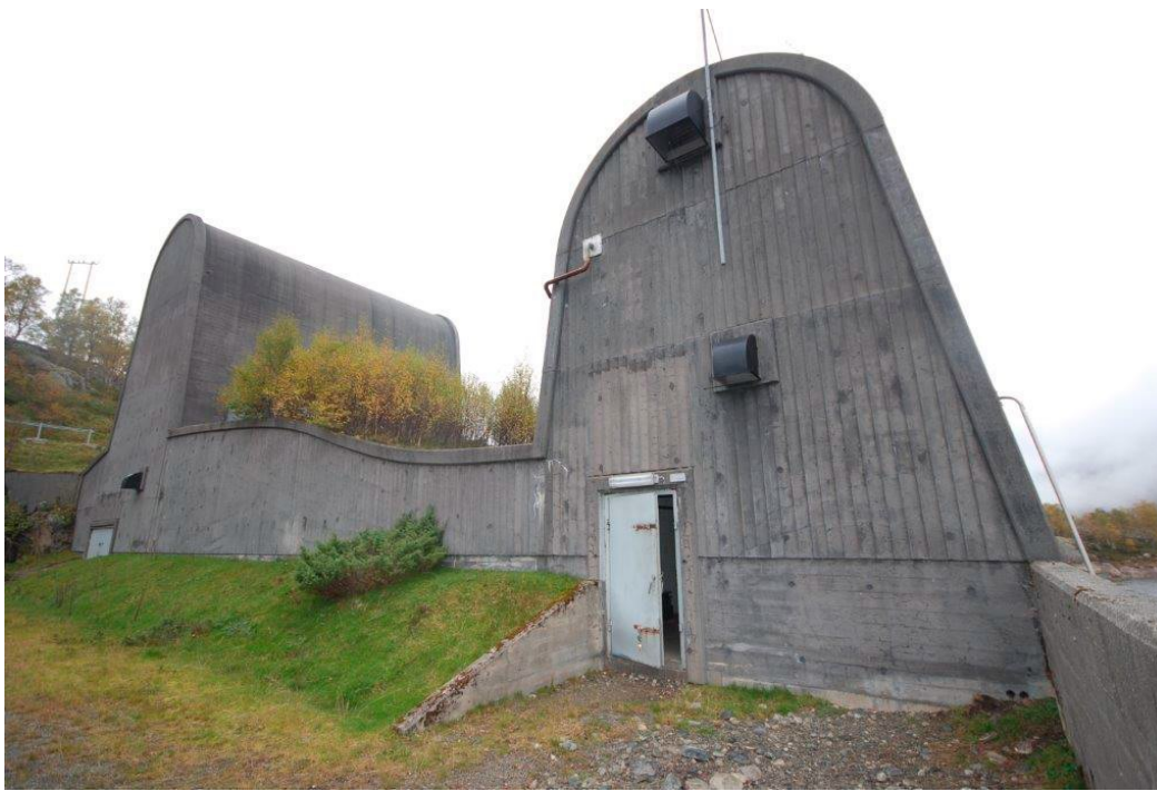
Inntakshus. Foto: Erling Nystad, Statkraft
