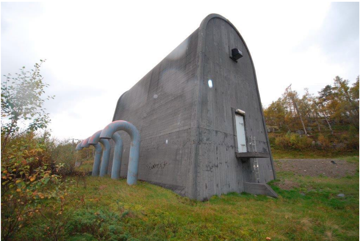
Inntakshus. Foto: Erling Nystad, Statkraft
