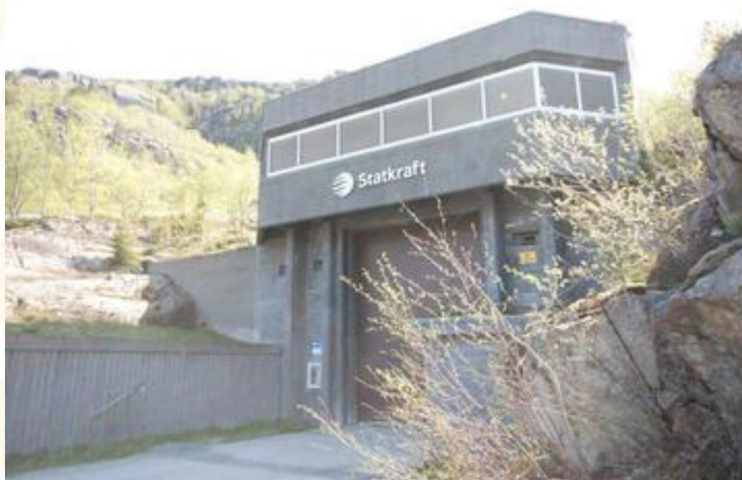
Hylen kraftverk og Saurdal pumpekraftverk. Foto: Erling Nystad, Statkraft Energi AS
