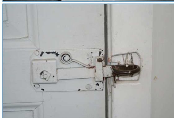
Figur 9. Låskasse med fjærklinke og vrider. (Foto: Arnt Magne Haugen, 2011)
