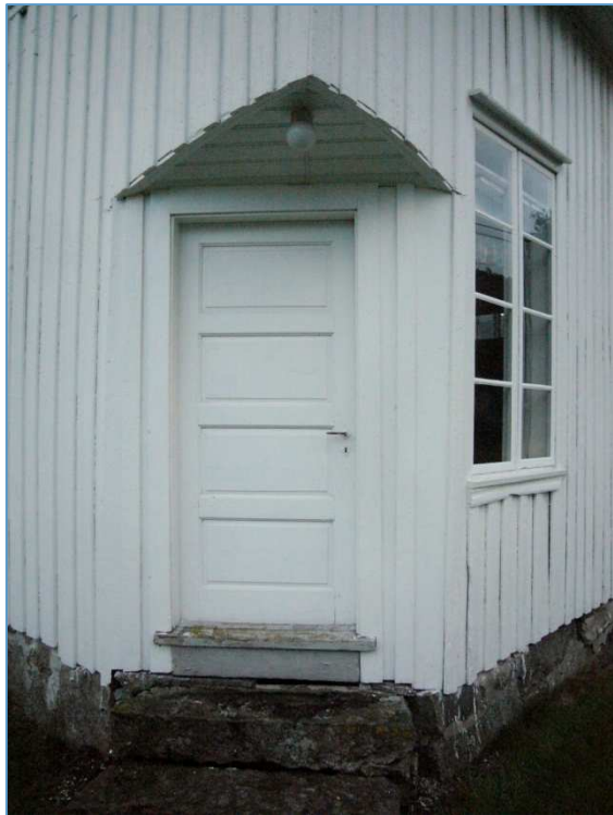
Figur 5. Inngangsdøra er tydelig "byinspirert". (Foto: Arnt Magne Haugen, 2011)
