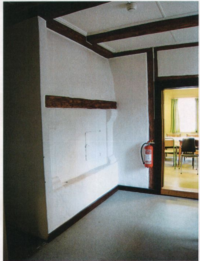
Figur 33: Innmurt grue på sydveggen. Foto: Kulturarv
