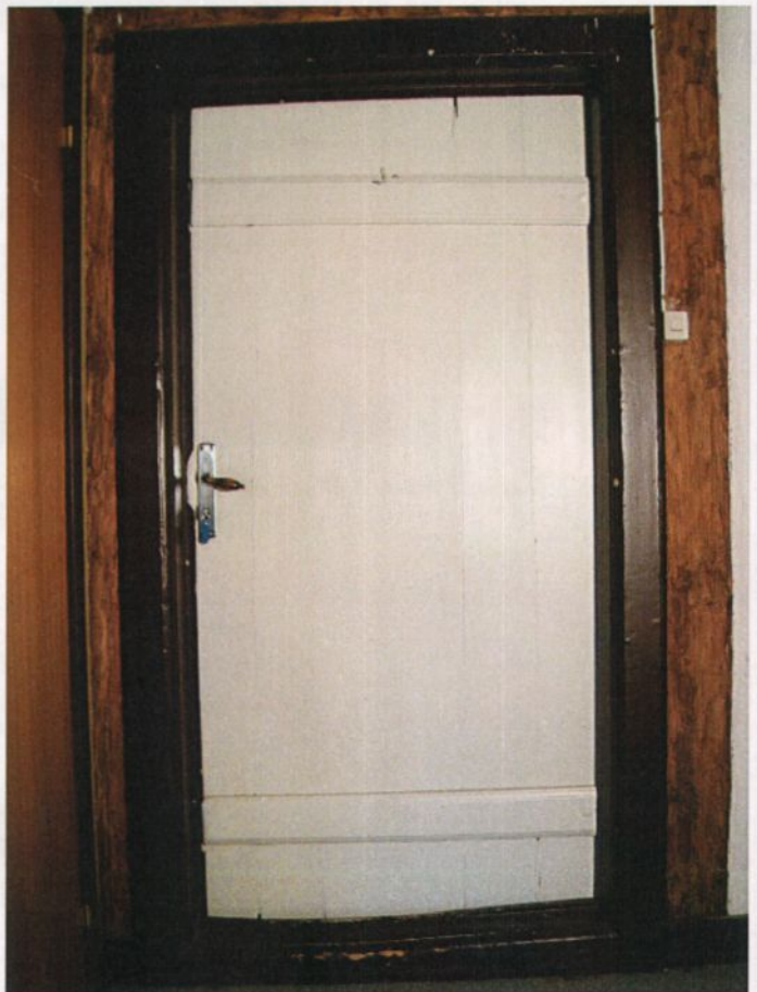
Figur 28: Original labankdør mot øst. Foto: Kulturarv
