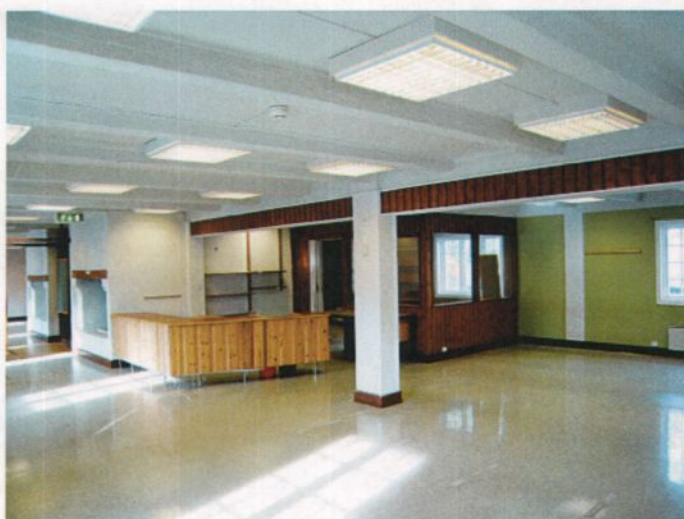
Figur 16: Fotoet viser det store biblioteksrommet i første etasje. Nytt gulvbelegg, kvadratiske lysstoffrør og elektriske panelovner går igjen i hele etasjen. Foto: Kulturarv.
