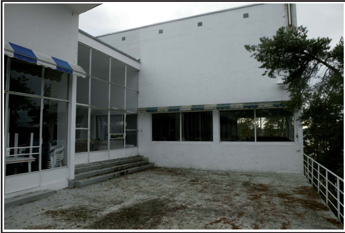
Restauranten mot sjøen Foto: K.Langeland
