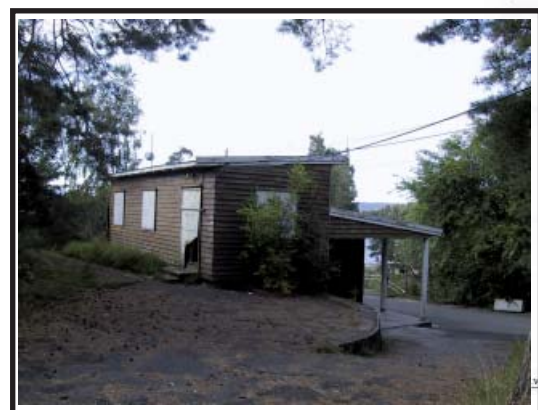
Administrasjonsbygning - sør og vestfasade Foto: S.Riibe
