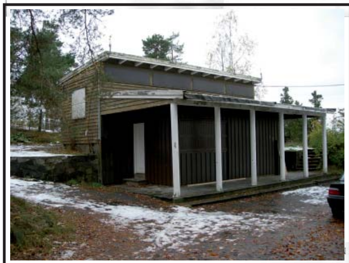
Administrasjonsbygningen Foto: C.Reusch
