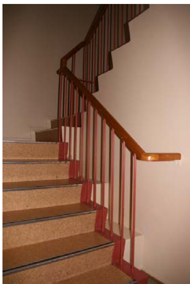
Opprinnelig trapp fra hall til 2. etasje. Opphavsrett: Statsbygg.
