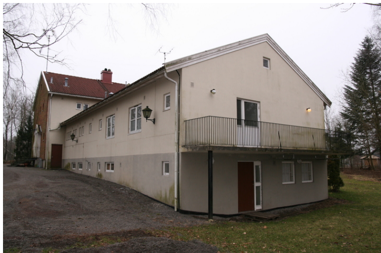
Fasade mot vest, inngang kjellerleilighet. Opphavsrett: Statsbygg.
