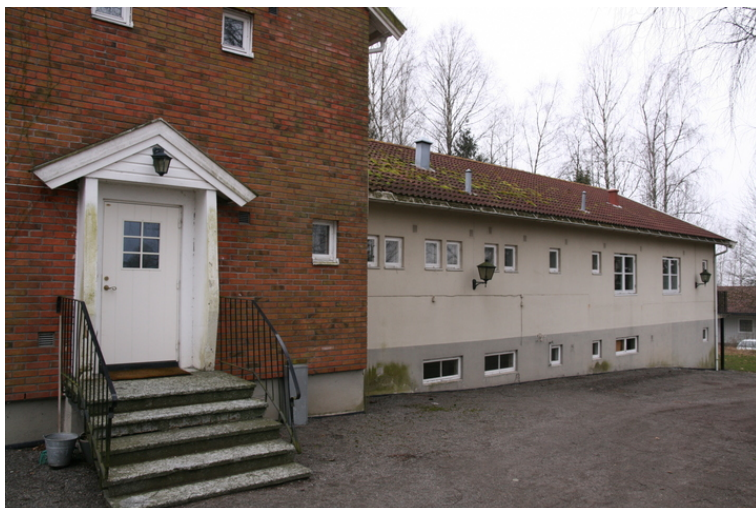
Dagens hovedinngang som opprinnelig var kjøkkeninngangen. Opphavsrett: Statsbygg.
