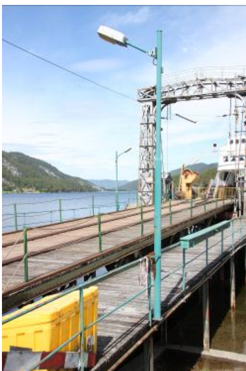
Fergeleie Tinnoset, østre gangbro med lyktestolpe og kasse for jordingsstang til kjøreledningen.
