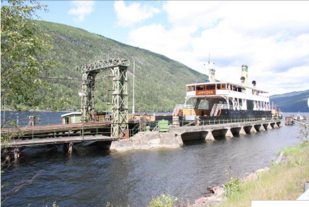
Fergeleie Mæl, søndre side med gangbro, lyktestolper, fergebro og klinket galge med betongfundament.
