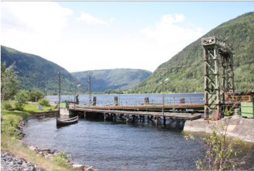
Fergeleie Mæl, søndre side med gangbro, lyktestolper, fergebro og klinket galge med betongfundament.
