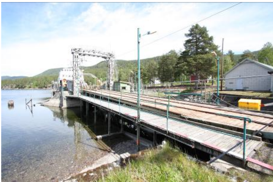
Fergeleie Tinnoset, vestre gangbro med rekkverk og lyktestolpe, fergebro og galge.
