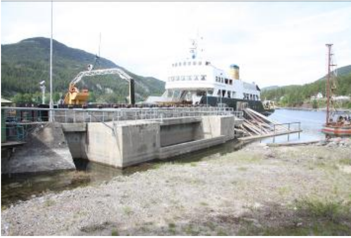
Fergeleie Tinnoset, østre fendervegg i betong, ca. 40 meter lang.
