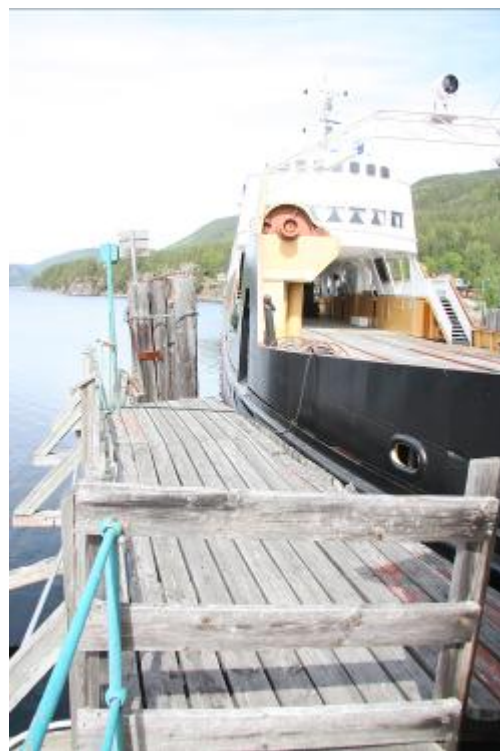
Fergeleie Tinnoset, østre fenderveggs nordligste part i trekonstruksjon med lanterne fra 1980 med grønt lys.
