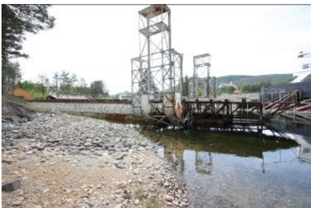
Slippen på Tinnoset, nedre del med oppbygning med bl.a. støttestag, treblokker og to innsiktstårn.
