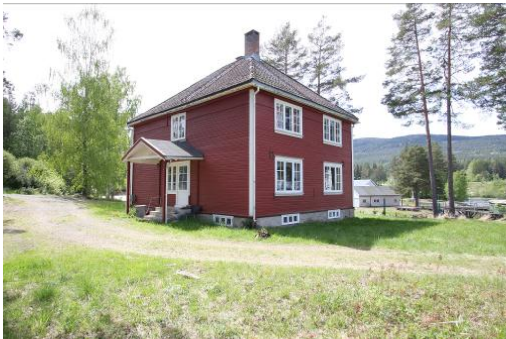
Hydrobrakke Tinnoset, østre fasade med inngangsparti og nordre fasade.
