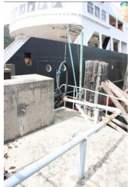
Fergeleie Tinnoset, plattform for oljepåfyll på østre fendervegg.
