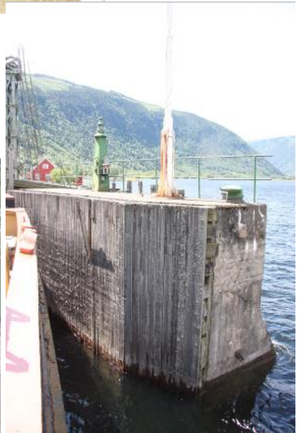
Fergeleie Mæl. Under: fergebro med gangbroer på sidene. Til høyre: nordre fendervegg med pullert, flaggstang og lanterne.
