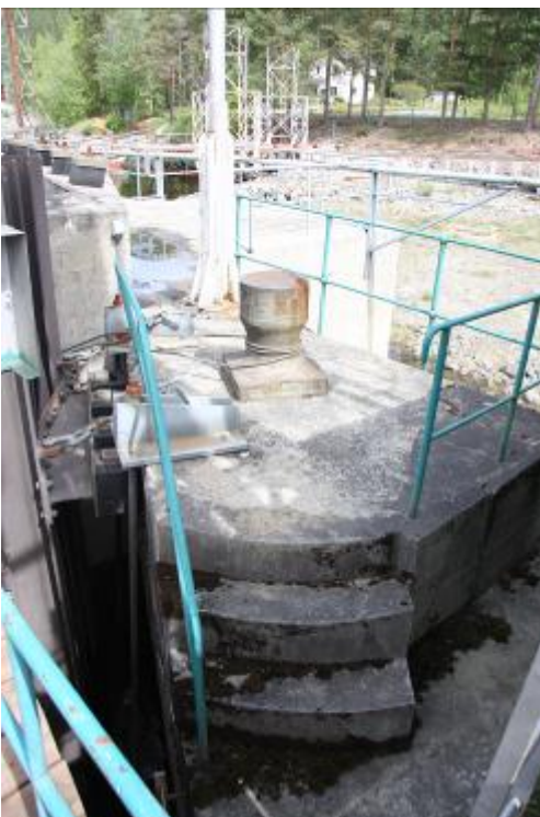
Fergeleie Tinnoset. Til venstre: trapp opp fra gangbro til østre fendervegg, pullert og flaggstang. Til høyre: lanterne fra 1980 med rødt lys på østre fendervegg.
