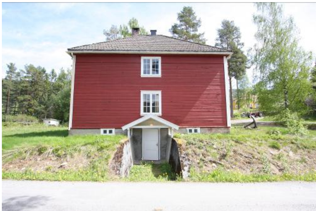
Hydrobrakke Tinnoset, vestre fasade med inngang til kjeller.
