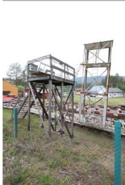
Slippen på Tinnoset, øvre del med maskinhus og innsiktstårn.
