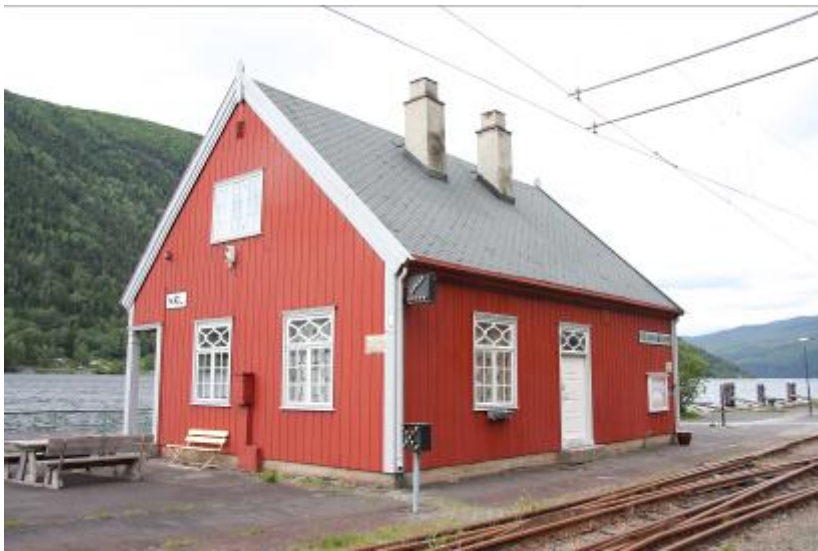
Stasjonsbygning Mæl, sørvestre hjørne.
