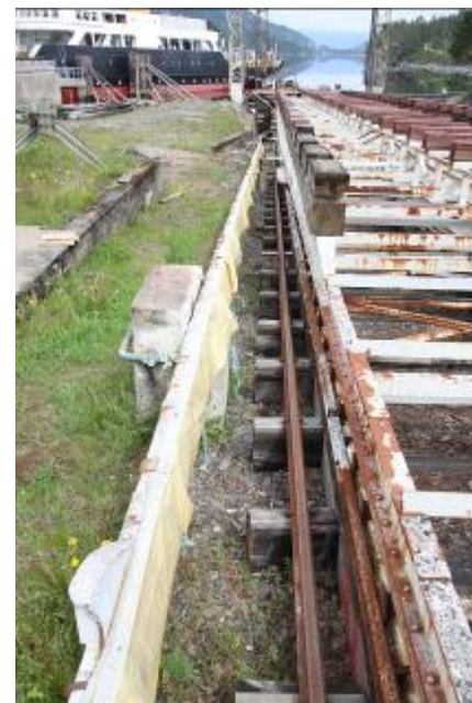
Slippen på Tinnoset, detaljer av oppbygning med bl.a. tresviller, skinnegang og treblokker (puter).
