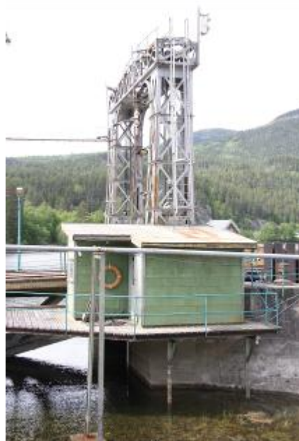
Fergeleie Tinnoset, Vinsjehuset for heismaskineriet til galgen står østre gangbro.
