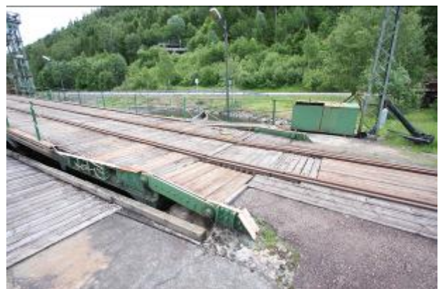
Fergeleie Mæl. Over til venstre: Vinsjehuset med galgens heismaskineri for fergebroen. Over til høyre: Kasse til jordingsstang for kjøreledning. Til venstre: detalj fra rekkverk på nordre gangbro. Under: detalj fra fergebroens feste mot land med klinket ledd.
