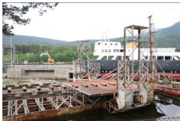
Slippen på Tinnoset, nedre del med oppbygning med bl.a. støttestag, treblokker og to innsiktstårn.
