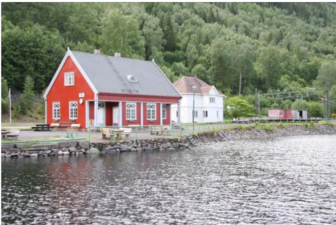
Stasjonsbygning Mæl, nordre fasade.
