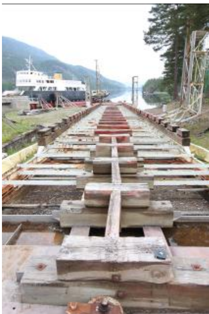
Slippen på Tinnoset, detaljer av oppbygning med bl.a. tresviller, skinnegang og treblokker (puter).
