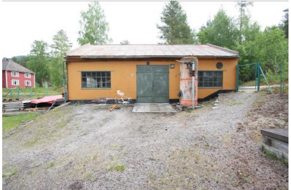
Maskinhus Tinnoset. Til høyre: vestre fasade med inngang. Under til venstre: håndklinket lufttank. Under til høyre: østre fasade med tilbygg i tre og nordre fasade med luke for slippwire og starten på slippen.
