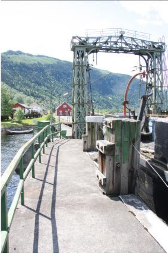
Fergeleie Mæl, søndre fendervegg med trepæler og rekkverk. Galgen i bakgrunnen.
