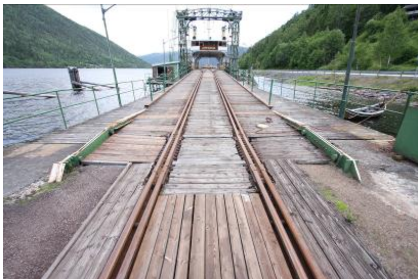
Fergeleie Mæl. Under: fergebro med gangbroer på sidene. Til høyre: nordre fendervegg med pullert, flaggstang og lanterne.
