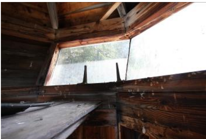
Urdalsodden fyrlykt, holdere for farget glass.
