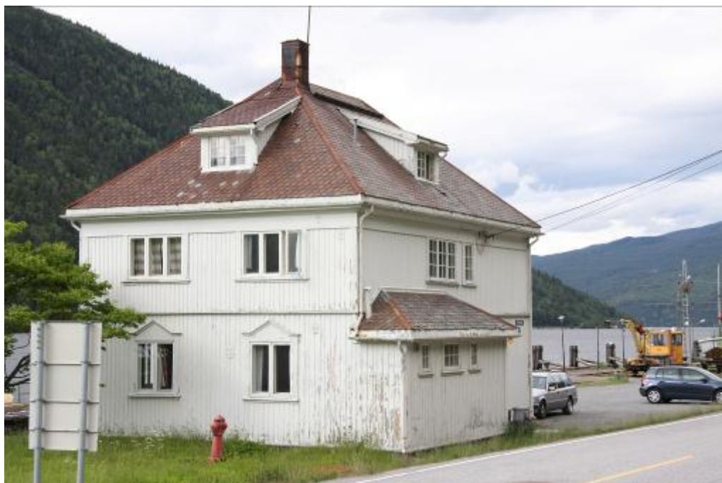
Stasjonsmesterbolig Mæl, sørvestre hjørne.
