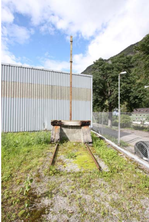
Stoppbukk på Rjukan stasjonsområde ved lokomotivstall.
