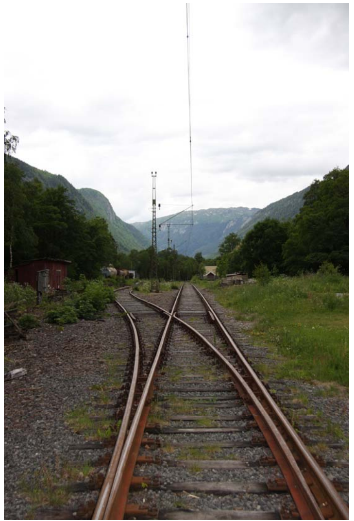
Parti ved innkjøring til Ingolfsland stasjon med tresviller, hey-backfeste, sidespor og KL-anlegg.
