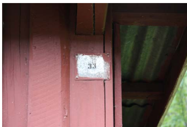
Redskaps- og vedbu, Miland, med Rjukanbanens nummererte skiltmerking av bygg.
