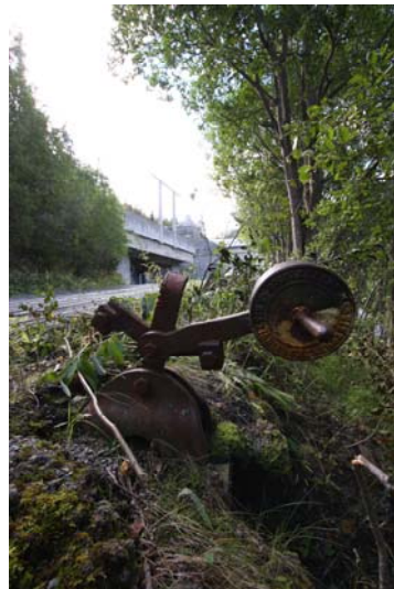
Bevart manuell pensestol med lodd for sporskifte inn til Vemork gamle og Vemork nye kraftstasjon.
