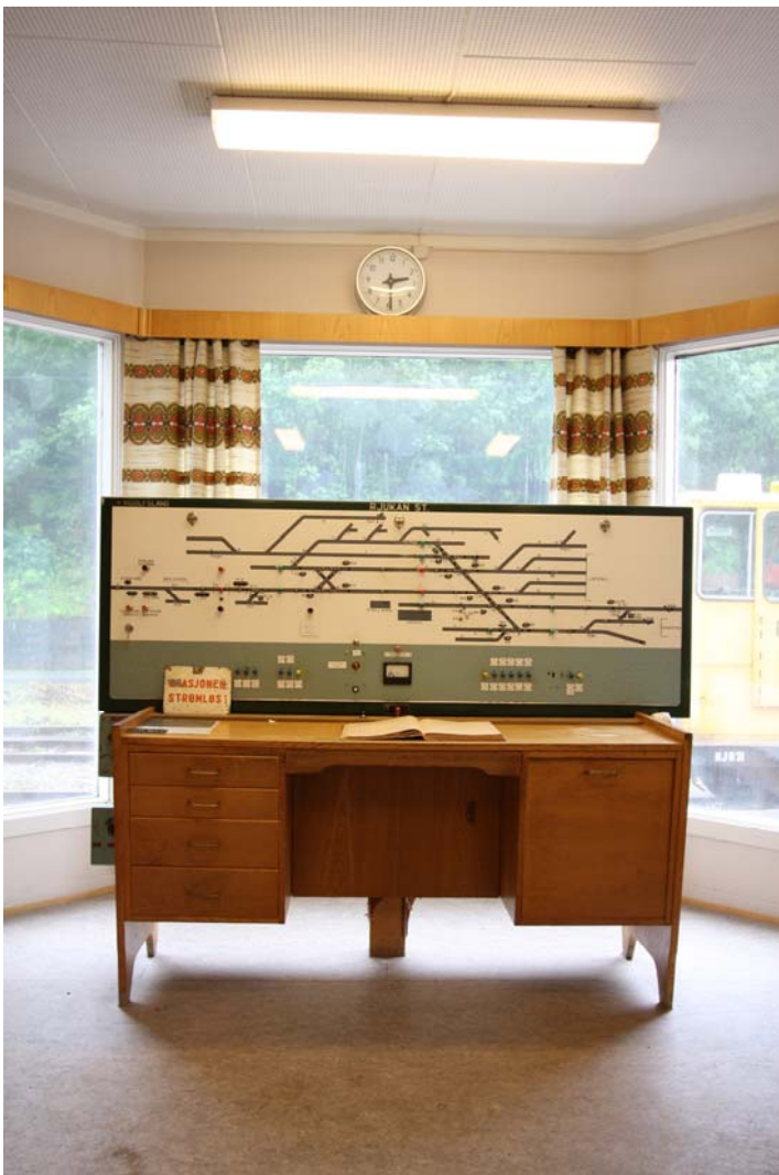
Signalrom og skrivebord med signaltavle.
