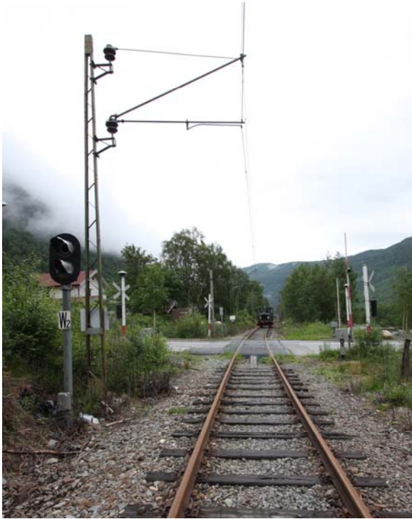
Halvbomanlegg med lyd- og lysignal for sikring av planovergang.
