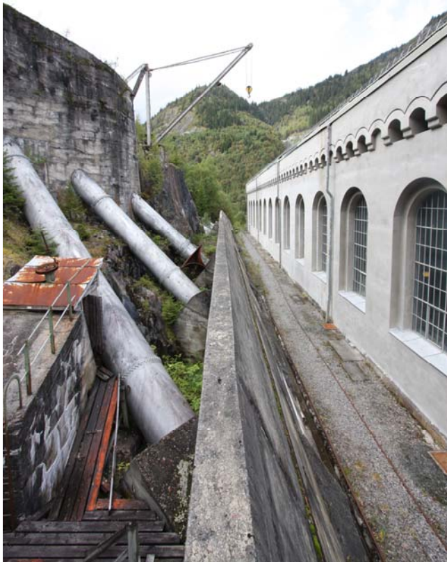
Sporet bak Vemork gamle kraftstasjon med løftekranen som ble benyttet til å løfte turbinrør fra togvognene ved byggingen i 1910.
