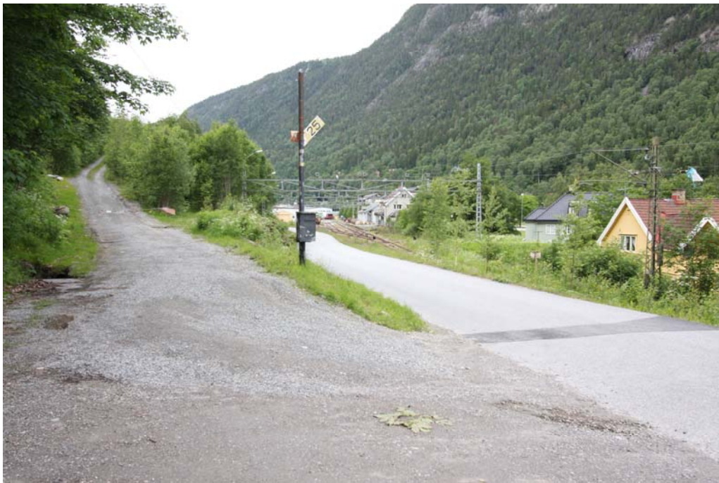
Starten på Vemorksporet nede ved Rjukan stasjonsområde. Stolpe med skap og skilt for stigningsgrad.
