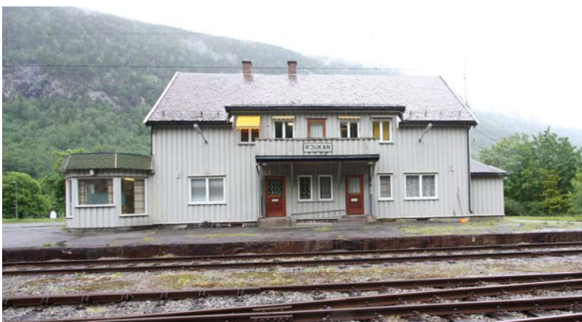
Rjukan stasjonsbygning søndre fasade.
