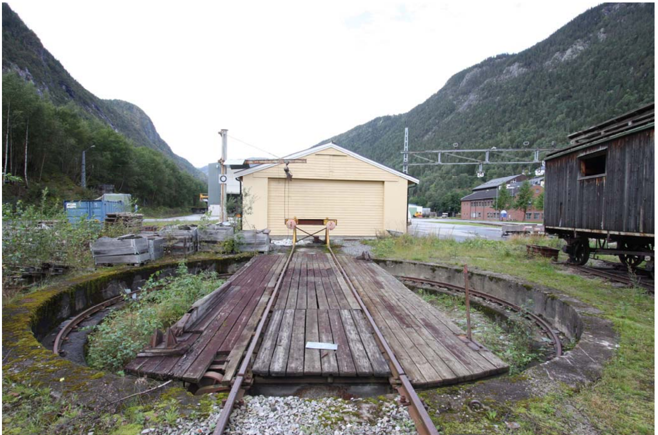
Svingskive og stoppbukk på Rjukan stasjon.
