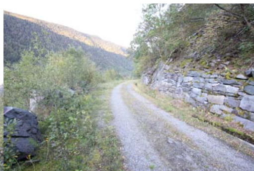
Parti fra øvre del av Vemorksporet med natursteinsmur og vannrenne.
