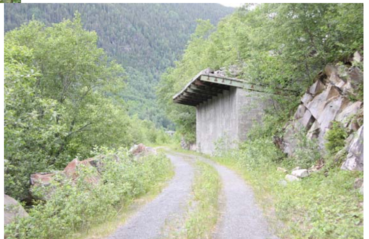
Parti fra øvre del av Vemorksporet med rassikring fra 1964.
