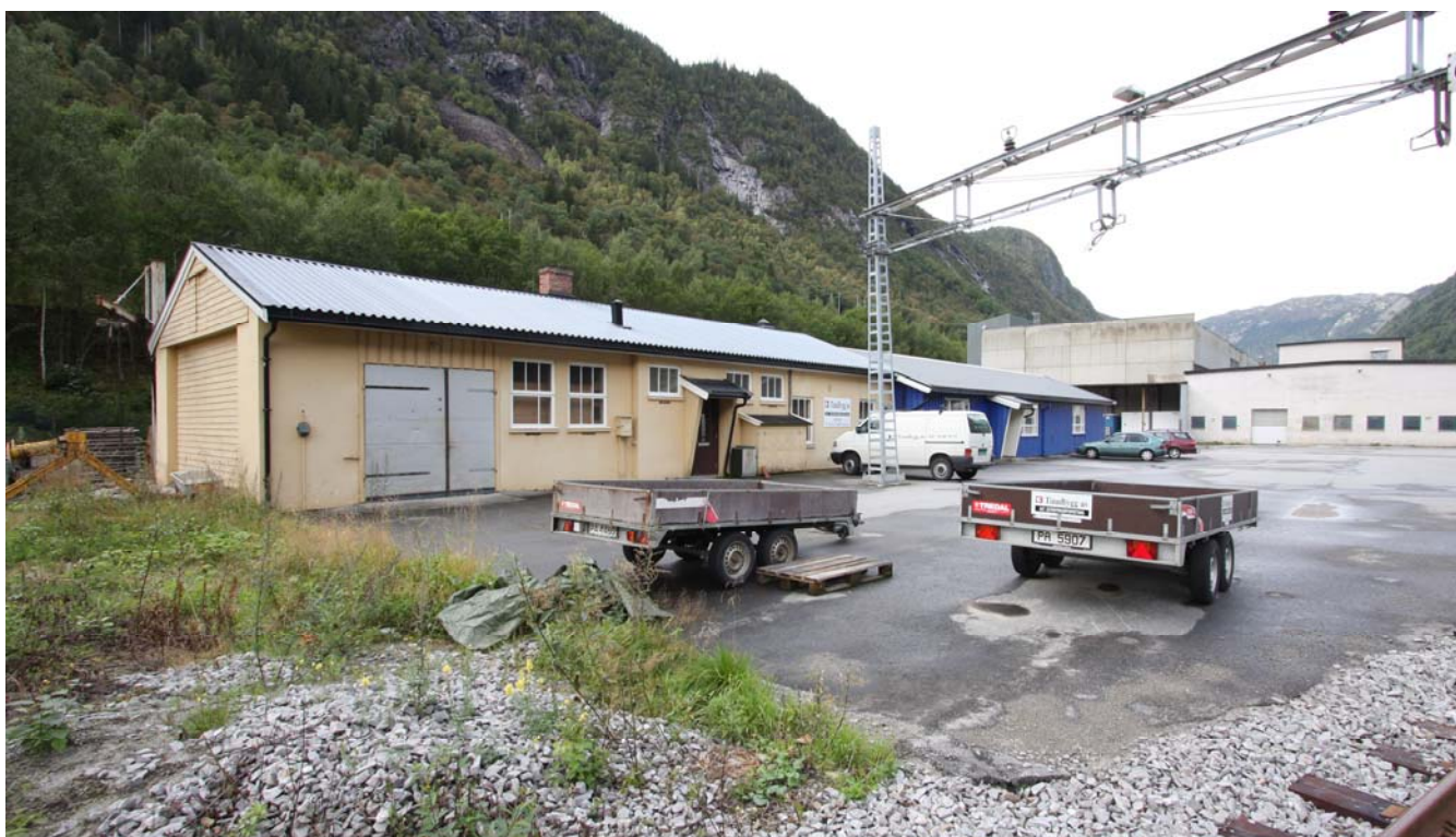
Baneavdelingens verksted nærmest med den blåmalte kontor- og lagerdel en fra 1962 lengst bort.
