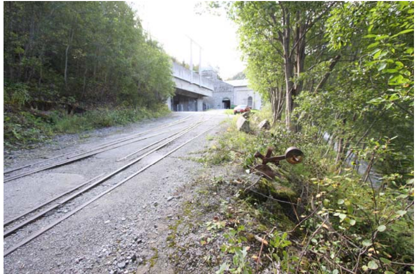
Bevart manuell pensestol med lodd for sporskifte inn til Vemork gamle og Vemork nye kraftstasjon.
