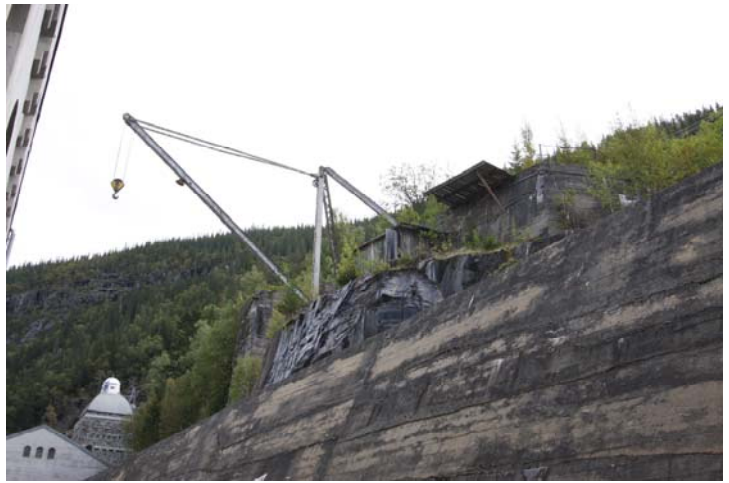
Sporet bak Vemork gamle kraftstasjon med løftekranen som ble benyttet til å løfte turbinrør fra togvognene ved byggingen i 1910.
