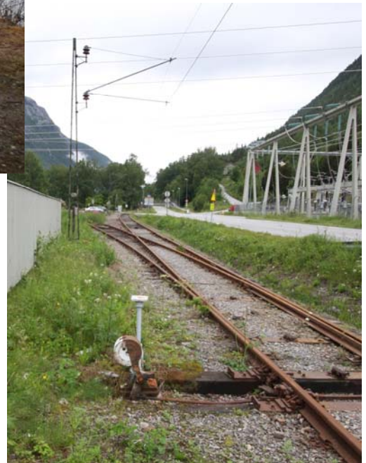
Sporveksel til sidespor Svadde. Manuell pensetol med lodd. Anviserkasse (sporvekselsignal) er borte.
