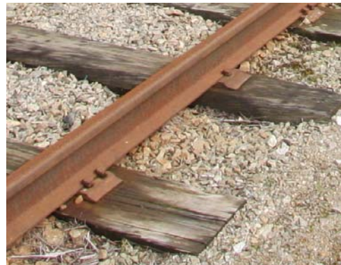
Platefeste med nagler til 35 kg skinne på tresviller. Dette er den eldste festetypen.
