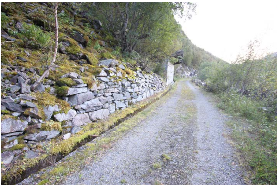
Parti fra øvre del av Vemorksporet med natursteinsmur og vannrenne.
