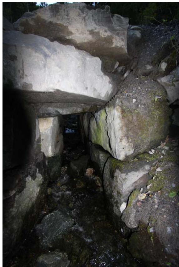
Natursteinsmurte kulverter i nedre del av Vemorksporet.
