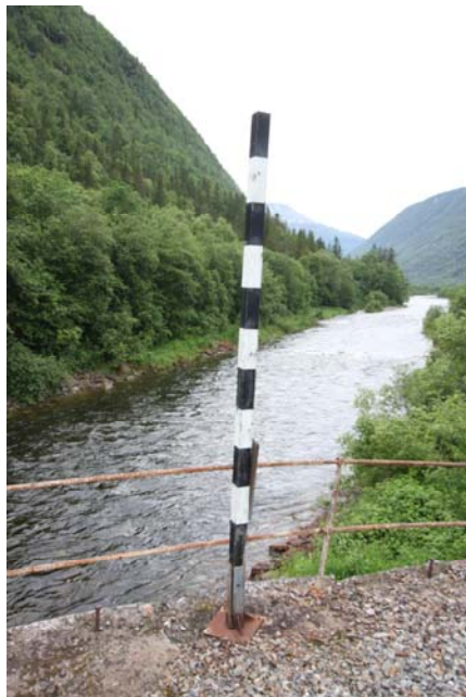
Stolpe som varslers inn-/utkjøring i område med en planovergang.
