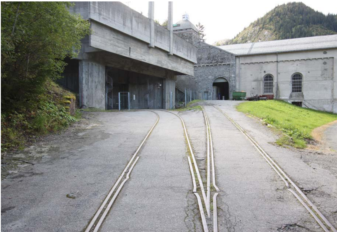
Skinner inn til henholdsvis den nye og den gamle kraftstasjonen på Vemork.
