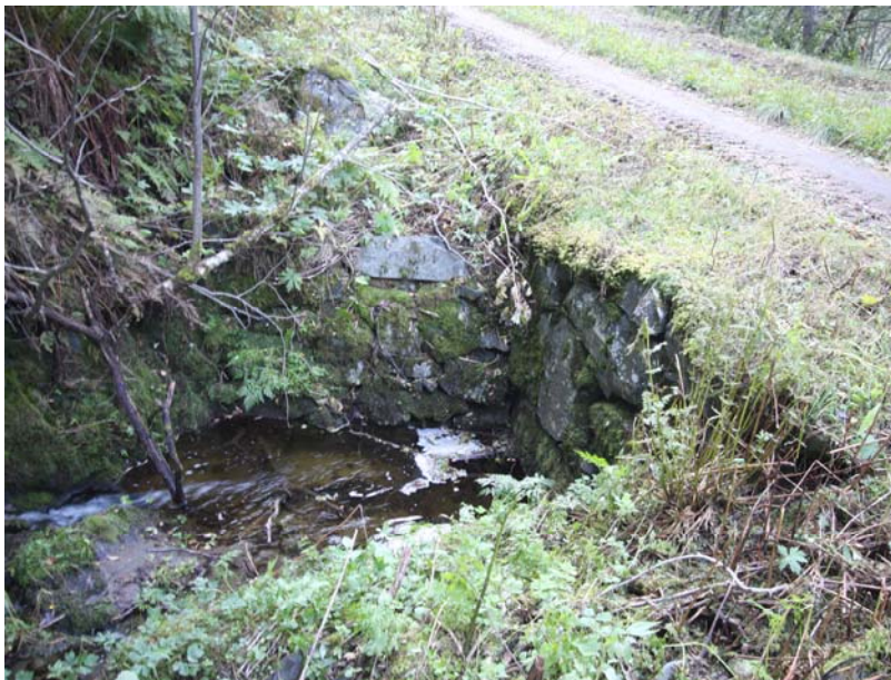
Natursteinsmurte kulverter i nedre del av Vemorksporet.
