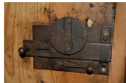
Figur 29. Smijernslås på ytterdør
