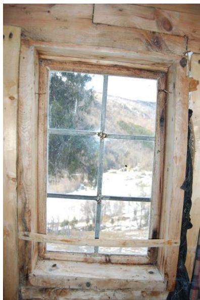
Figur 36. Vindu på vestveggen
