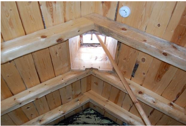
Figur 14. Nytt sperretak med ljore i 2000.
