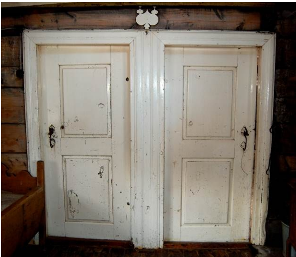
Figur 15. Dører på nordveggen.
