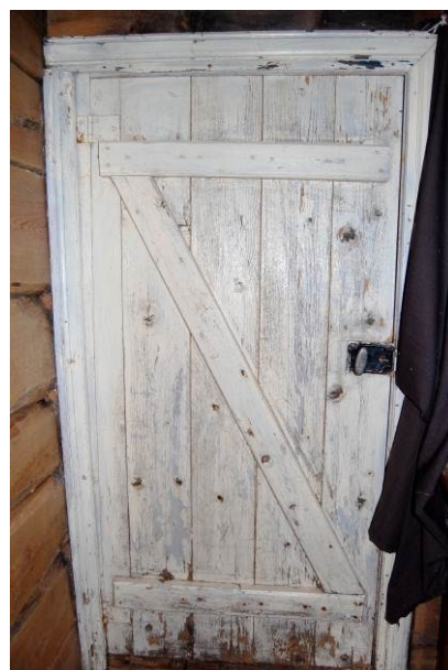
Figur 24. Ytterdør mot øst
