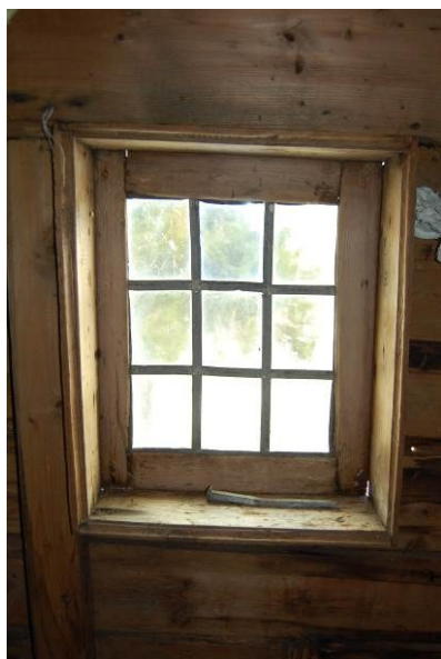
Figur 35. Vindu på vestveggen
