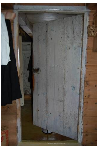
Figur 21. Dør på østveggen
