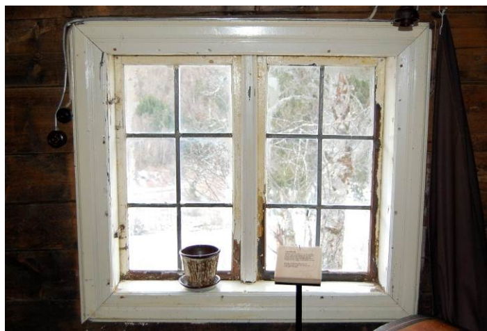
Figur 22. Vindu på vestveggen.
