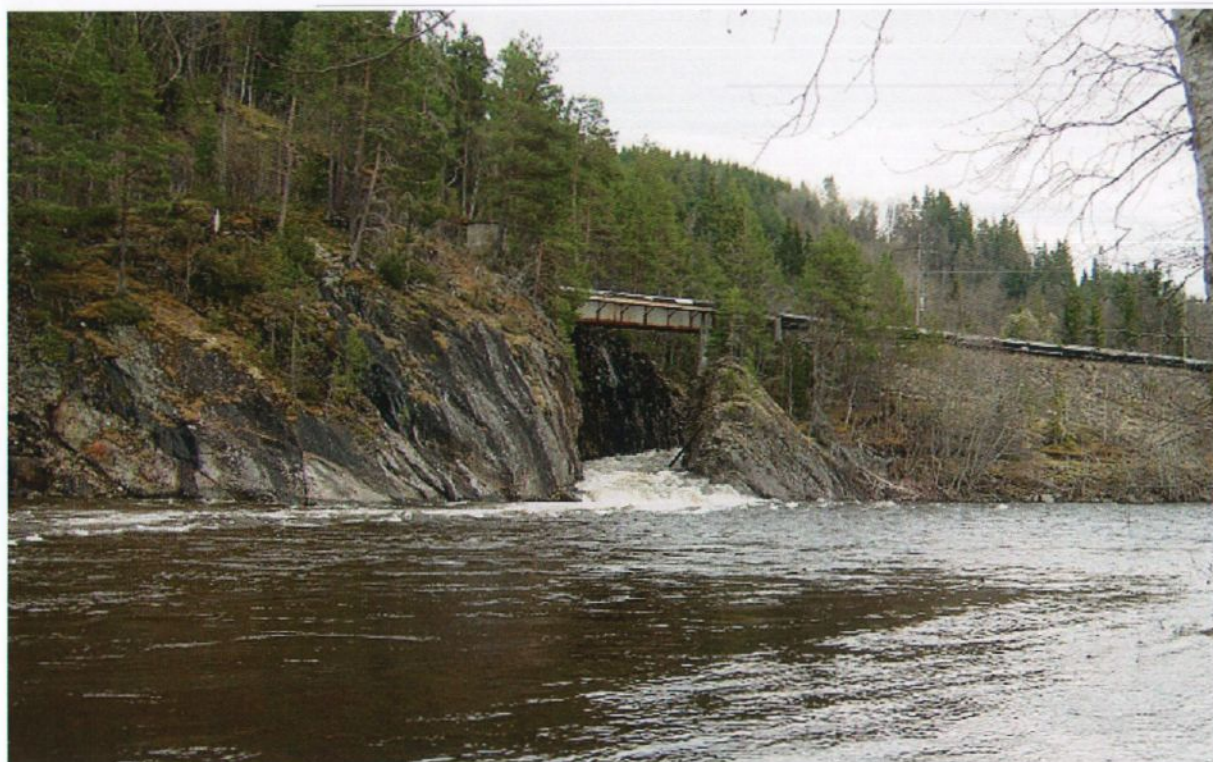
Lengste jernbjelkebru for Thamshavnbanen er over elva Svorka
