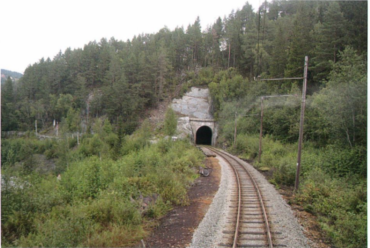
Klinghåmmår'n – Den gamle banetraséen tar av til venstre for tunnelinngangen
