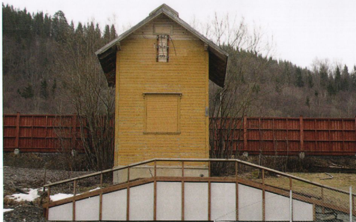
Transformatorhus nord for Orkanger stasjon
