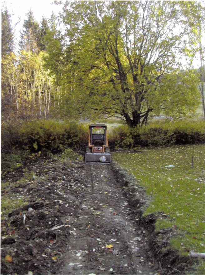
En bobcat med passende bredde på skuffen var et godt verktøy for utsjakingen.
