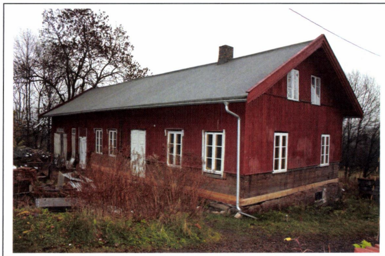
Drengestuen etter at nødvendig utbedring er foretatt
