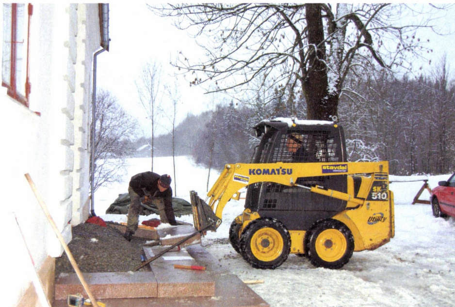
Arbeidet med å montere det nye trappereposet er i gang. Arbeidet gjøres av Espen Marthinsen i MurIng som har spesiell kompetanse på antikvarisk murarbeid.
