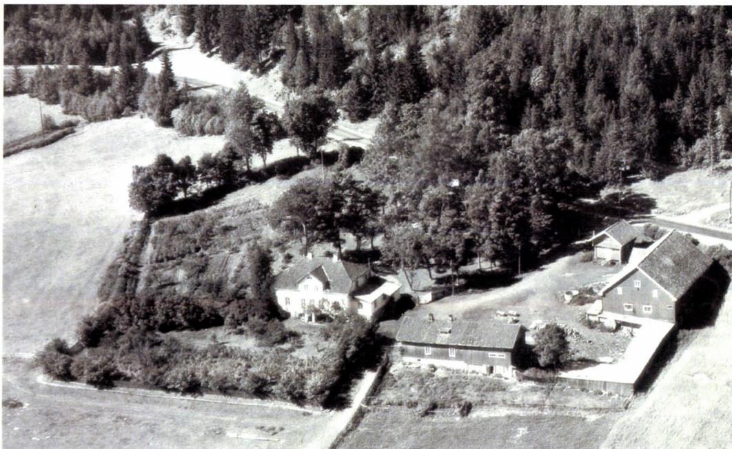
Eiendommen fotografert fra fly på 40/50-tallet. Det er lett å se feltene for dyrkning av bær, grønnsaker og frukttrær. Det er også mulig å se noen av hagestiene dersom man forstørrer bildet opp.
