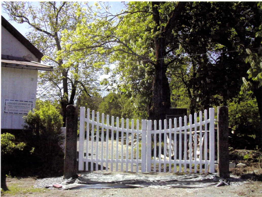
Portstolpene til sideporten er gjeninnsatt, porten er montert og malt på dugnad.
