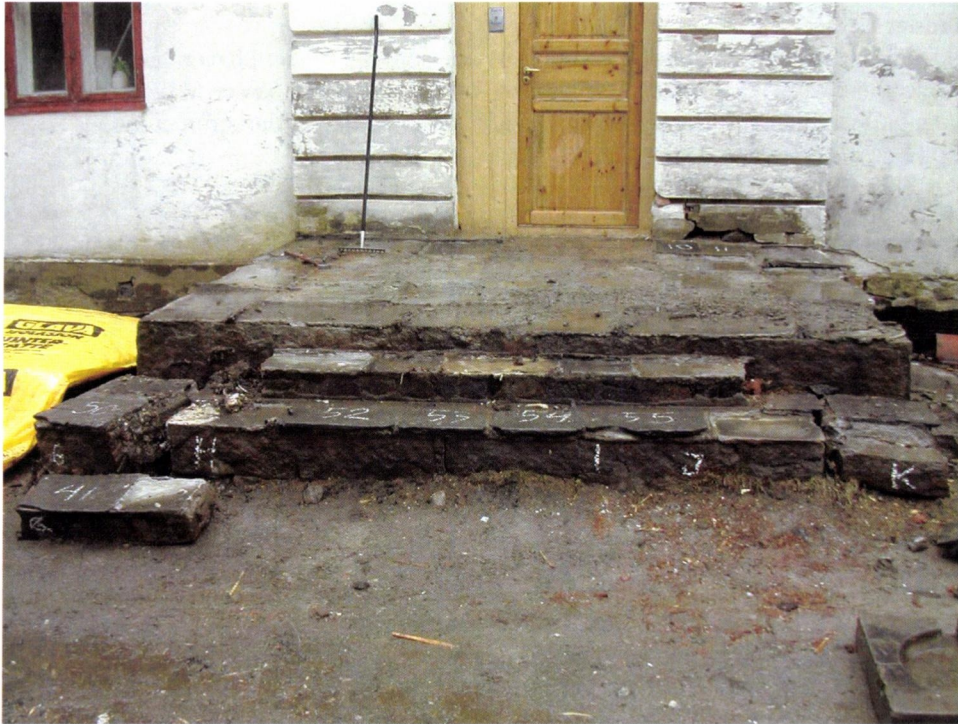
Reposet som tilhørte den tidligere glassverandaen demonteres.
