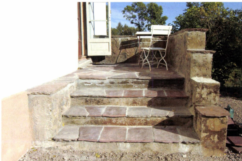
Hagetrappen / terrassen er restaurert med samme type dekke av Ringeriksskifer slik den har vært opprinnelig. Gammel stein som ble funnet ved terrassen er plassert tilbake.
