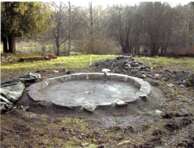
Dammen er ferdig støpt! Høst-2006 (retursil i bakkant står høyt fordi den ikke er kappet ned enda.)
