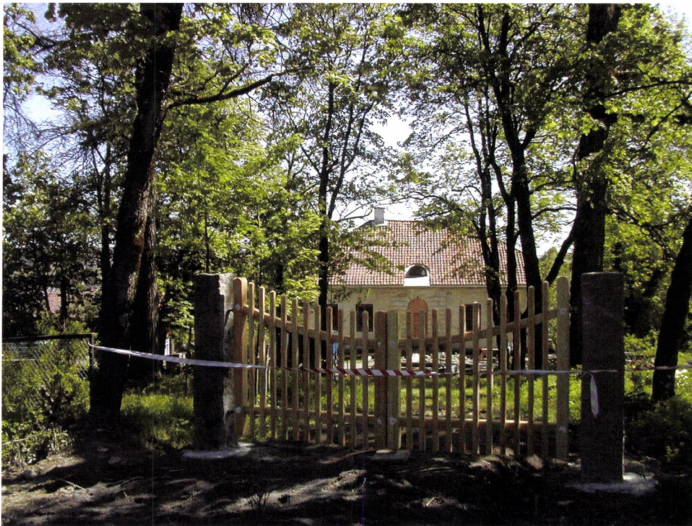
Portstolpene til hovedporten er gjeninnsatt og den rekonstruerte porten er montert.
