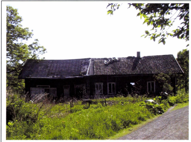
Drengestuen før restaurering
