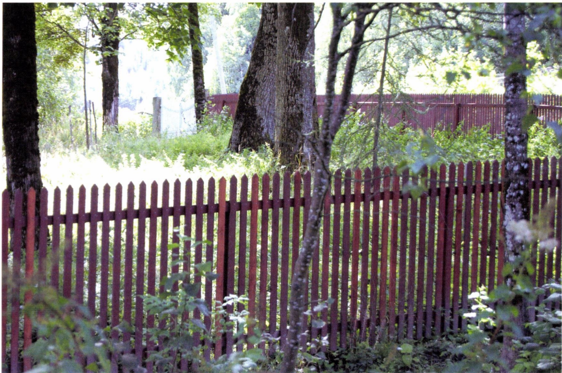
Det rekonstruerte hagegjerdet gir den gamle hagen en stemningsfull ramme.
