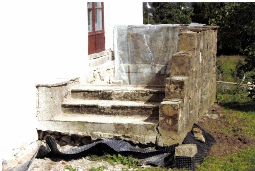
Hagetrappens / terrassens konstruksjonen forbedres.
