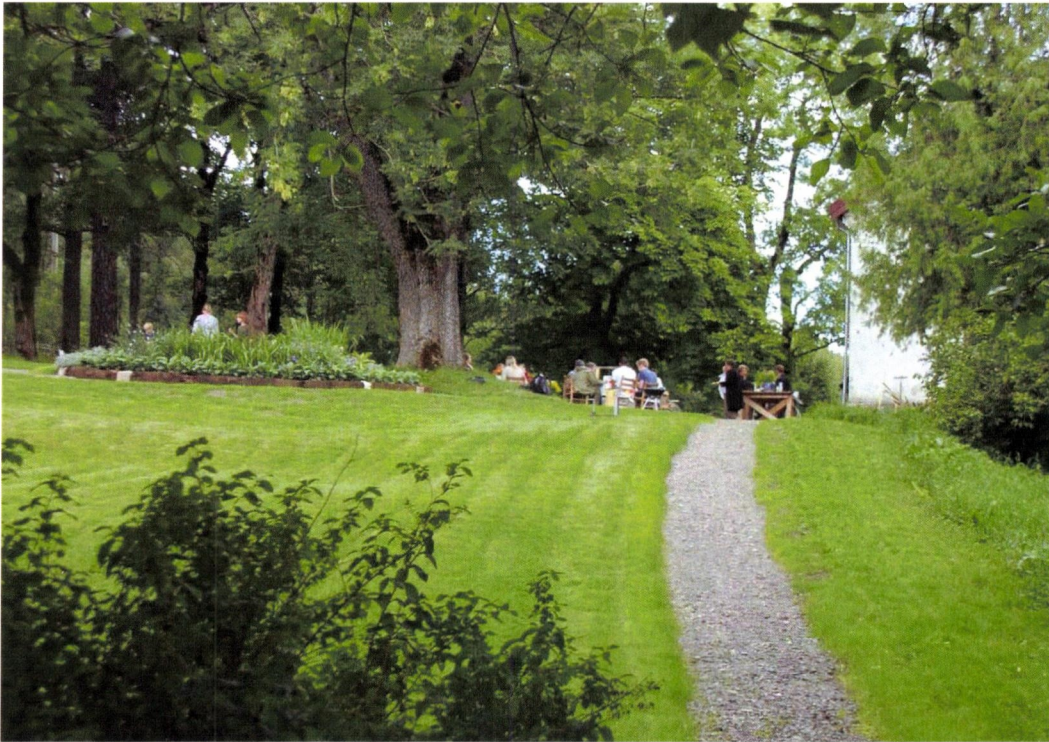
Bæringslaget er ferdig lagt. Gresskanten er grodd til og klare til skjæring i riktig bredde: 120 cm.
