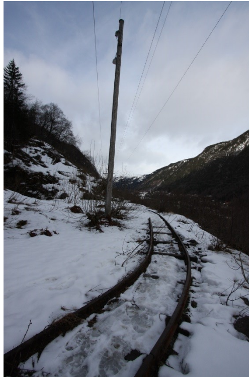
Trallebanen går i en bue mellom innslag B og C. Trestolpe med lysarmatur.
