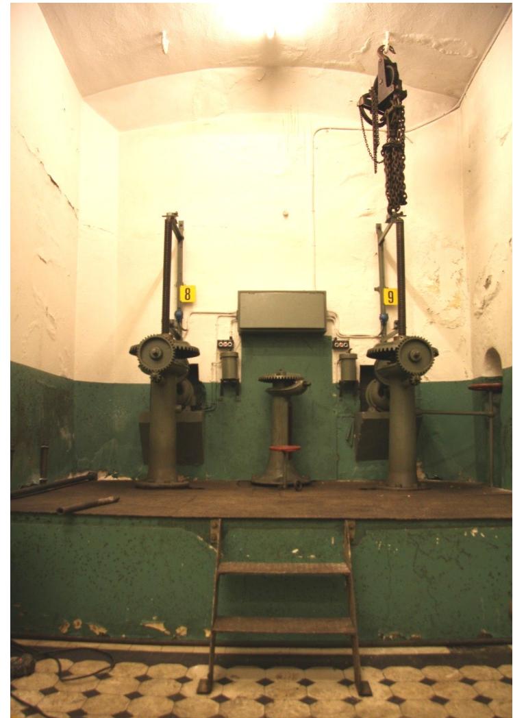
Nisje med ventiler til inntaket fra rørgaten.
