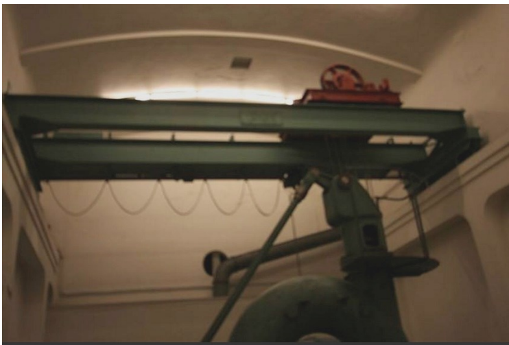
Over og under: Traverskran for 4 tonn i taket.
