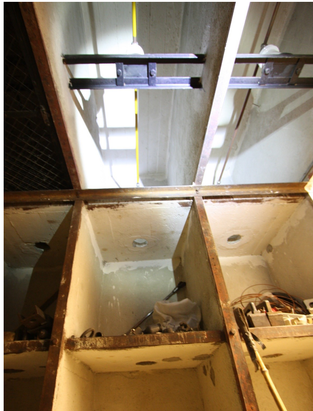
Kanaler i taket med rør og isolatorer mellom cellene.
