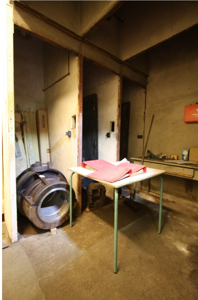
Tre tomme celler i midtseksjonen har vært for effektbrytere. Disse er fjernet.
