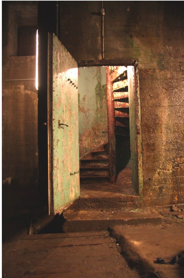
Vindeltrappen med døren opp til maskinhallen.
