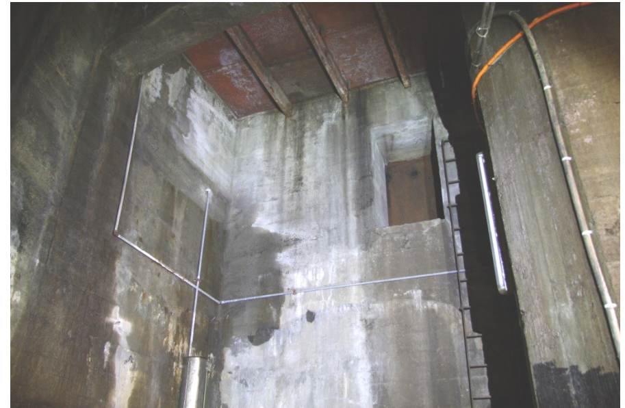
Heissjaktens luke. Vegg er vegg mot vannmagasinet.
