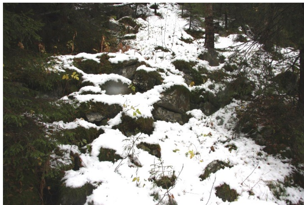
Sluskedilten er stedvis bygd opp med støttemurer i naturstein. Her eksempler fra nedre del.
