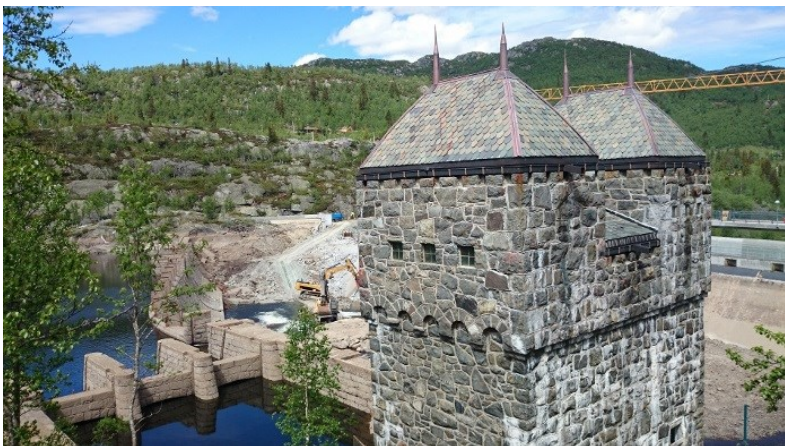
Lukehuset og deler av damkonstruksjonen.
