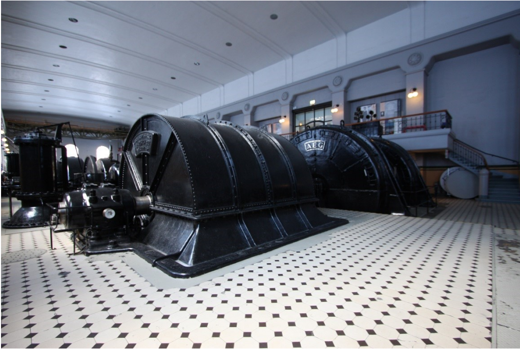
Over: (12.3) Turbin nr. 6 fra Escher Wyss 1909. Ventil ses i bakgrunnen til venstre. Under: generator fra AEG med magnetiseringsmaskin.
