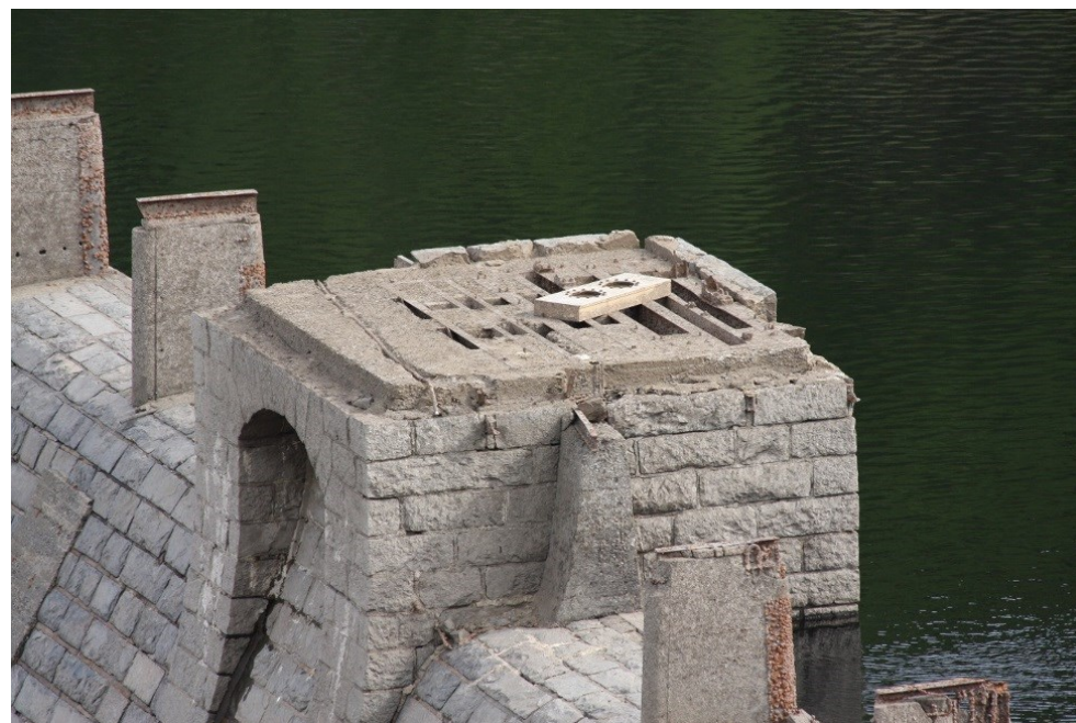
Detalj av damkonstruksjonen hvor huset på damkronen er tatt bort.
