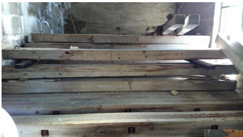
1.1. Demontert bjelkelag fra bjelkestengselet er bevart og lagret i lukehuset.
