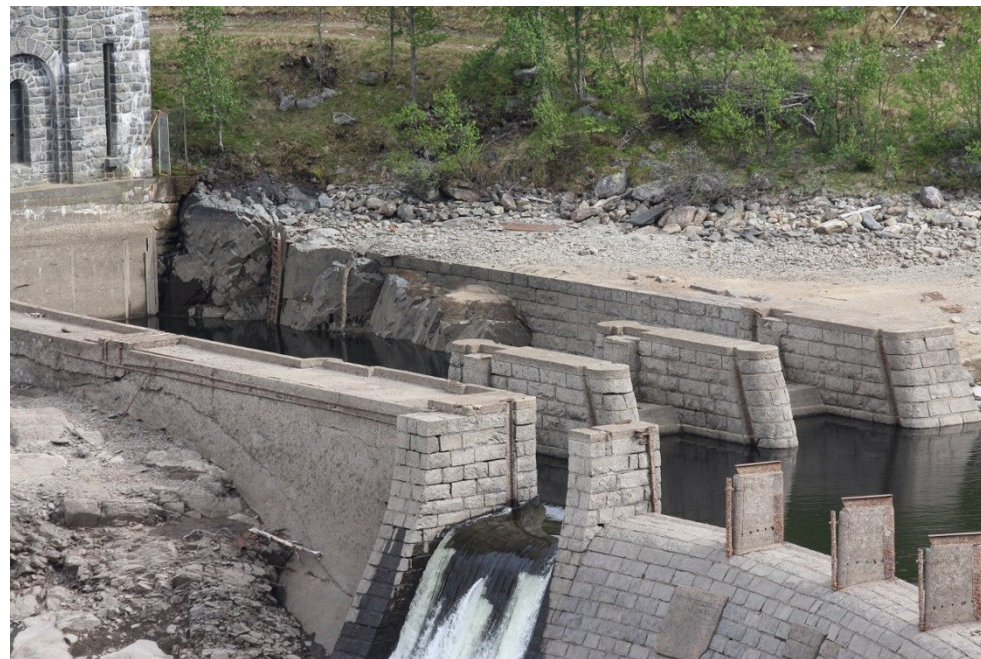
Damkonstruksjonen ved selve inntaket. Varegrindene er borte.
