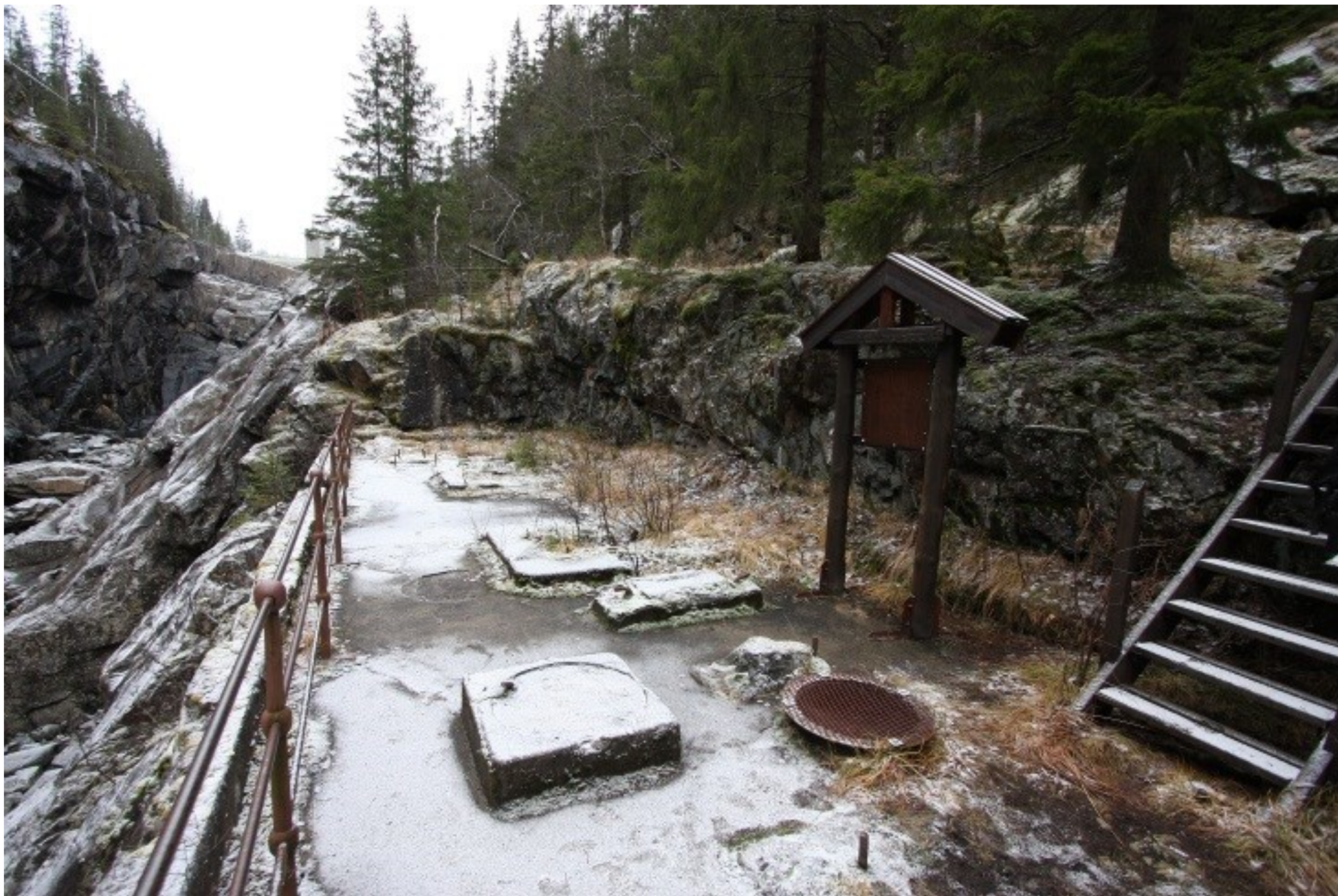
(16.1) Kvernhusfossen kraftstasjon, rester av stasjonsgulv og aggregat-fundament.
