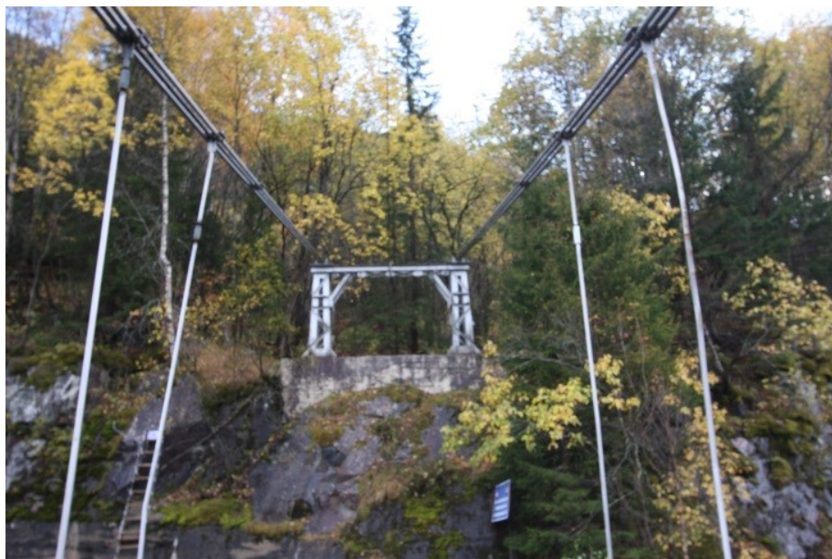
Brofundament og bærestativ på Vemork-siden av juvet.
