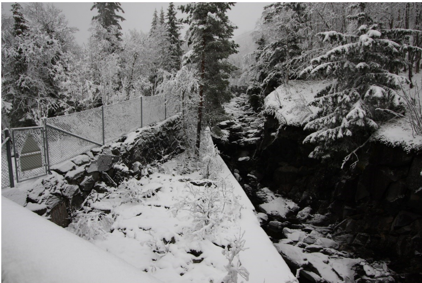
Omløpskanalen sett opp mot Vemork topp fra enden av kanalen ved åpningen for «Brudesløret».
