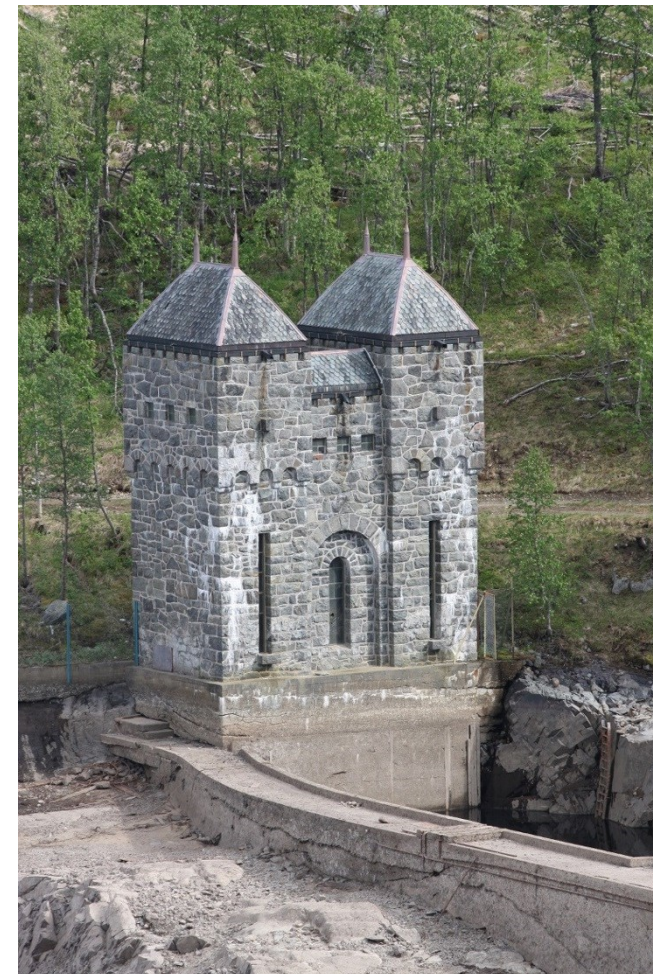
Lukehuset med gjenstøpt åpning i fundamentet og deler av inntaket.
