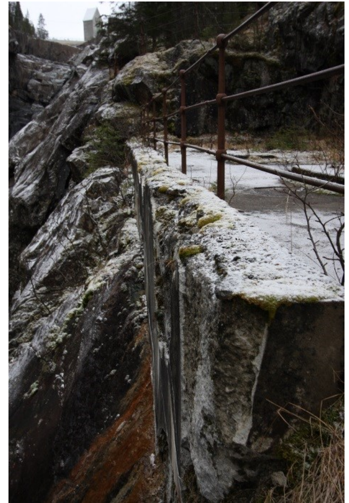
Kraftstasjonens grunnmur mot Måna.
