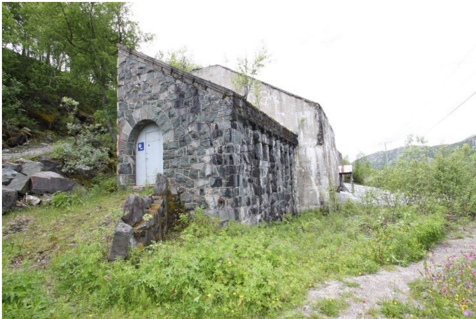
Ventilkammerhuset i øst med inngang, tilbygg fra 1912.
