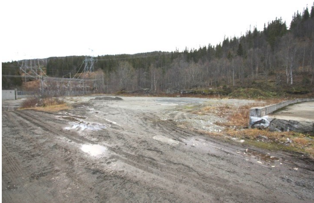
Den gruslagte plassen hvor fordelingsbassenget er gjenfylt og bygningene revet.
