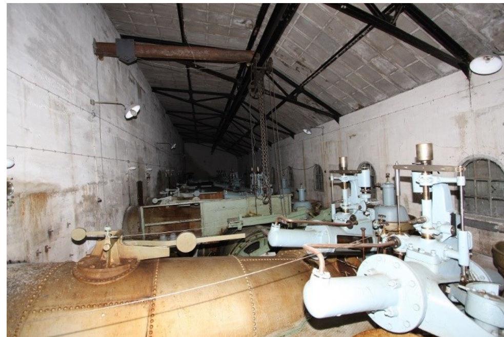
Ventilkammerhusets interiør sett mot vest med rørene og ventilene (10.2.). Mekanisk lukking (10.3.) ses til venstre på det nærmeste røret.
