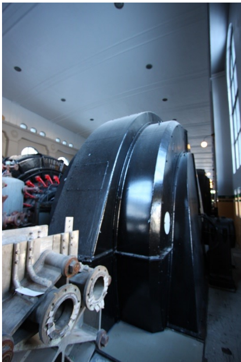
Over og til venstre: Aggregat nr. 10 med en ekstra trefasegenerator fra Oerlikon som kom til i 1940-årene. Den eldre likestrømsgeneratoren fra 1929 ses ved siden av.
