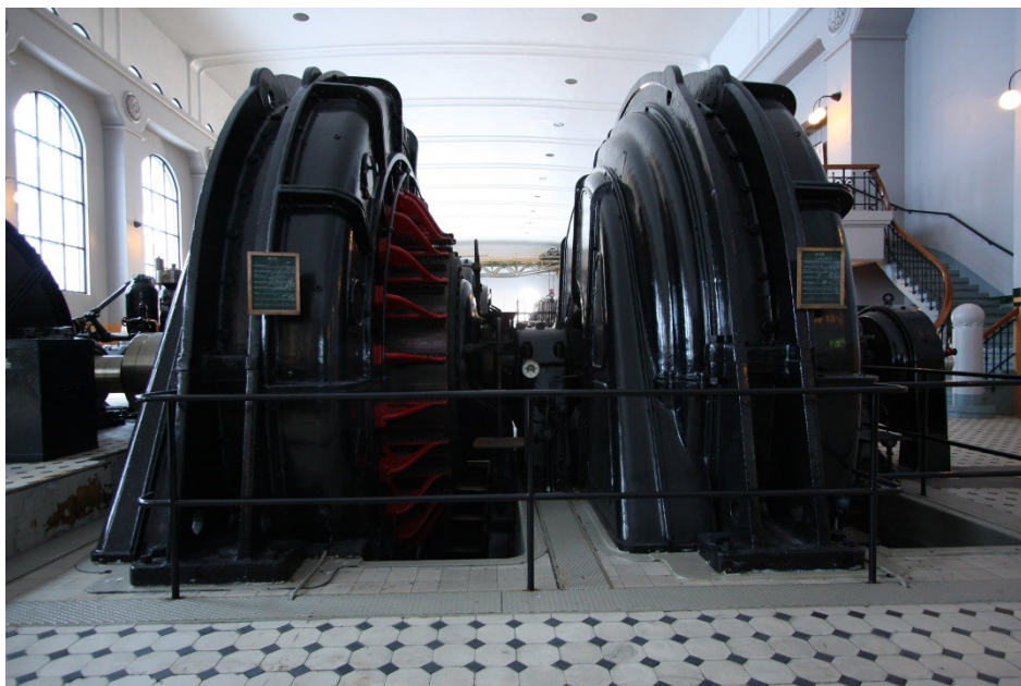
Over: aggregat 7 med turbin fra Escher Wyss og generator fra Oerlikon. I front ses turbinens ventiler (1909). Aggregat 7-10 er like. Under: generatoren fra Orelikon fra 1929.
