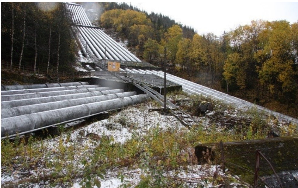
Over og under: Parti fra nedre del av rørgata (11.1) med betongkonstruksjon rundt rørene (11.2). Trallebanens (11.4.) slutt punkt over.
