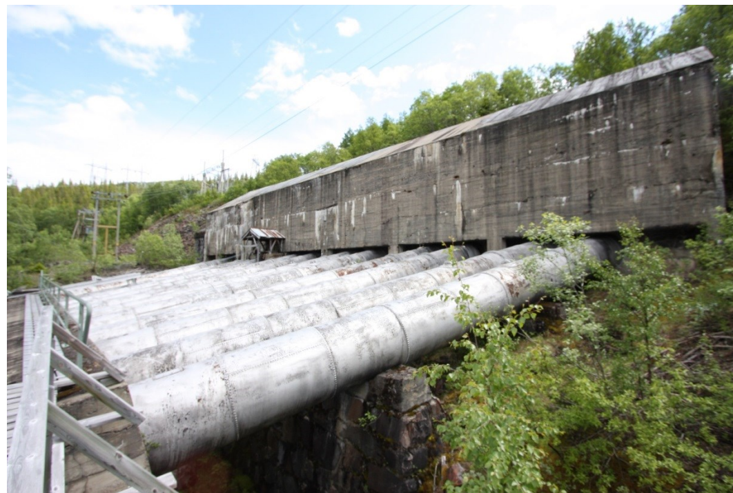
Ventilkammerhuset i dag med betongskallet fra 2. verdenskrig rundt.
