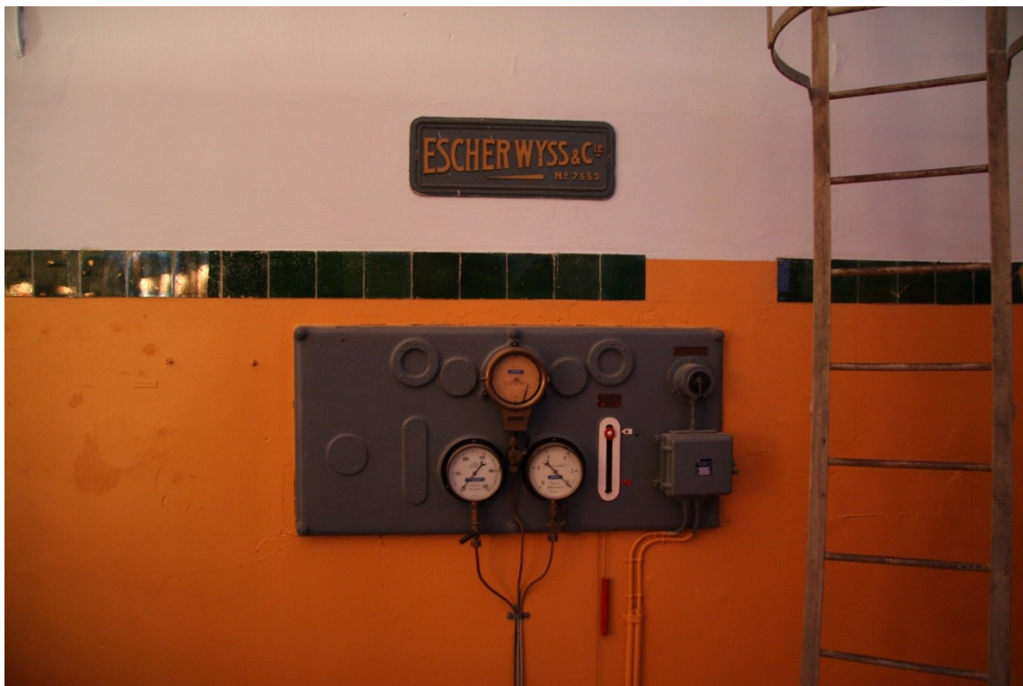
(13.1) Skilt og målere for turbin nr. 11 til venstre og nr. 12 over. Turbin 11 er fjer-
