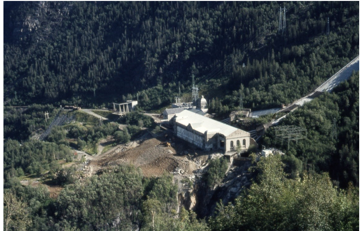
Området med Hydrogenfabrikken under opprydningen etter rivningen. Foto: NVE.
