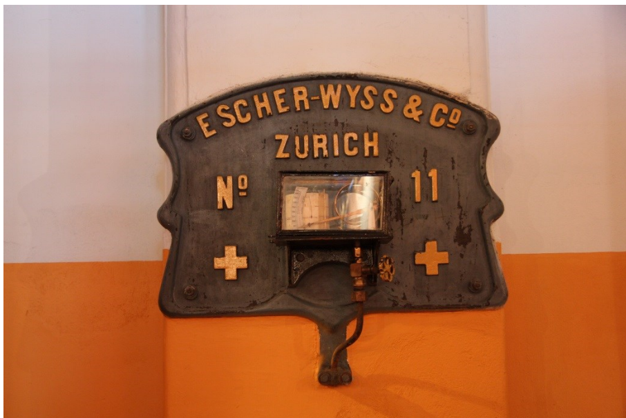
(13.1) Skilt og målere for turbin nr. 11 til venstre og nr. 12 over. Turbin 11 er fjer-
