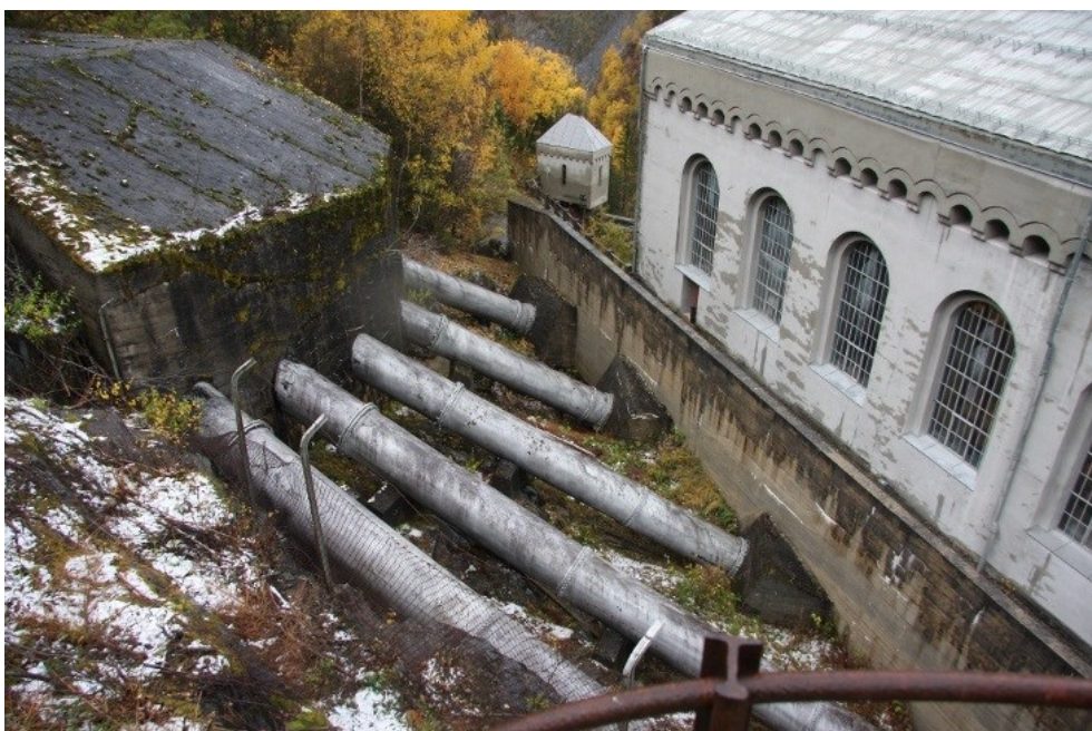
Over og under: Parti fra nedre del av rørgata (11.1) med betongkonstruksjon rundt rørene (11.2). Trallebanens (11.4.) slutt punkt over.
