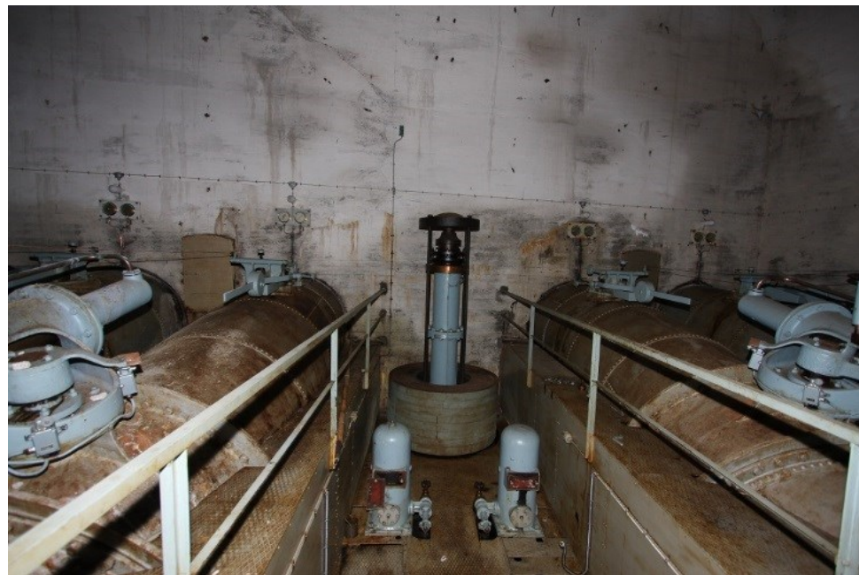
(10.4.) Hydraulisk lodd for oljetrykkfall.
