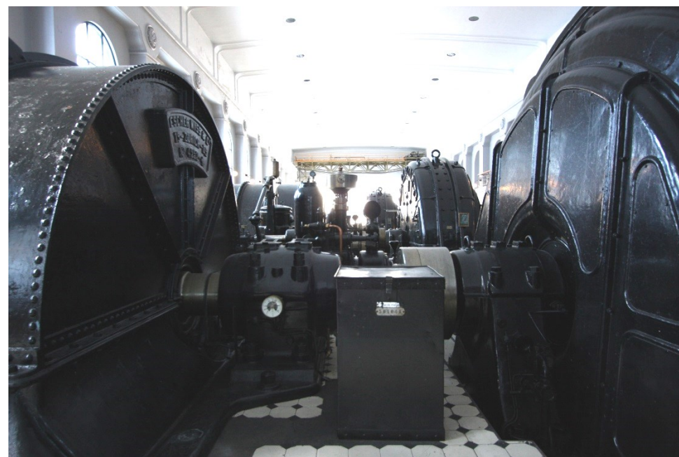
Over: Generator fra Oerlikon med magnetiseringsmaskin. Under aksling mellom turbin og generator med bevart beholder for maskinolje i front.
