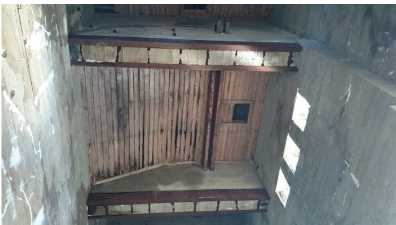
1.2. Takkkonstruksjonen i lukehuset med jerdrauger for feste til bjelkestengsel.
