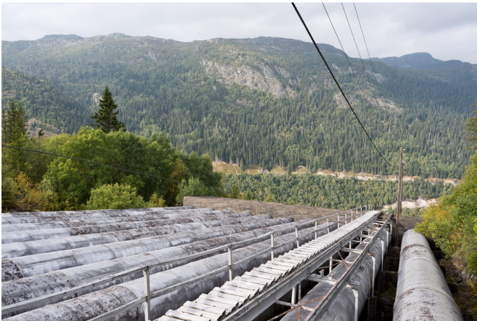
Parti fra toppen av rørgata med trapp (11.3.) og trallebane (11.4.). Trallebanen er plassert på et klinket stativ. Foto: Per Berntsen
