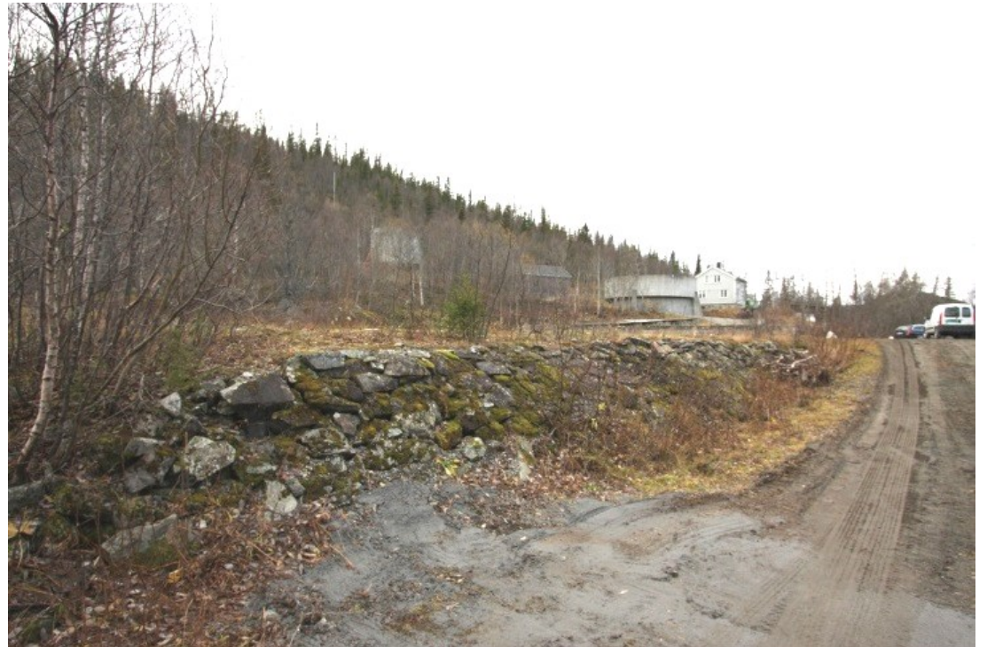
Støttemuren i naturstein i forkant av lukehuset er godt bevart.
