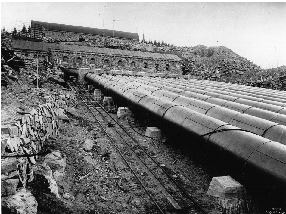
Ventilkammerhuset med lukehuset på toppen bak ved ferdigstillelse i 1911.
