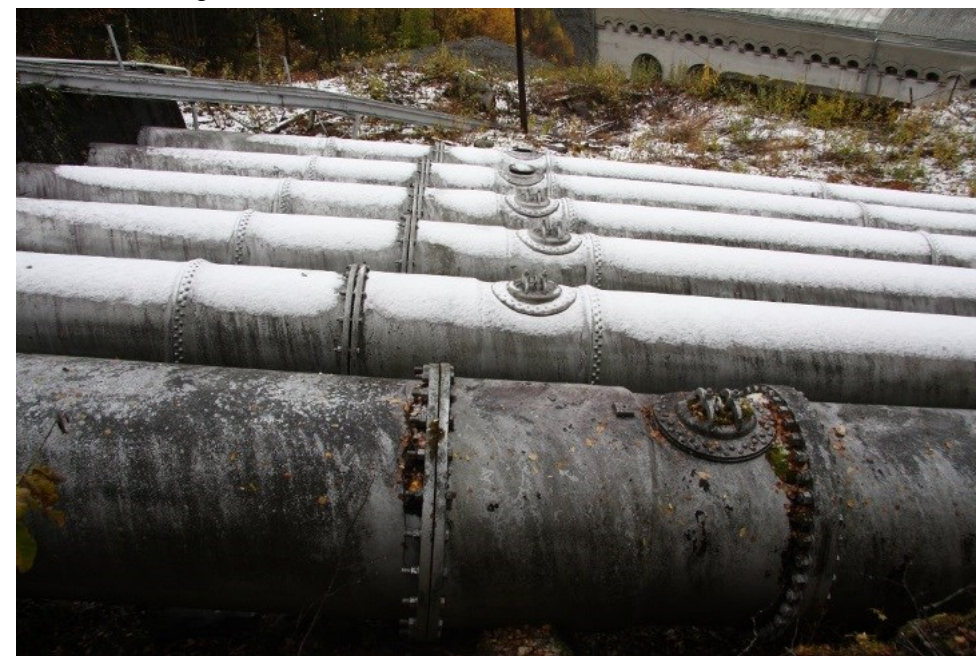
Nedre del av rørgata med det 11. røret nærmest.
