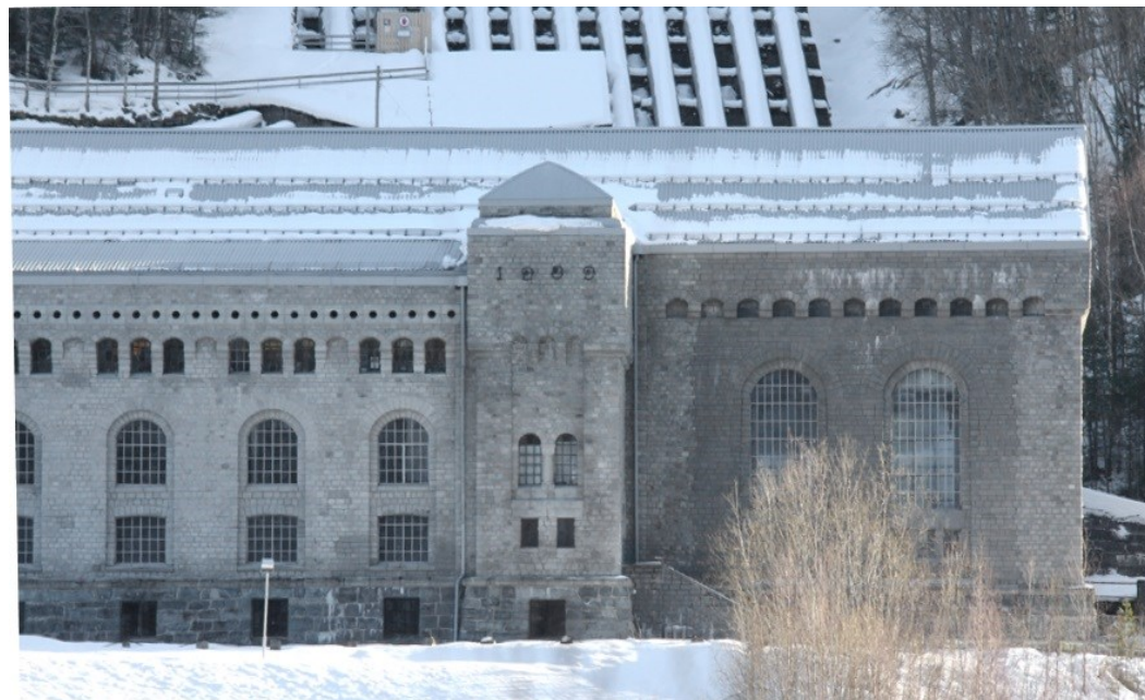
Den vestre enden av kraftstasjonsbygningen hvor en tydelig ser det gjenoppbygde partiet med mørkere stein fra 1977-1978. Denne delen av bygningen ble ødelagt under sprengingen av Hydrogenfabrikken
