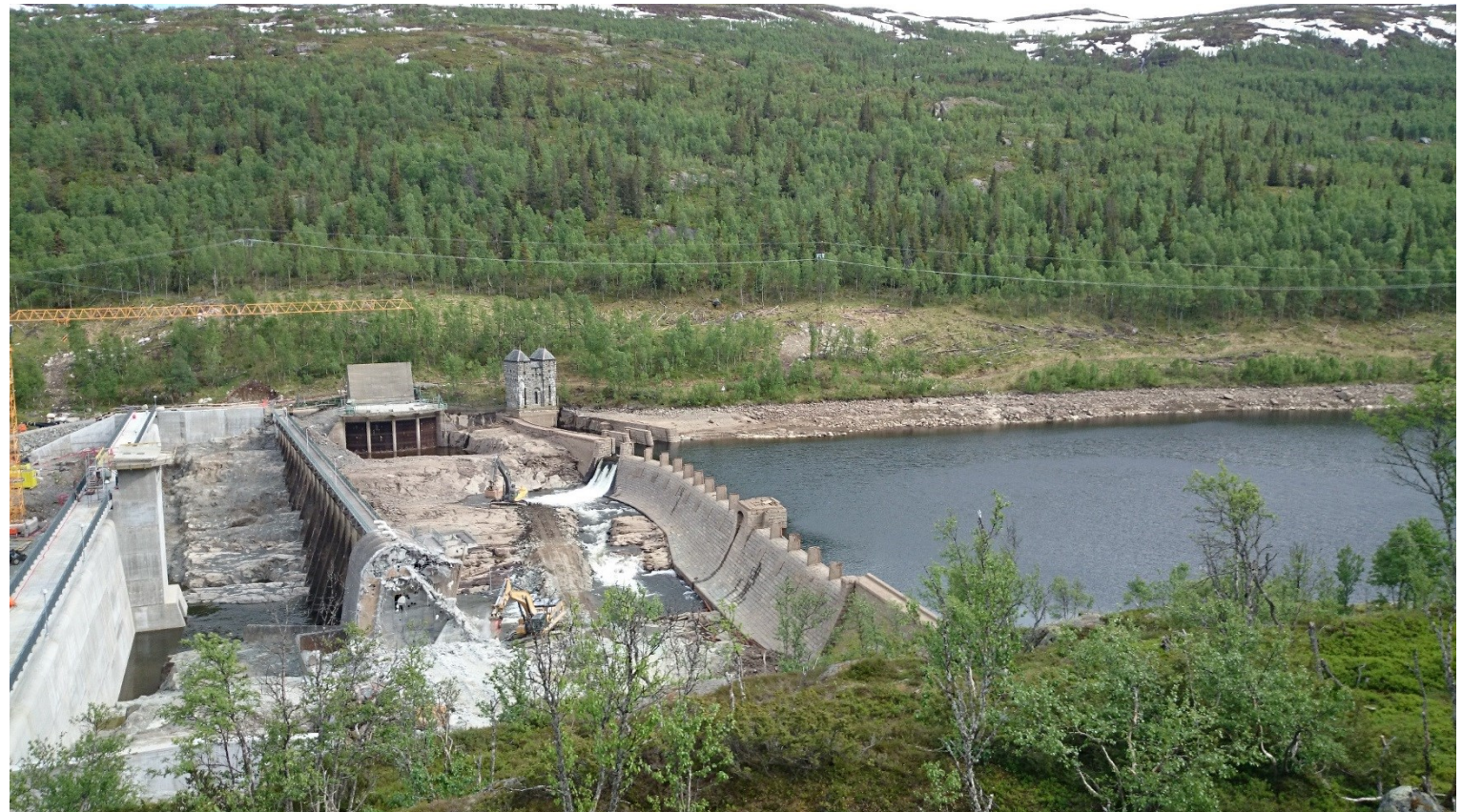
Skarsfosdam I med lukehus lengst til høyre, dammen fra 1950-årene rives i midten og ny dam fra 2014 til venstre.
