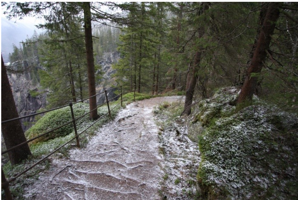
Parti ut mot juvet med støpjernsgjerde i opprinnelig utførelse.
