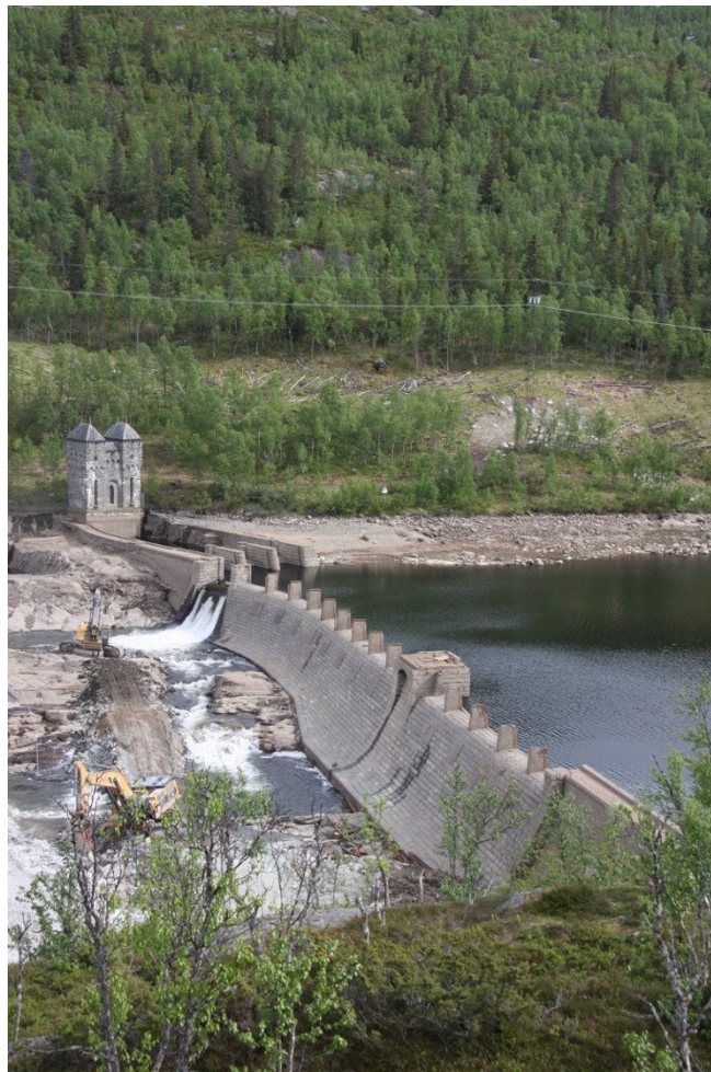
Skarfosdam I med lukehus når vannet er tappet ned.
