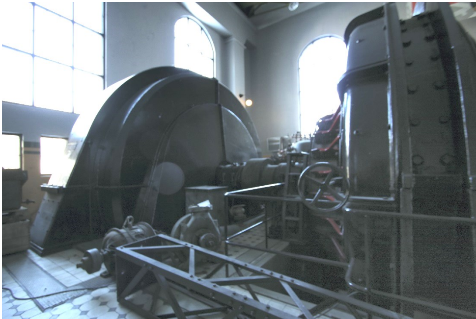
Over og til venstre: Aggregat nr. 10 med en ekstra trefasegenerator fra Oerlikon som kom til i 1940-årene. Den eldre likestrømsgeneratoren fra 1929 ses ved siden av.
