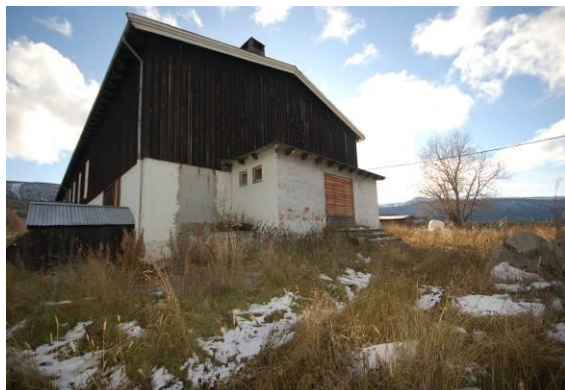
Figur 11 Bygningens nordlige fasade med tidligere inngang. Foto: Magnhild Apeland
