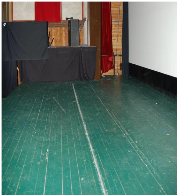
Figur 34 Scenegulv med lysgrav.
