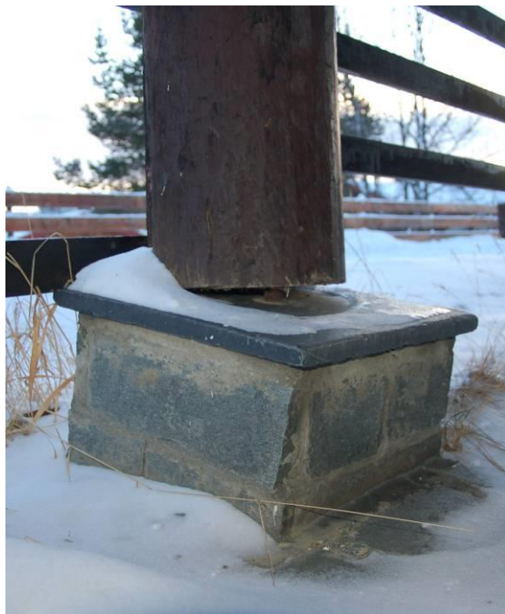
Figur 9 Trestolpe og murt fundament.
