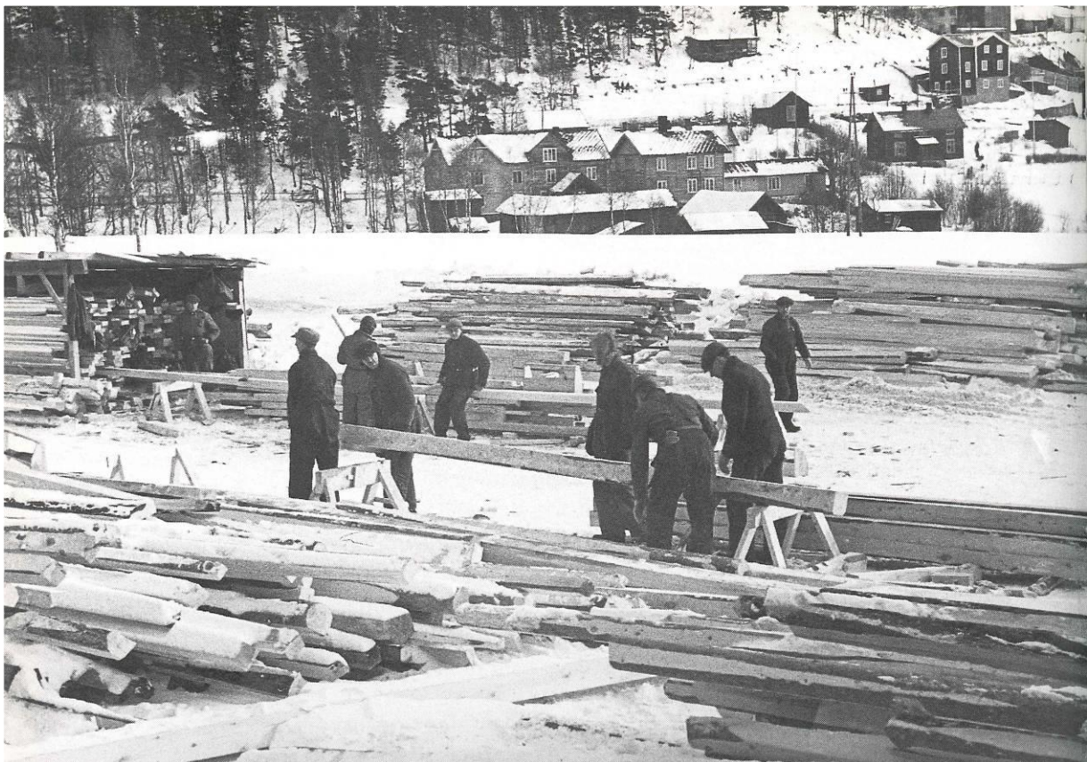
Figur 4 Bygging av brakker på Dombås under krigen. Bildet er tatt mot sentrum og jernbanestasjonen. Hentet fra Årbok for Gudbrandsdalen 1996
