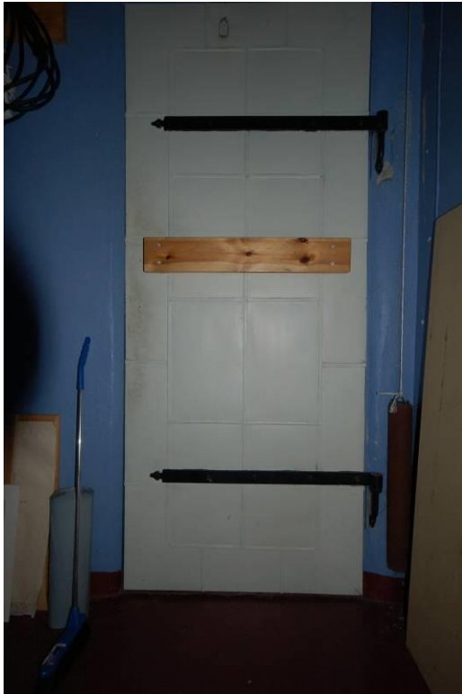
Figur 24 Original dør inn til maskinrommet. Foto: Magnhild Apeland
