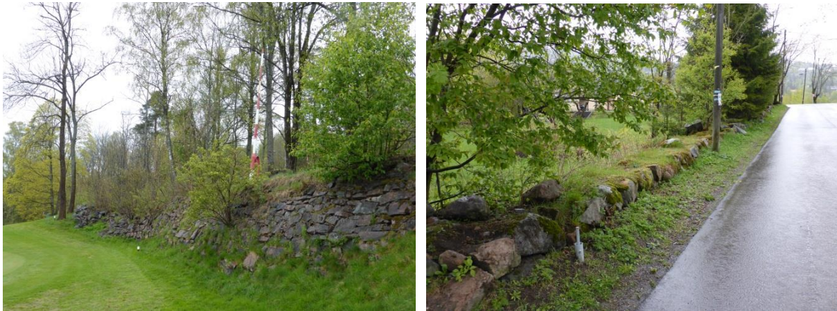
Forstøtningsmur på vestre side av Sørkedalsveien, ved veiskillet mellom nye og gamle Sørkedalsvei (til venstre). Bildet til høyre viser steingjerdet ved Vestre Portstue. Foto: May Britt Håbjørg © Riksantikvaren, 7.5.2014.
