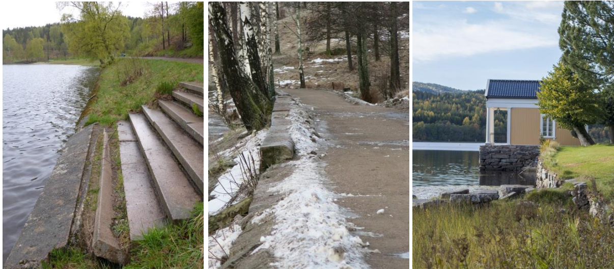
Steintrapp fra gamle Sørkedalsvei ned til Bogstadvannet like sør for badeplassen. Langs vannet er det en kant av pussete betongelementer (til venstre). Bildet i midten viser deler av «Privatveien» fra badeplassen og nordover. Veien er kantet med elementer av pusset betong og stein. På begge sider av hagepaviljongen, i hele den gamle prydhagens bredde, finnes en forstøtningsmur langs vannkanten (til høyre). Foto: May Britt Håbjørg © Riksantikvaren, 7.5.2014 og 17.2.2014. Foto til høyre: Dagfinn Rasmussen © Riksantikvaren, 2.10.2014.
