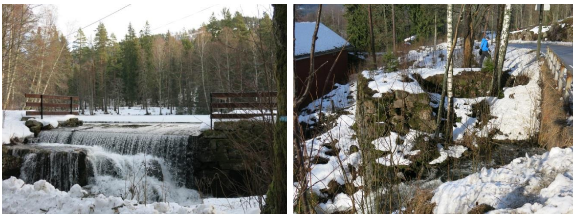
Demningen ved Jegersborgdammen (til venstre). Bildet til høyre viser rester av mur mellom Maskinlåven og Sørkedalsveien, mest sannsynlig en tidligere demning. Foto: May Britt Håbjørg © Riksantikvaren, 17.2.2014.
