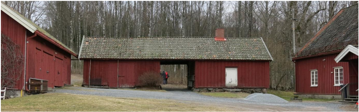
Bryggerhus og uthus på Strøm. Foto: Bård Langvandslien © Riksantikvaren, 27.3.2014.
