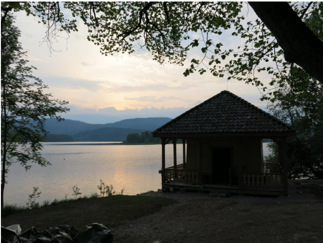
Fiskerhytten. Foto: Byantikvaren, 1975 (øverst til venstre), og Bård Langoandslien © Riksantikvaren, 27.3.2014 og 26.5.2014.
