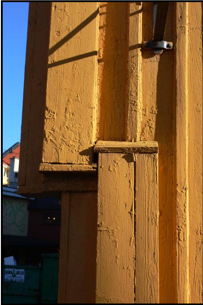
Utkraving av 2.etasje til ”påbygget”
