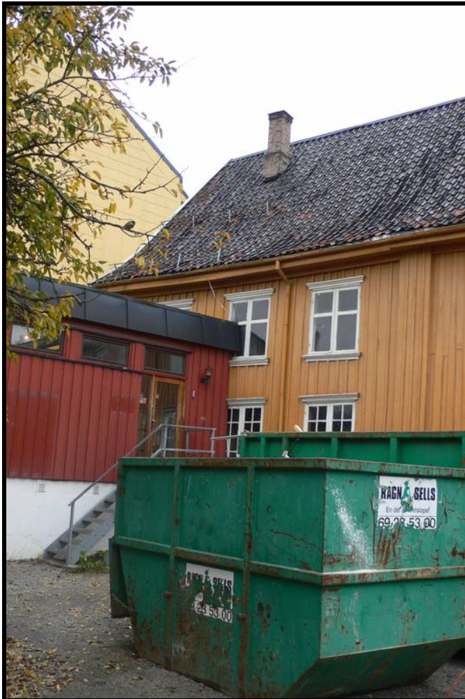
Moderne tilbygg på nordvest hjørne
