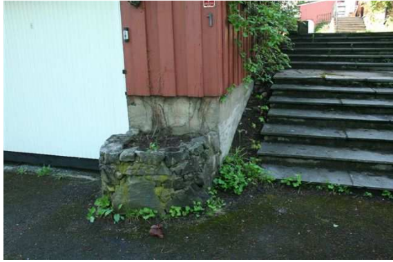
Oppmurt bed ved garasje
