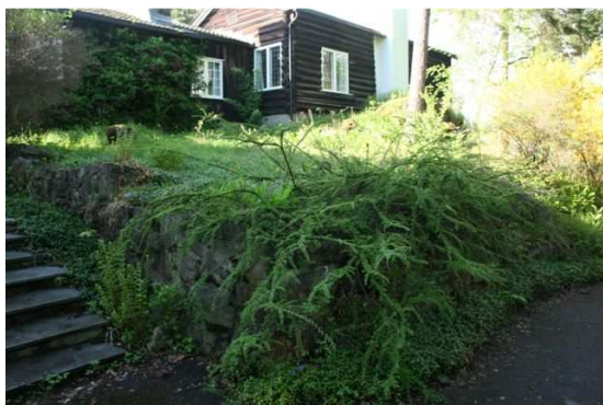
Forstøtningsmur til høyre for atkomsttrapp.
