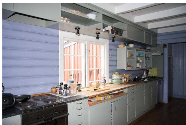
Over: Fra kjøkkenet, blant annet med nyere overskap. Skille mellom opprinnelig tømmervegg og tilbygg fra 1940 ved stolpe i bakgrunnen.
