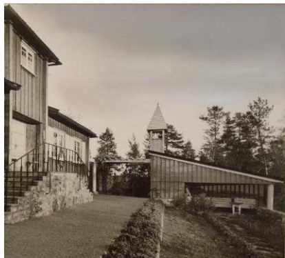
Hovedinngangen og hagen fotografert av K Teigen i 1944.
