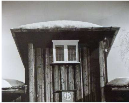
Gamle renner på tunsiden av tårn og et lite parti av renne på hver side av inngangsdør.
