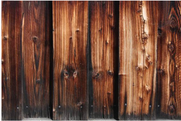
Fra yttervegg ved hovedinngangen.
