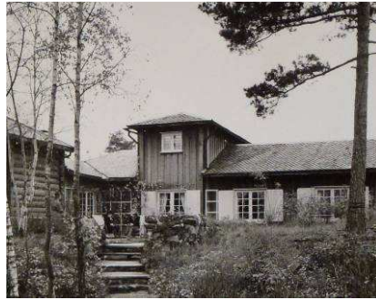
Gammel kilrenne på sjøsiden og gamle nedløp med skarpe bend fra tårn.
