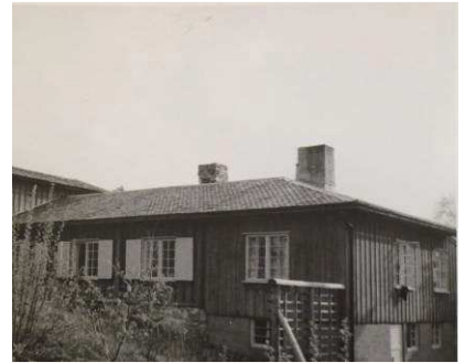
Tidligere utførelse av piper over tak på nordre del av boligen.
