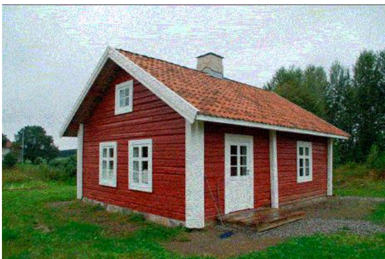
Bryggerhuset ferdig istandsatt, foto Omar Wiker
