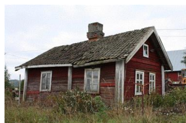
Bryggerhuset før istandsetting
