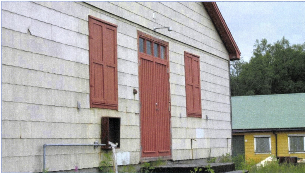
Del av fasaden på isolatbrakkka 003, i bakgrunnen lagerbygg 004.
