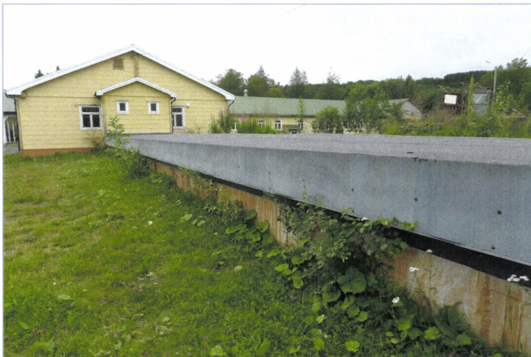
I forkant taket på kjelleranlegget/bunkersen som går inn under hovedbygningen.
