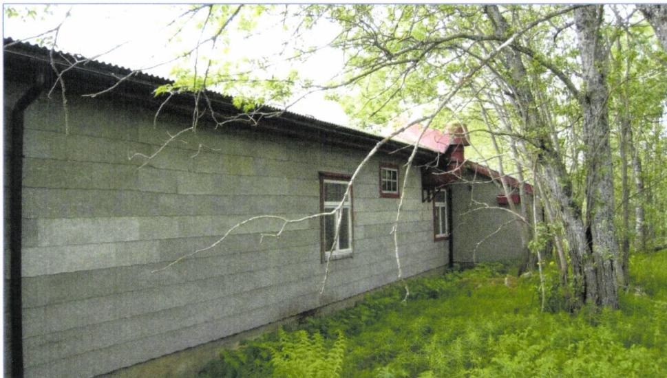
Garasjens bakside, med påbygg for kompressor på bygningens vestlige del.
