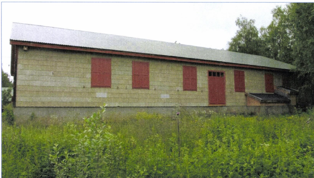
Isolatbrakkka med østlig fasade, nylig utbedret kjellerinngang til høyre.
