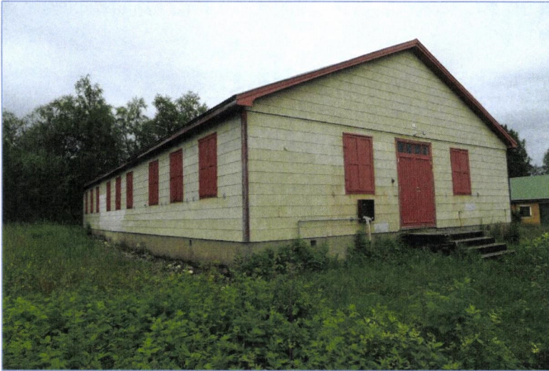
Isolatbrakka mot nordøst.
