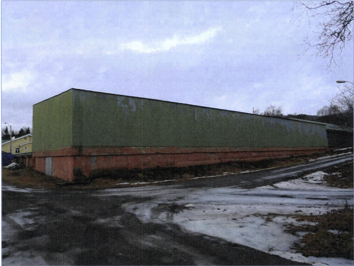
Garasjeanleggets bakside, bilde tatt mot nordvest.
