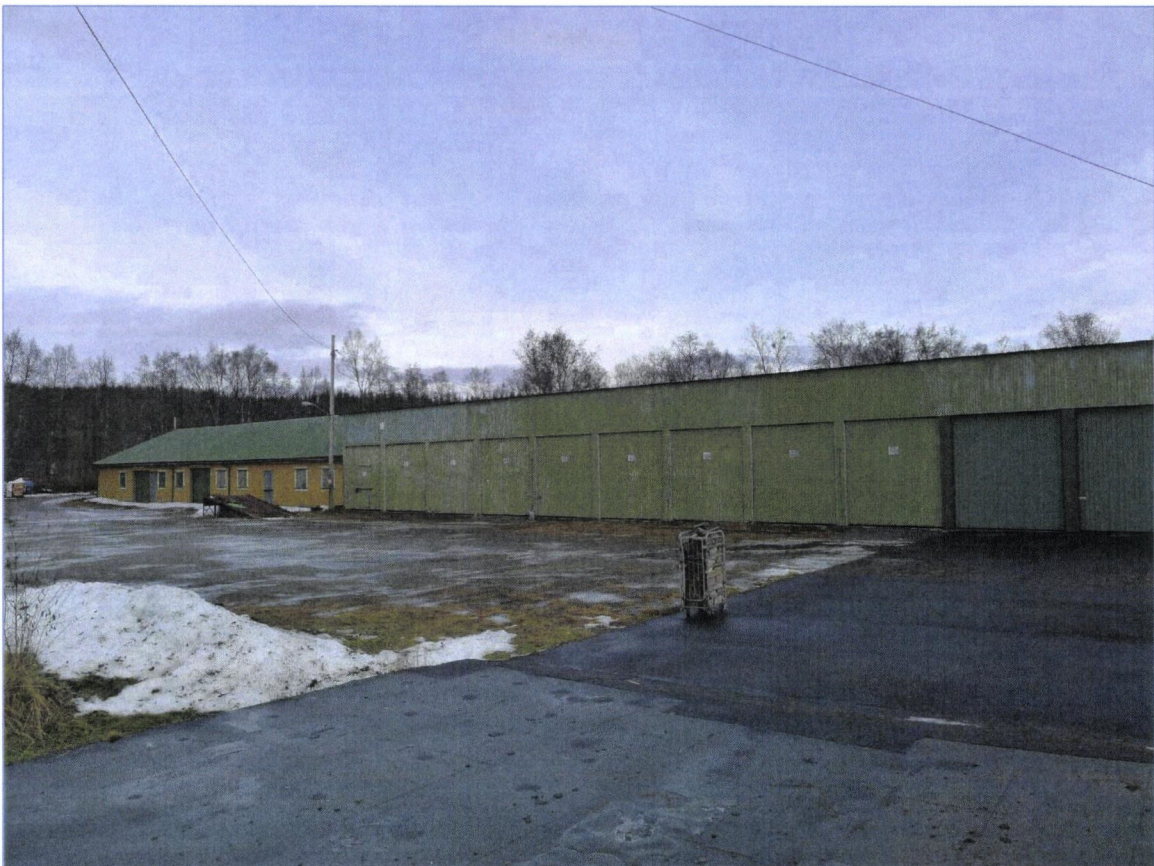
Til venstre den gule lagerbygningen, til høyre er garasjen med de 13 garasjeportene.
