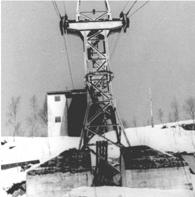
Øvre stasjon sett fra vogn i 1939. Trekonstruksjonen for vognrommet ses tydelig. Foto: Anders Beer Wilse
