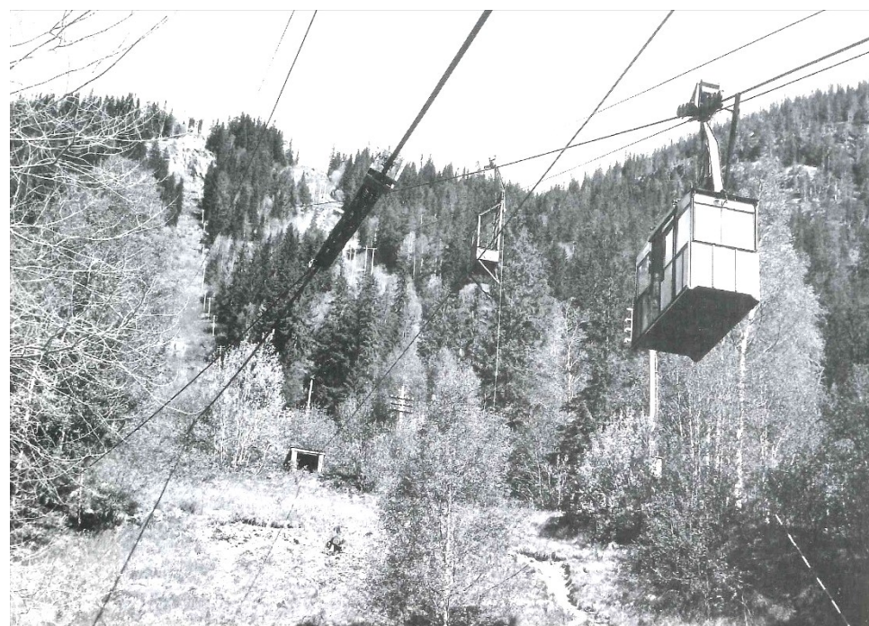
Redningskabelen med bod for maskineri i bruk. Foto: Norsk Industrierbeidermuseum.
