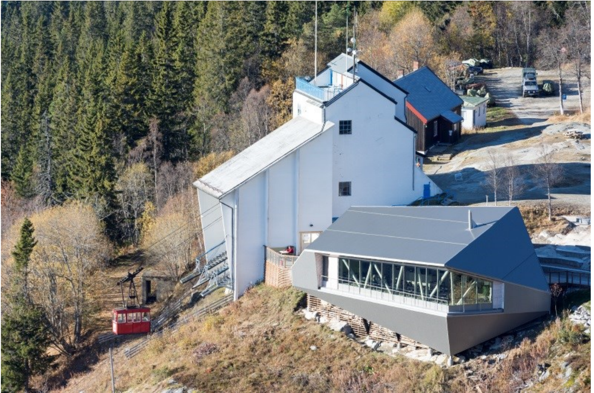
Øvre stasjon sett fra øst. Foto: Per Berntsen.
