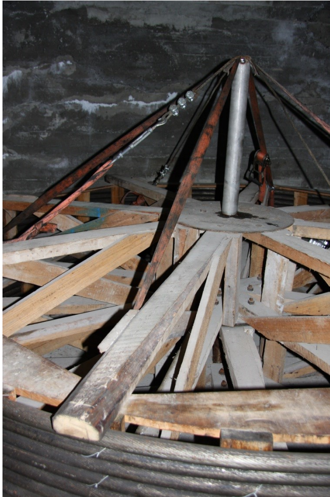
2.4.1 Hjul for reservetau ses til høyre.
