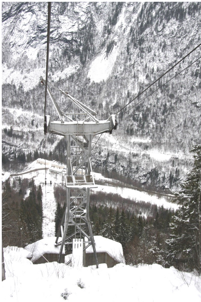
Bæremasten sett fra Øvre stasjon.
