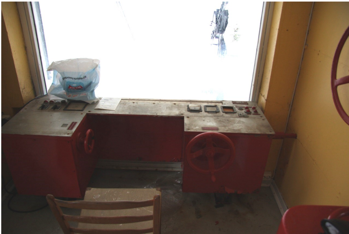
2.3.1 Styringspult fra 1950-årene og 2.3.2 opprinnelig bremsemaskineri og nøddriftshjul i den gamle drifts-sentralen/kontrollrommet.
