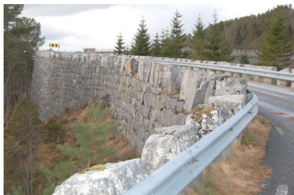
Figur 10. Veien sett fra sørøst mot Storestraumsbrua
