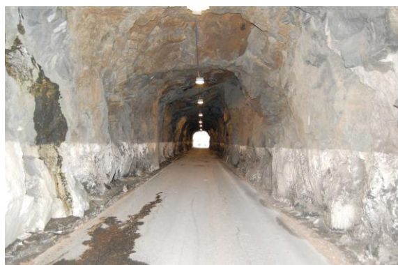
Figur 15. Innsiden av tunnelen sett fra nord
