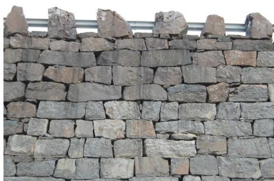
Figur 12. Veifylling utformet som forstøtningsmur av tørrmuret naturstein. Stabbeisteiner på toppen.
