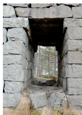
Figur 13. Gjennomgang i muren under kjørebanelen.
