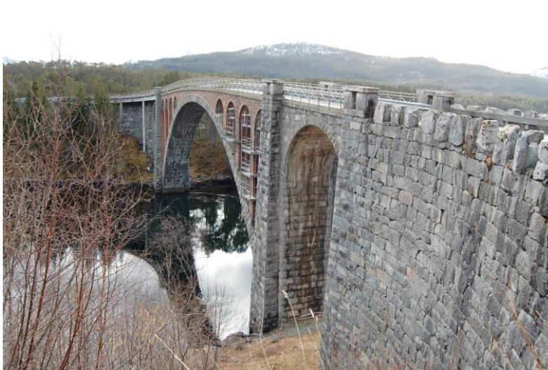
Figur 3. Storestraumsbrua sett fra nordøst.
