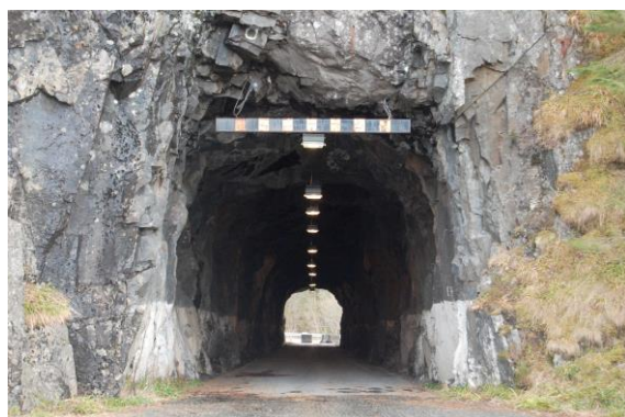
Figur 14. Tunnelinnslag fra nord
