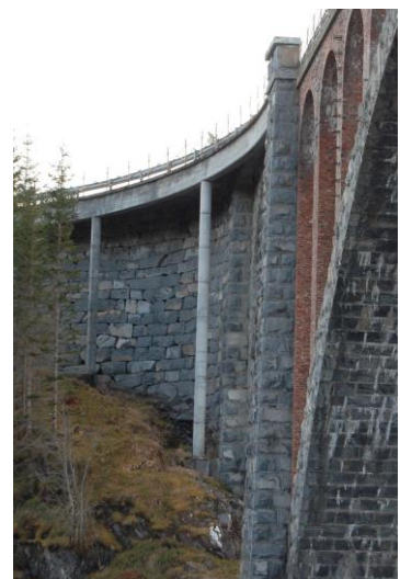
Figur 4. Utvidelse av kjørebane båret oppe av betongsøyler
