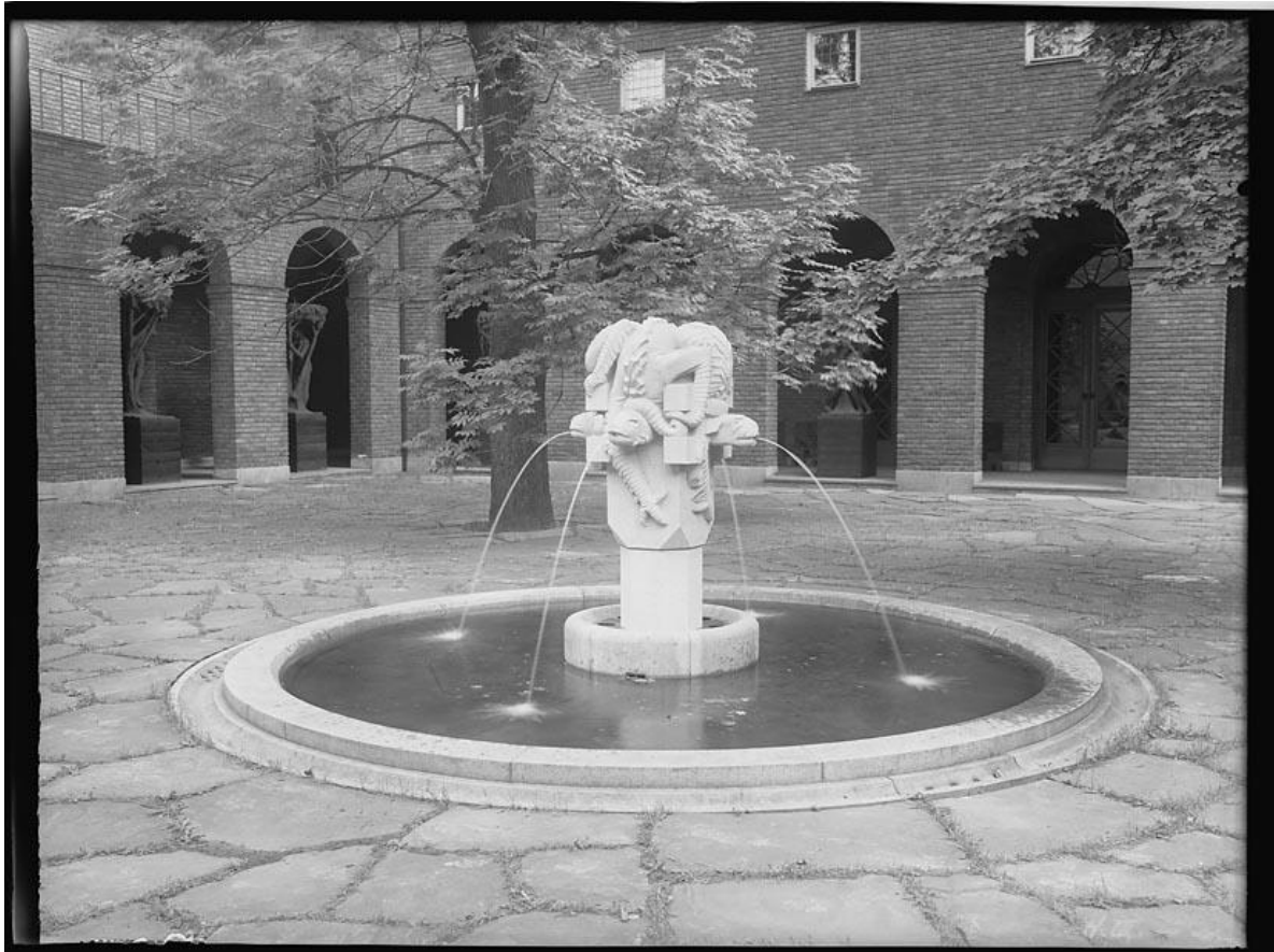
Fontenen midt i det lukkede gårdsrommet var friskluftinntak for hele bygningen. Foto: Vigelandmuseet
