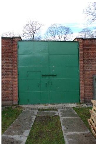
Adkomstport med innfelt gangdør.
