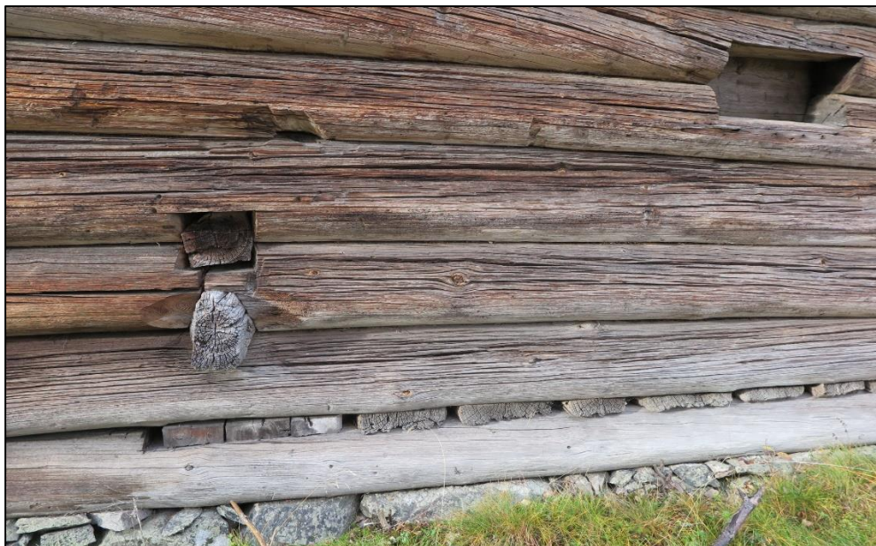
Figur 19. Gulvet ble skjøvet inn mellom tømmerstokkene slik at det kunne byttes ut og justeres etter behov. På veggens eksteriør visers også elementer fra ovnene og vindusgluggen, østre vegg. Foto: Hedmark Fylkeskommune, oktober 2019.
