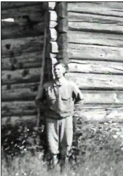
Figur 33. Nordre og vestre vegg, før rivning. Sannsynligvis er det rias siste eier Erling Revholt som er avbildet foran ria. Bildet er udatert. Glomdalsmuseets fotoarkiv.
