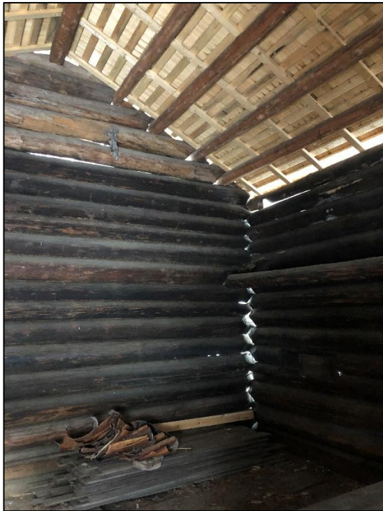
Figur 17. Ria interiør. Her sees det nye taket og en av de to langsgående åsene/mastene, som bær gulvet av rager hvor rugbåndene ble plassert under tørkingen. Foto: Glomdalsmuseet, 2019..
