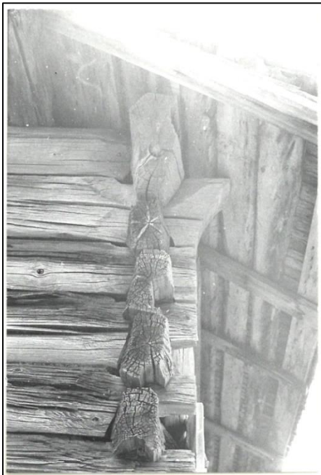
Figur 60. Sør-østre hjørne, før rivning. Dokumentet med innlimte fotografier datert 1970, merket med Revholt, gnr. 113/, Grue, B0022/371. Glomdalsmuseets fotoarkiv.
