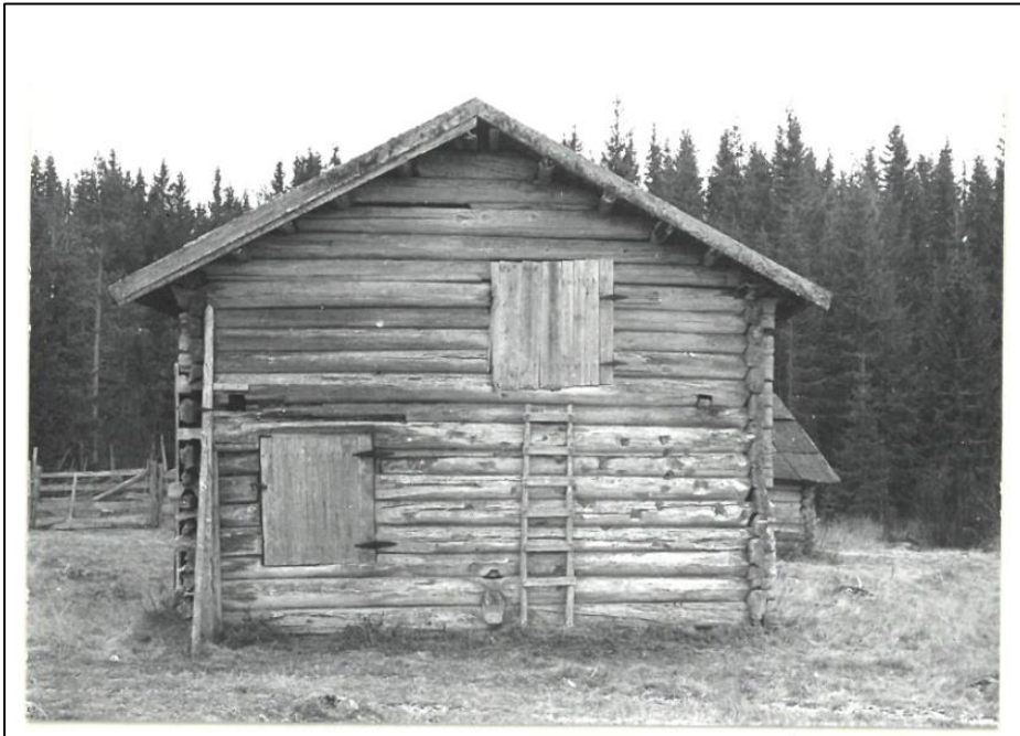
Figur 46. Nordre vegg, før rivning. Dokument med innlimte fotografier datert 1970, merket med Revholt, gnr. 113/, Grue, B0013/371. Glomdalsmuseets fotoarkiv.
