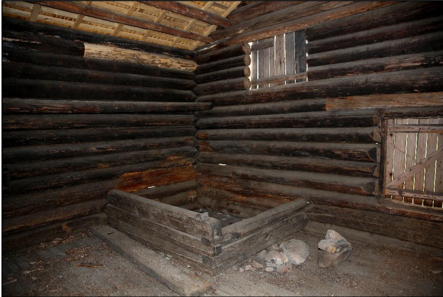
Figur 13. Rias sør-østre hjørne, rester av ovn. Ovnsbanken er trolig original. Ovnsbankens venstre vange er 190 cm lang, og den nordre vangen er 235 cm lang, selve ovnen har en grunnflate på 4,4, kvadratmeter. Foto Glomdalsmuseet, 2019.
