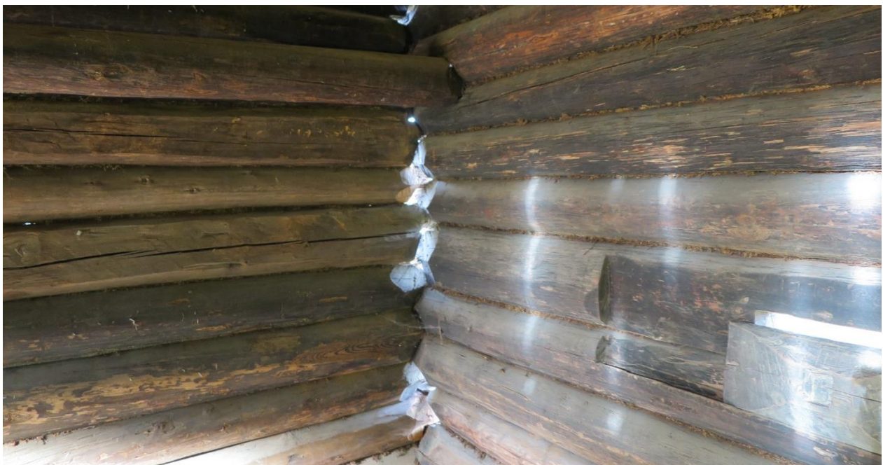
Figur 7. Vindusskoden som i dag er en del av ria ser ikke ut til å være den opprinnelige, da formatene ikke stemmer overens. Fotografiet viser at laftehjørnene er glisne og at ria er bygget av relativt grovt furutømmer. Det originale tømmeret er sort av sot. Foto: Hedmark Fylkeskommune ved Agnethe Jovall, oktober 2019.
