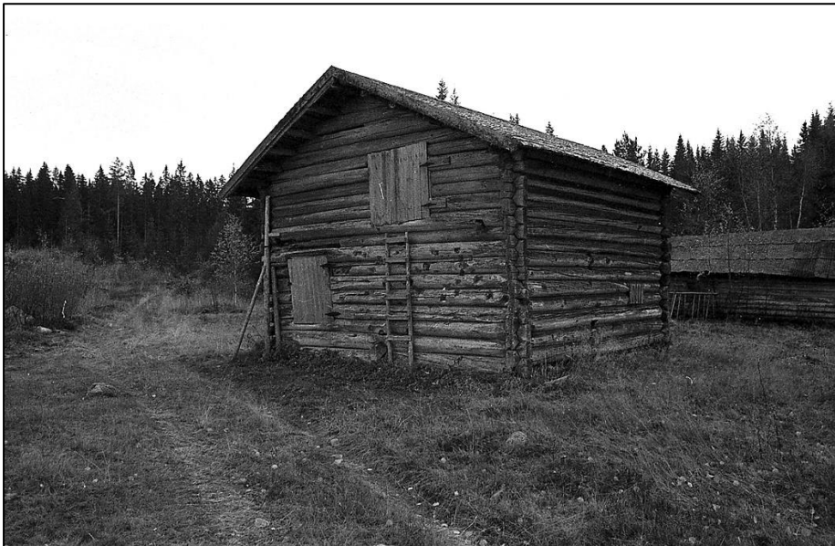
Figur 49. Nord-vestre vegg, før rivning på Revholtet. Anno Museum, arkiv.
