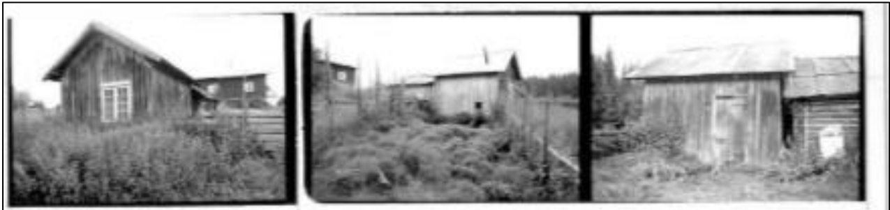
Figur 27. Hønsehus, byggeår 1928-29. Registrert av Birger Nesholen, 26.07.1979, SEFRAK-nr. 04230022034.
