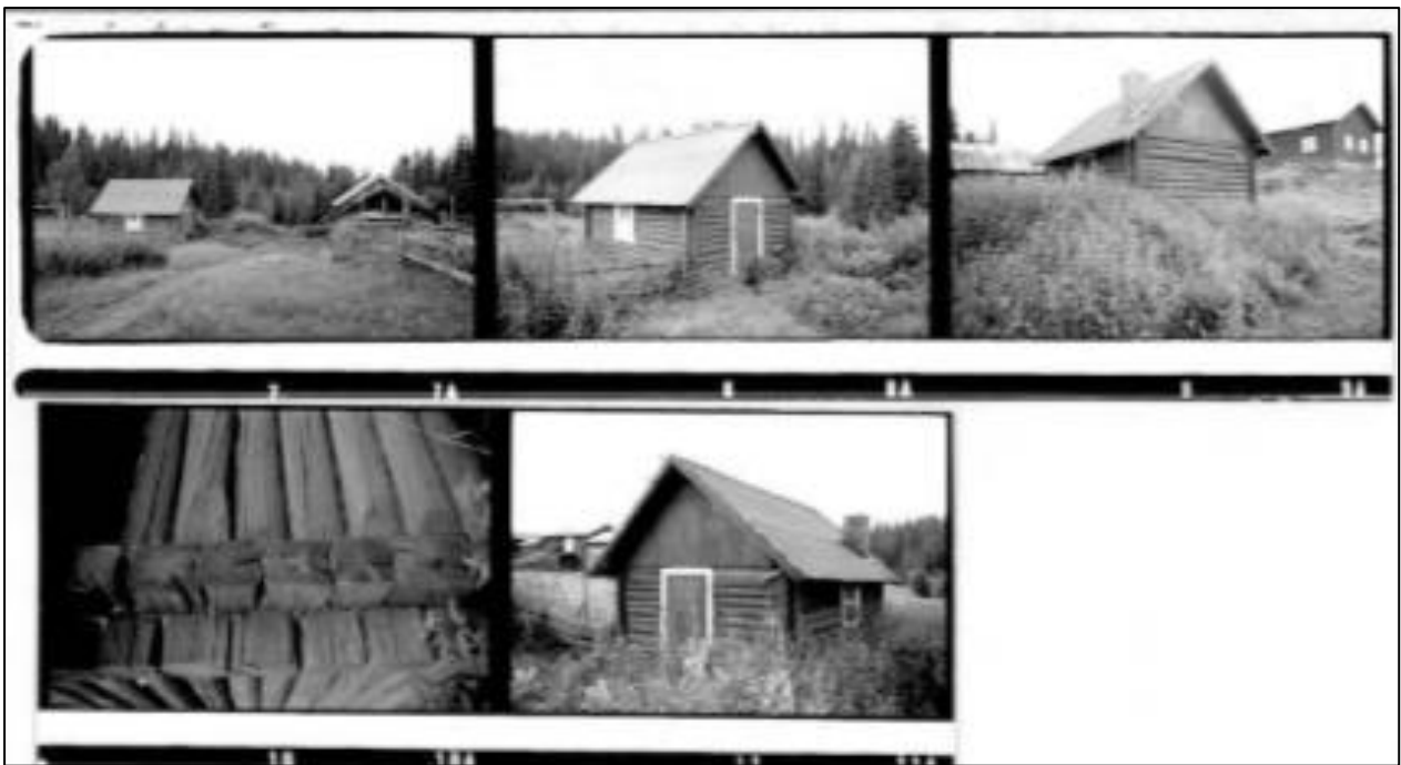
Figur 28. Bryggerhus. Byggeår 1950. Registrert av Birger Nesholen, 26.07.1979, SEFRAK-nr. 04230022032.
